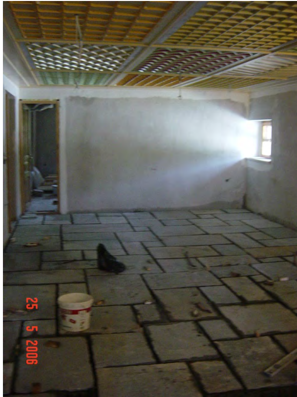
Φωτογραφία 157: Διάστρωση δαπέδου με σχιστόπλακα
