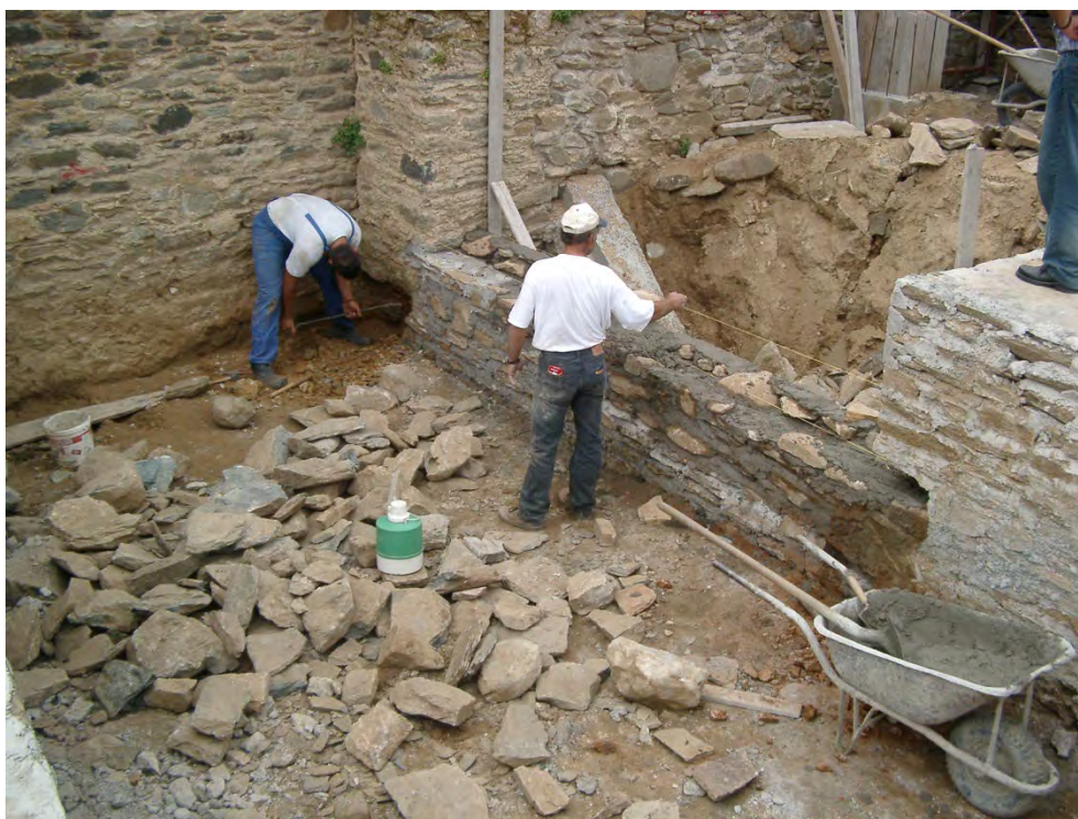
Φωτογραφία 29: Δομήσεις λιθοδομών ισογείου
