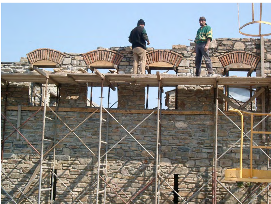
Φωτογραφία 40: Δομήσεις λιθοδομών ορόφου
