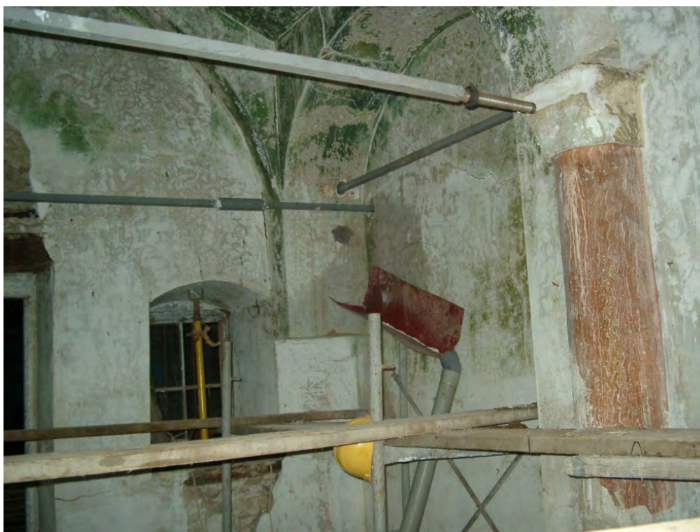
Φωτογραφία 118: Τοποθέτηση μεταλλικών ελκυστήρων
