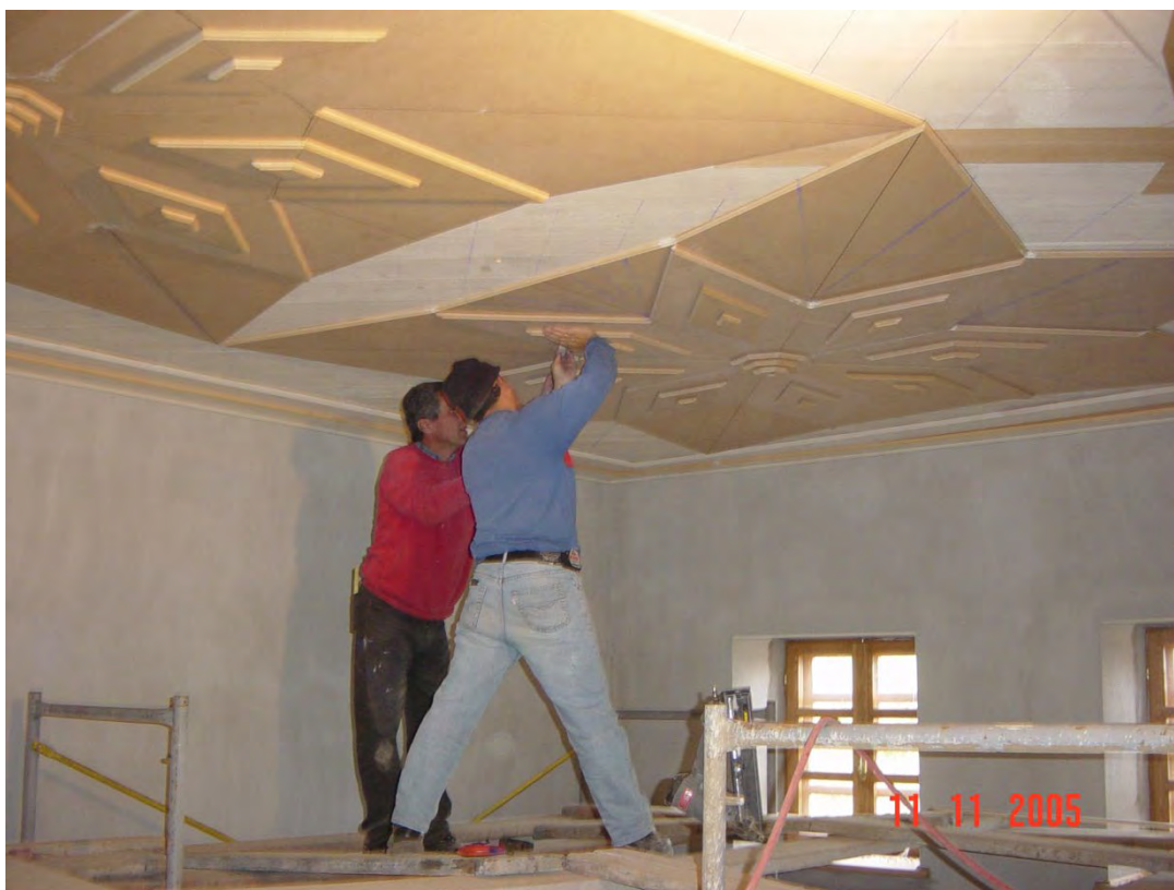
Φωτογραφία 163: Κατασκευή σχεδίου περίτεχνου ταβανώματος
