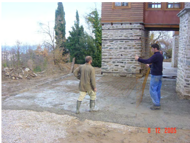
Φωτογραφία 171: Διάστρωση σκυροδέματος με δομικό πλέγμα
