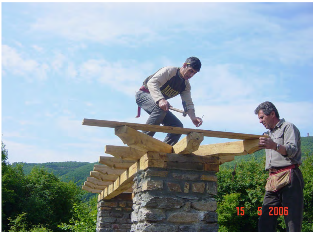
Φωτογραφία 174: Κατασκευή πεσσών και παραδοσιακού στεγάστρου καγκελόπορτας
