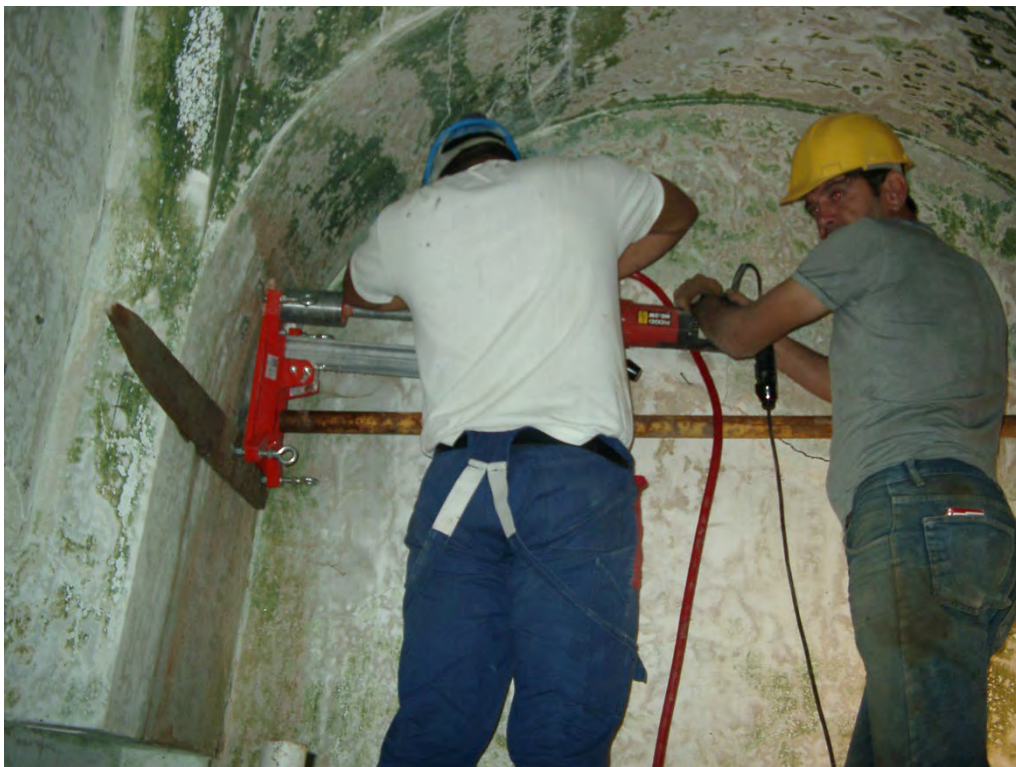
Φωτογραφία 116: Διάτρηση λιθοδομών
