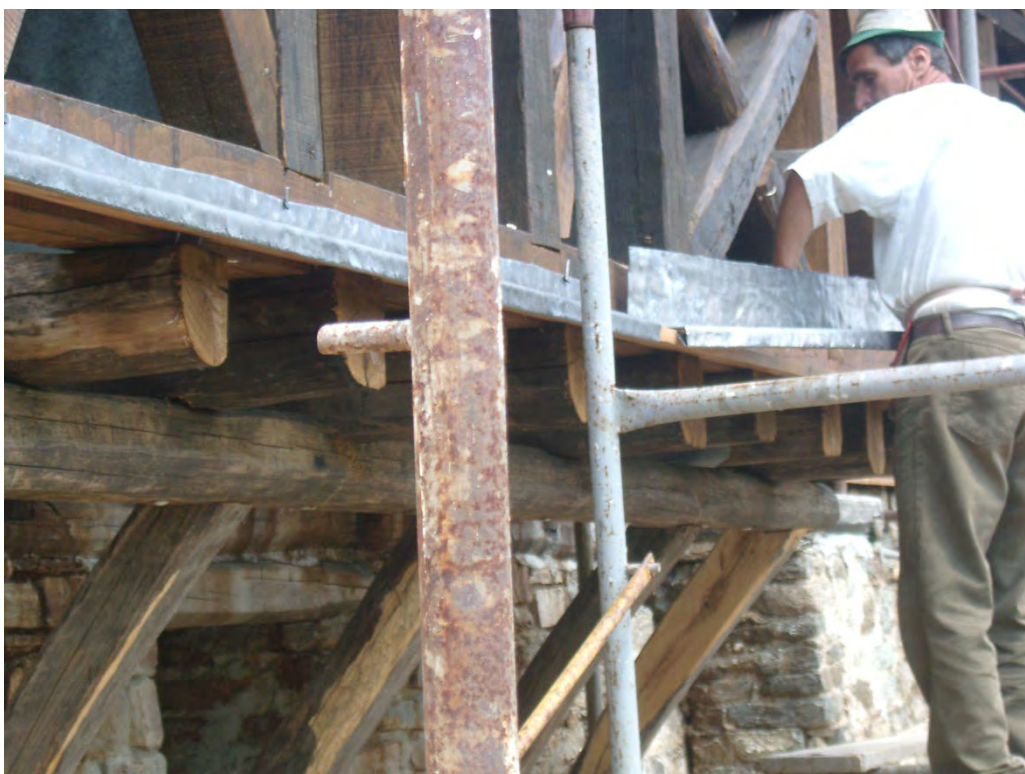
Φωτογραφία 93: Τοποθέτηση προστατευτικών φύλλων μολυβιού
