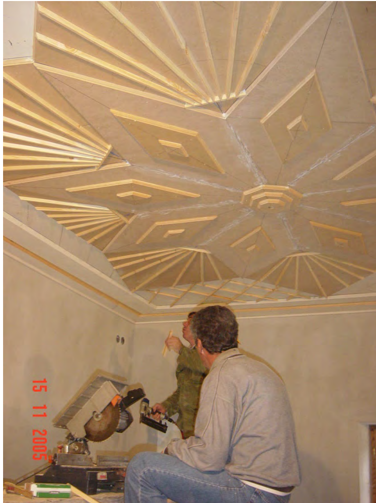
Φωτογραφία 165: Κατασκευή σχεδίου περίτεχνου ταβανώματος
