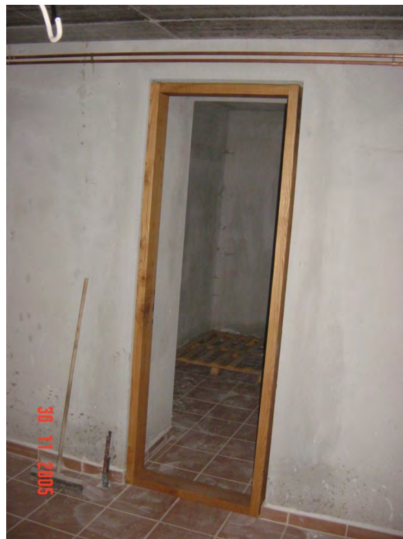
Φωτογραφία 156: Διάστρωση δαπέδου με κεραμικά πλακίδια
