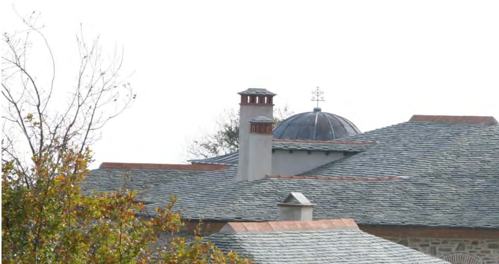
Φωτογραφία 85: Επικάλυψη στέγης εκκλησίας με φύλλο μολυβιού
