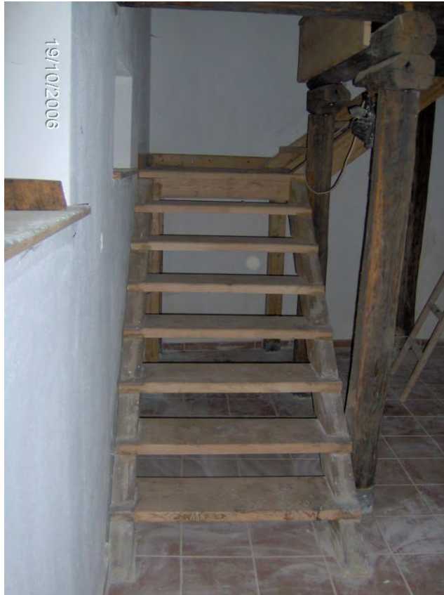
Φωτογραφία 159: Κατασκευή ξύλινης σκάλας
