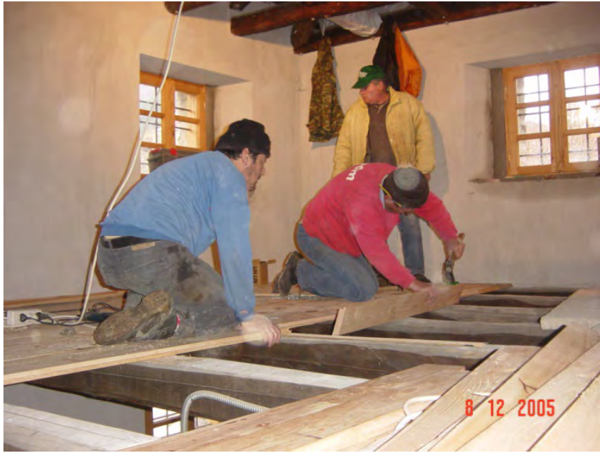
Φωτογραφία 151: Τοποθέτηση ξύλινων πατωμάτων
