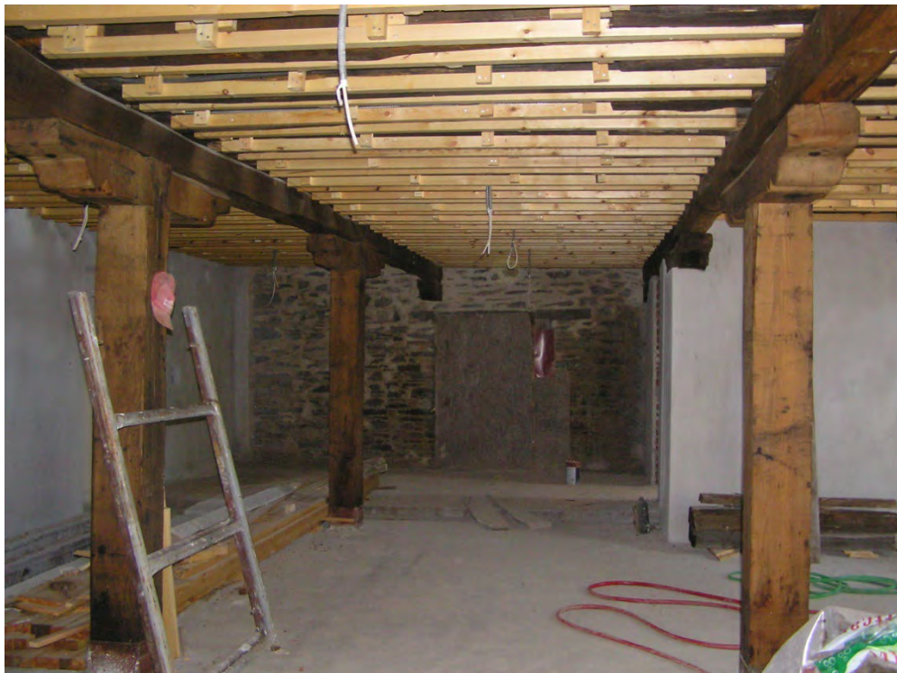
Φωτογραφία 98: Εσωτερικά επιχρίσματα (Τελικό)
