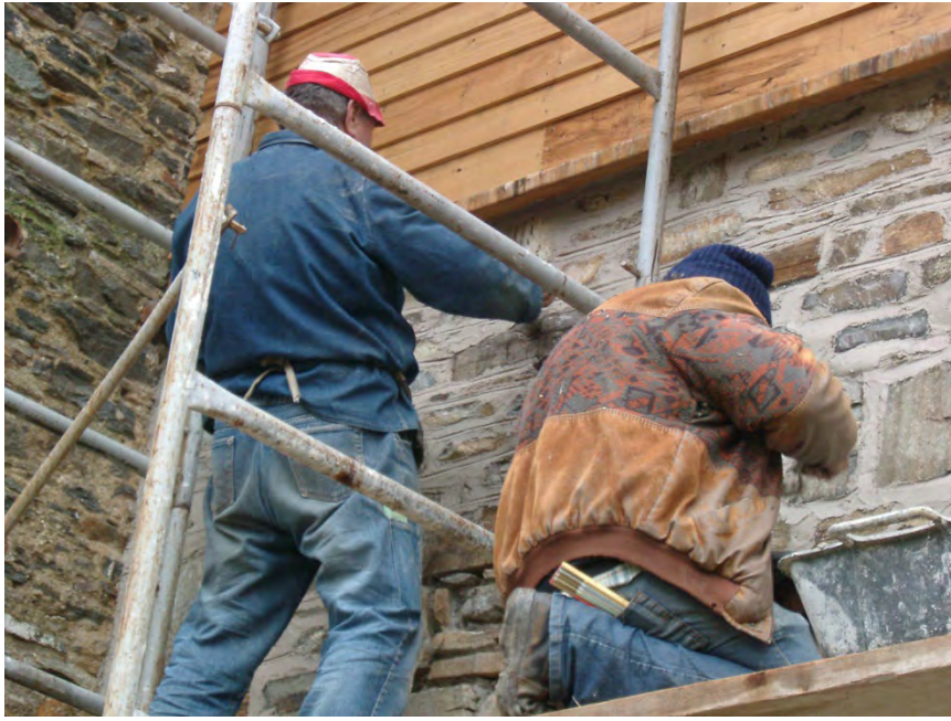
Φωτογραφία 77: Κατά την διάρκεια του αρμολογήματος
