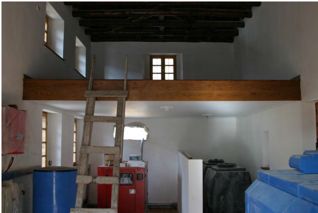
Φωτογραφία 184: Πατάρι και διαχωριστικοί τοίχοι λεβητοστασίου
