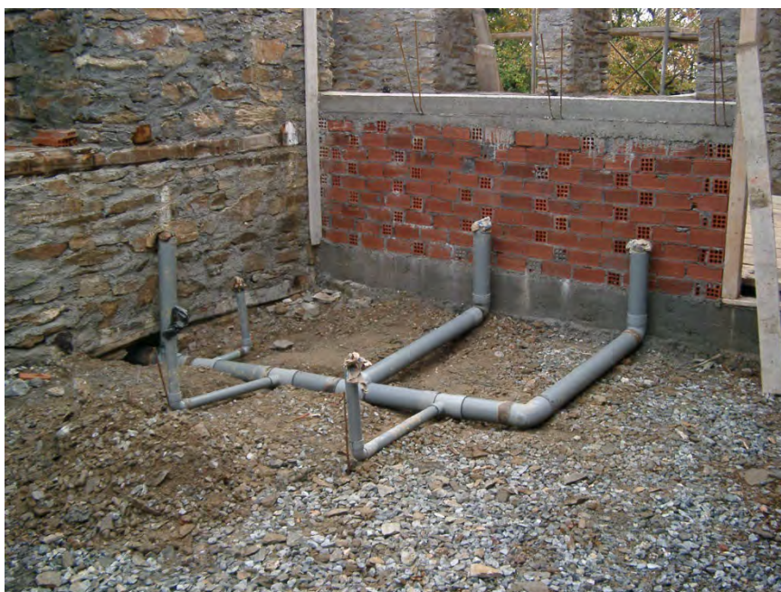
Φωτογραφία 34: Σωληνώσεις αποχετεύσεων-Πλινθοδομές
