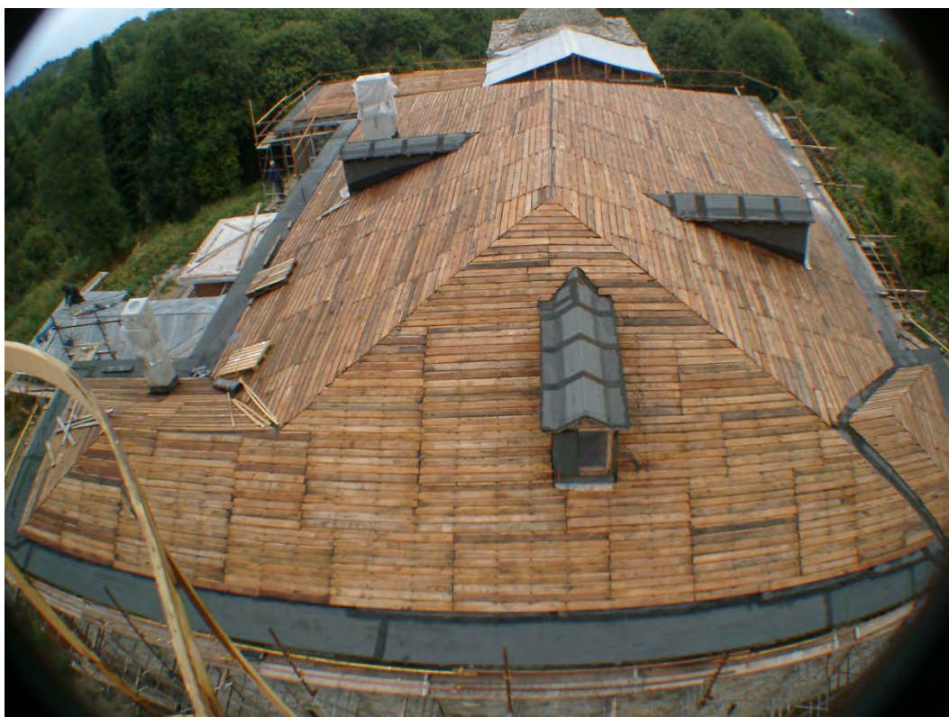
Φωτογραφία 73: Πέτσωμα στέγης ολοκληρωμένο
