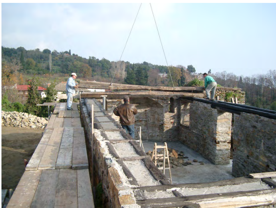
Φωτογραφία 36: Ξύλινοι σκελετοί πατωμάτων
