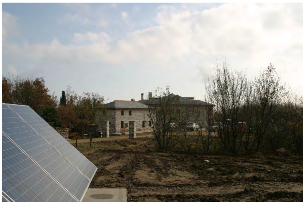
Φωτογραφία 180: Τοποθέτηση φωτοβολταϊκών πάνελ
