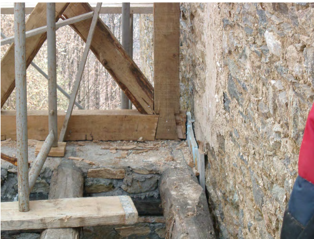
Φωτογραφία 48: Κατασκευαστική λεπτομέρεια ξύλινων σκελετών τοίχων
