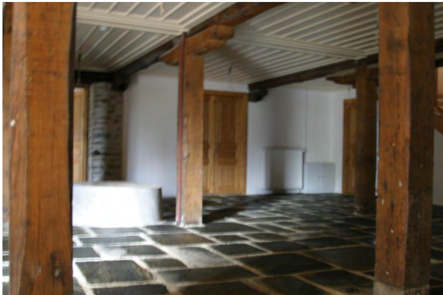
Φωτογραφία 198: Σάλα ισογείου (Ολοκληρωμένο)
