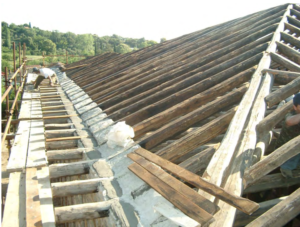
Φωτογραφία 64: Λεπτομέρεια ξύλινου σκελετού στέγης
