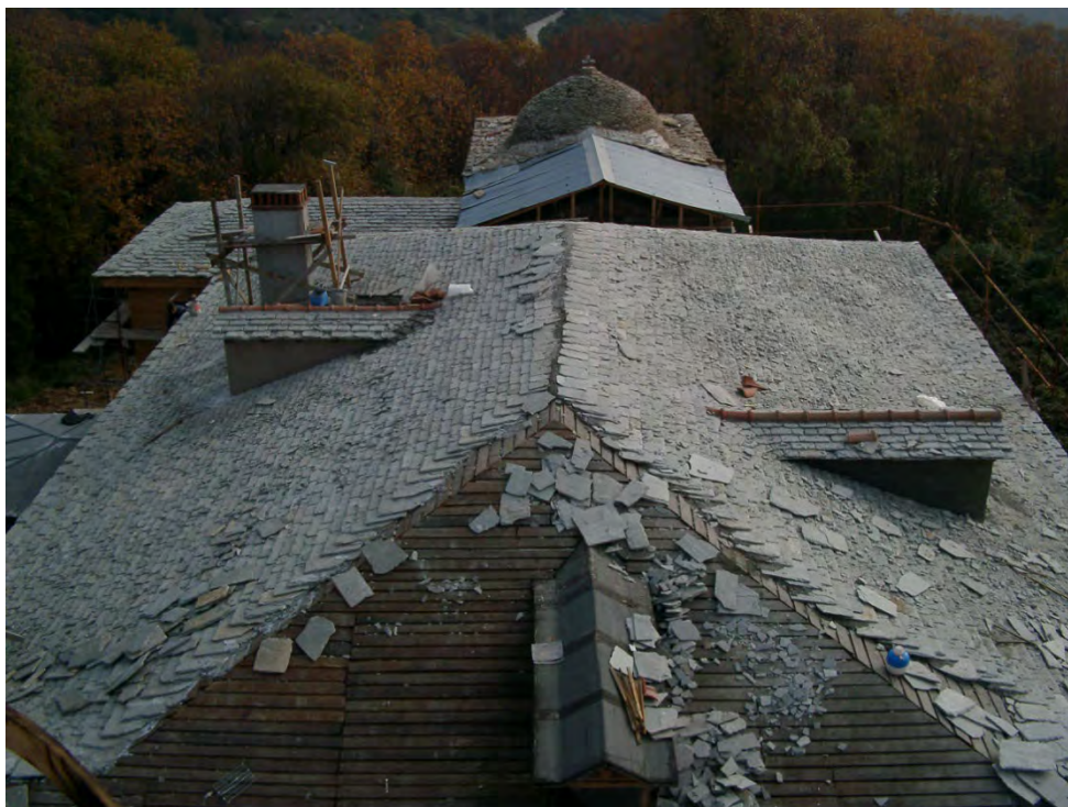
Φωτογραφία 81: Διάστρωση σχιστόπλακας στέγης
