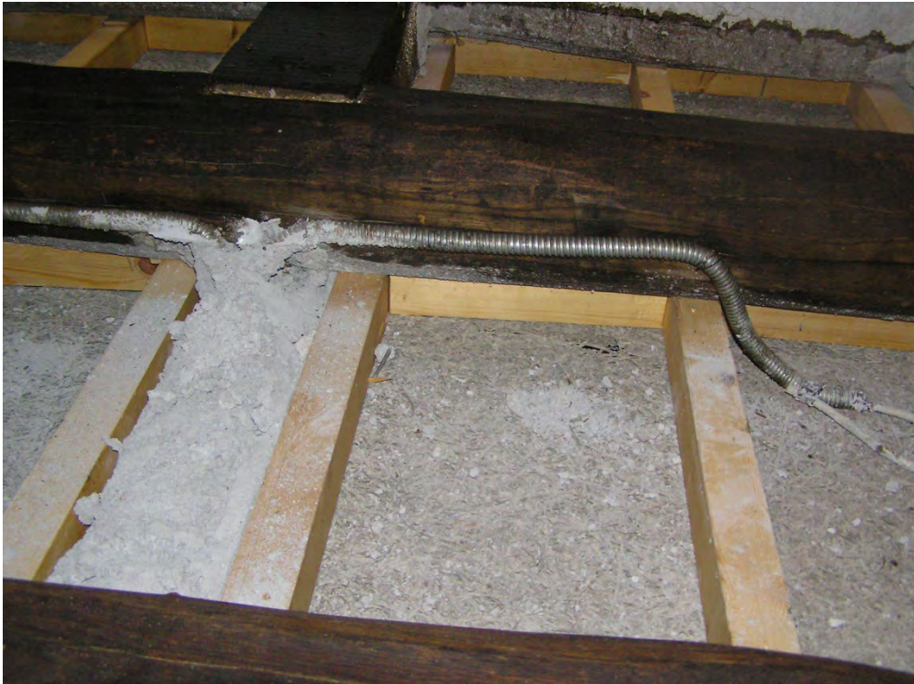
Φωτογραφία 131: Καδρονιαρίσματα οροφών - Τοποθέτηση Ηρακλίτη
