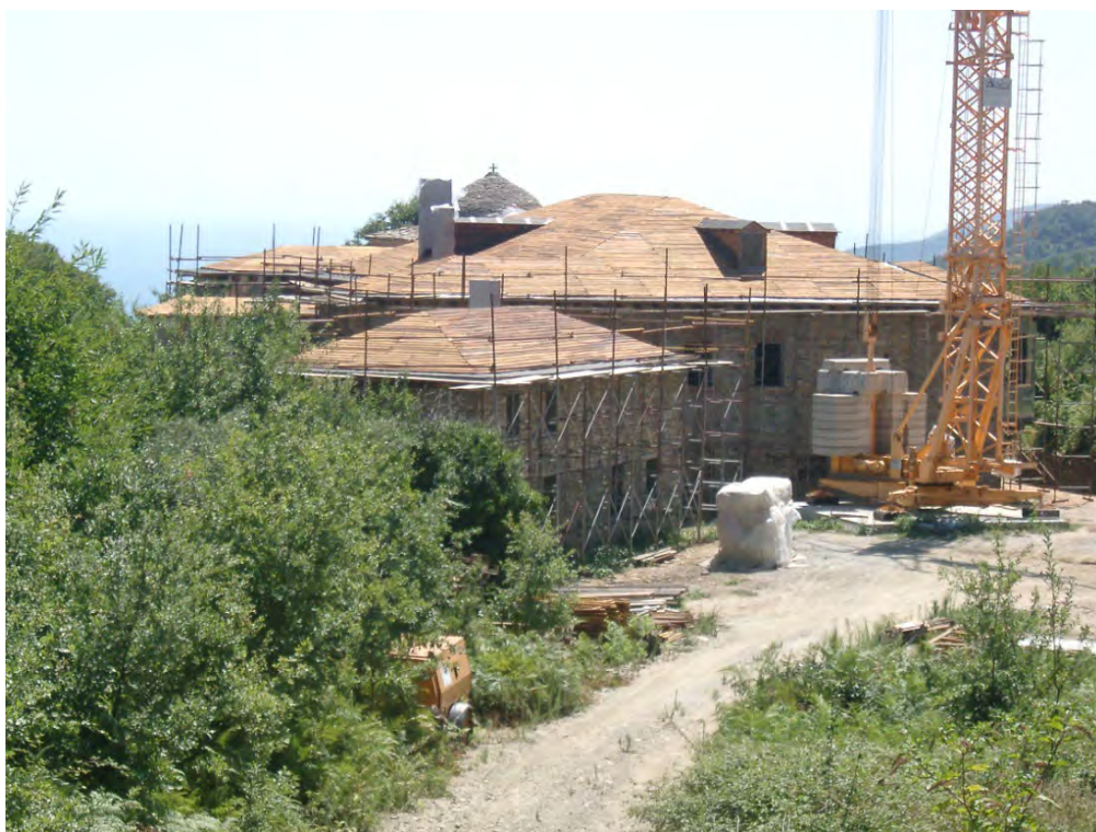
Φωτογραφία 74: Πετσώματα στεγών ολοκληρωμένα
