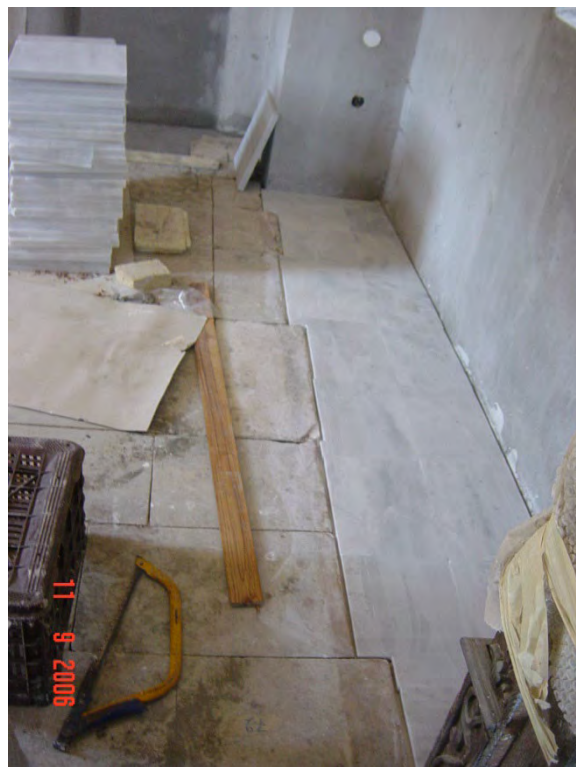
Φωτογραφία 126: Αποκατάσταση δαπέδου με νέες μαρμάρινες πλάκες
