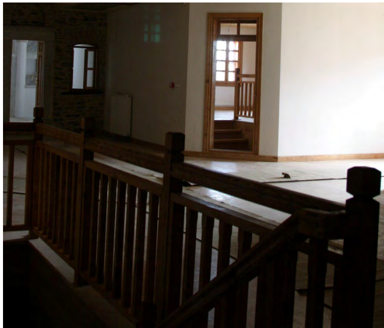
Φωτογραφία 160: Ξύλινο κιγκλίδωμα σκάλας
