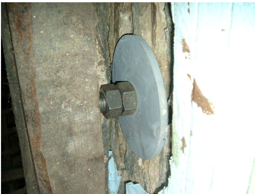
Φωτογραφία 119: Δίσκος στερέωσης μεταλλικού ελκυστήρα
