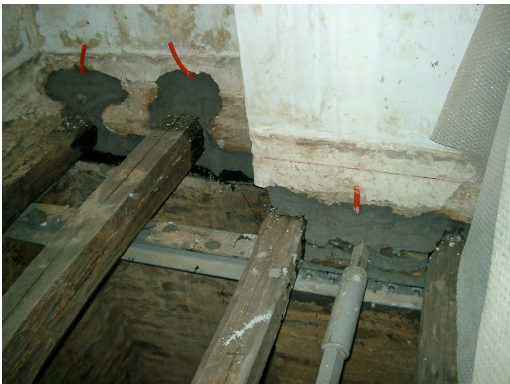
Φωτογραφία 120: Τοποθέτηση νέων πατόξυλων
