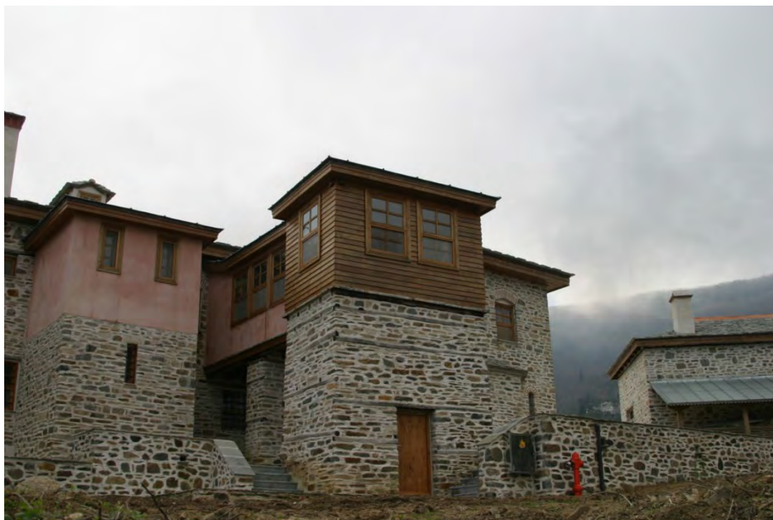
Φωτογραφία 212: Βόρεια όψη του Αντιπροσωπείου (Ολοκληρωμένο)
