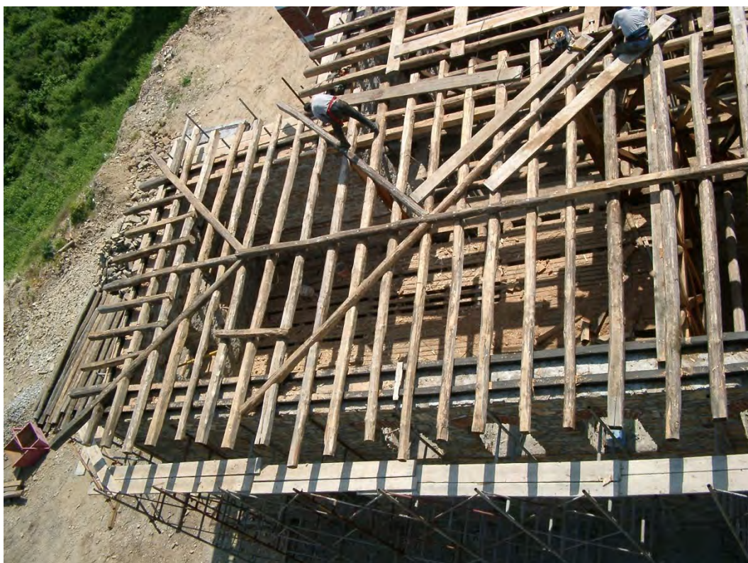
Φωτογραφία 55: Ξύλινος σκελετός στέγης
