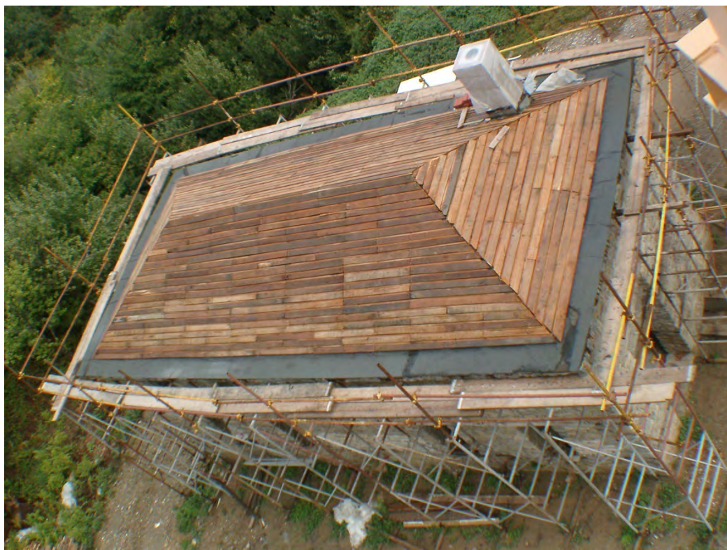
Φωτογραφία 72: Πέτσωμα στέγης ολοκληρωμένο
