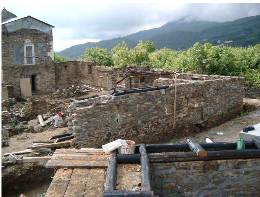
Φωτογραφία 31: Δομήσεις λιθοδομών-Ξύλινα σενάζ λιθοδομών
