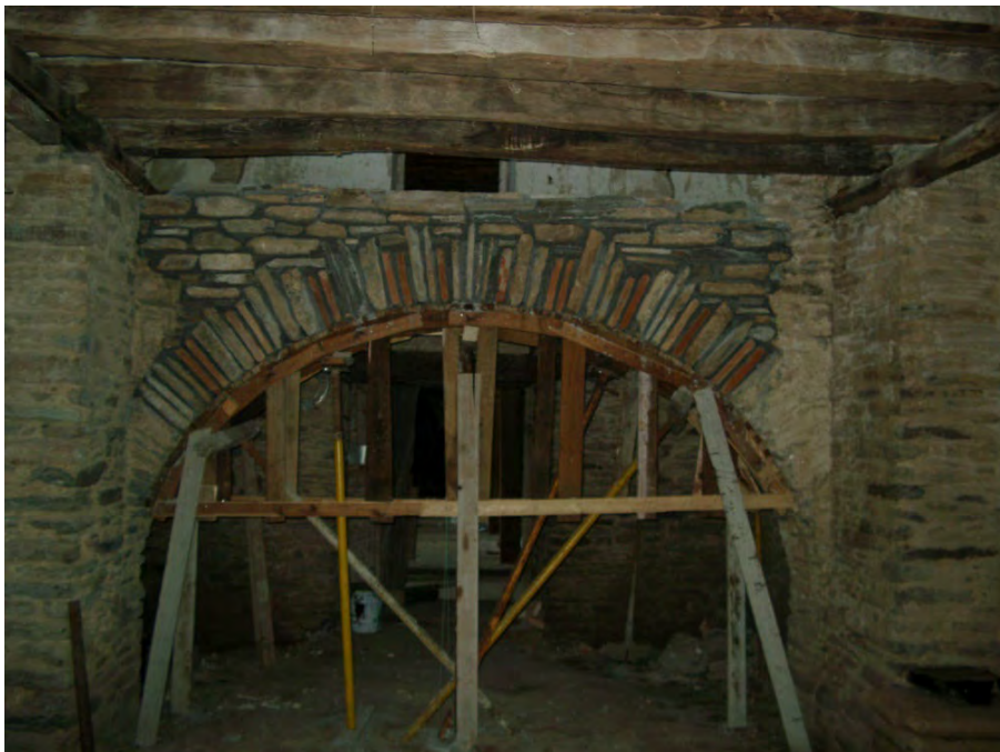
Φωτογραφία 114: Αναδόμηση τόξου
