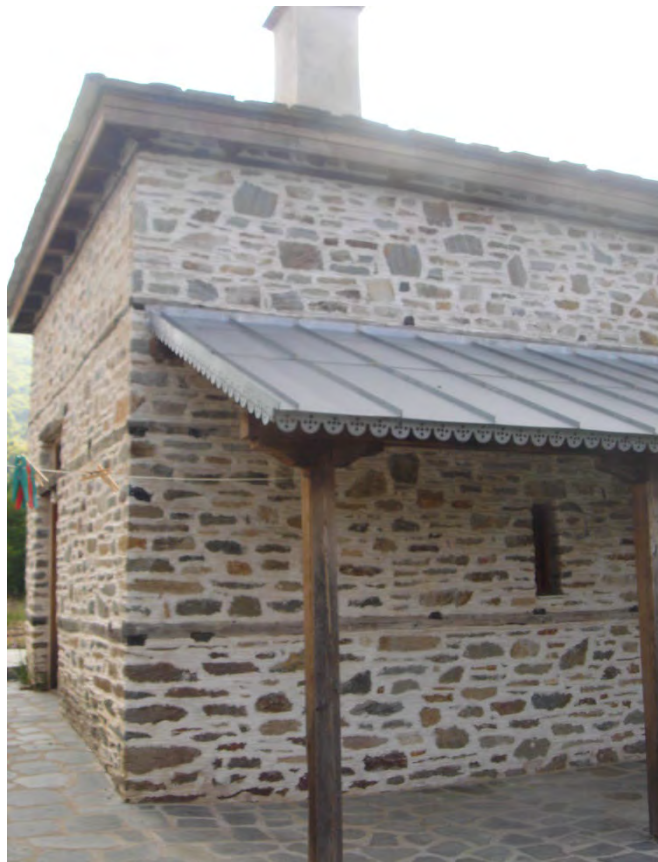
Φωτογραφία 186: Επικάλυψη στεγάστρου με λαμαρίνα
