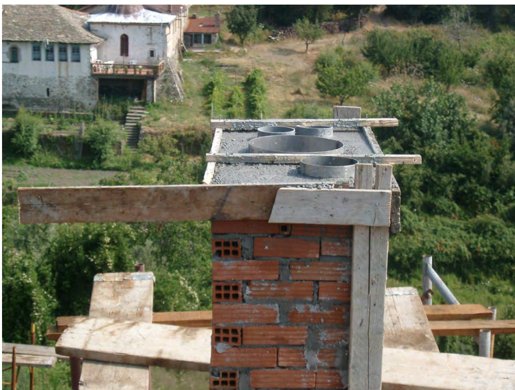
Φωτογραφία 69: Δόμηση καμινάδας
