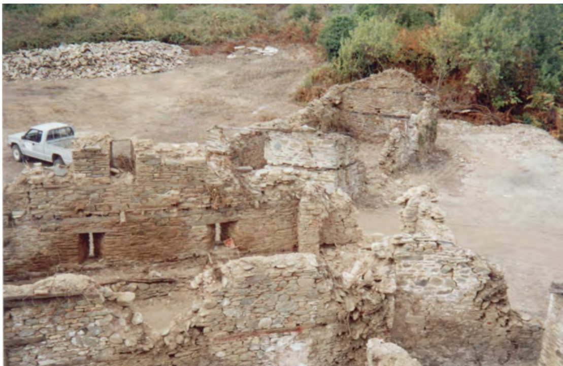
Φωτογραφία 20: Μετά τον καθαρισμό
