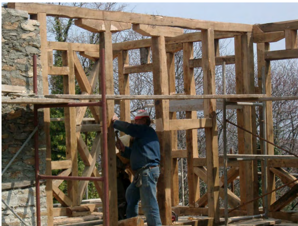
Φωτογραφία 44: Ξύλινοι σκελετοί τοίχων
