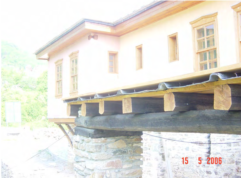
Φωτογραφία 187: Κατασκευή απλωταριάς
