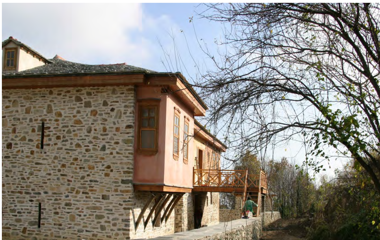
Φωτογραφία 208: Δυτική και Νότια όψεις του Αντιπροσωπείου (Ολοκληρωμένο)
