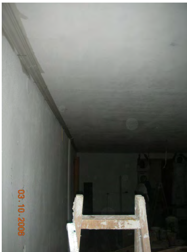
Φωτογραφία 169: Ψευδοροφή τσιμεντοσανίδας με γύψινη κορνίζα
