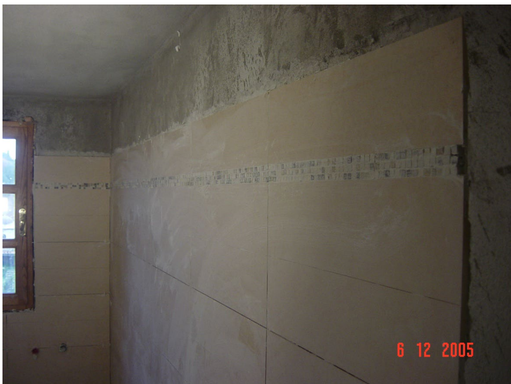
Φωτογραφία 105: Τοποθέτηση κεραμικών πλακιδίων
