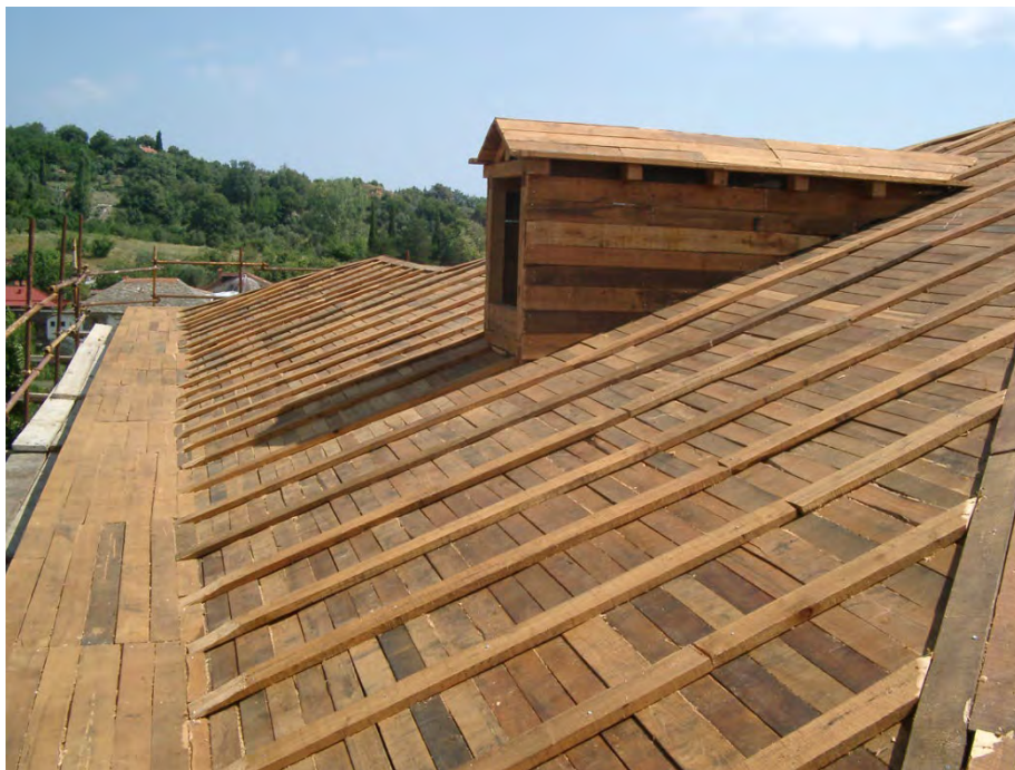
Φωτογραφία 66: Πέτσωμα στέγης (Πρώτο)-Φεγγίτης
