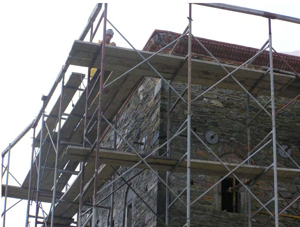
Φωτογραφία 86: Επισκευή γειώματος με συμπαγείς κεραμικές πλάκες
