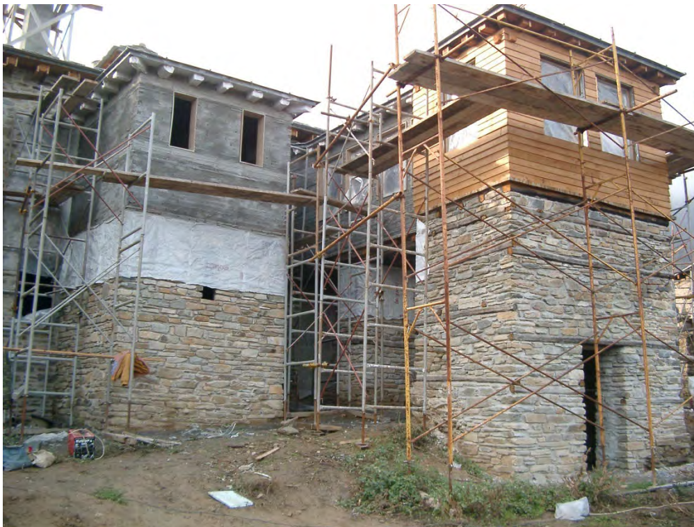
Φωτογραφία 99: Εξωτερικά επιχρίσματα (Πρώτο χέρι)
