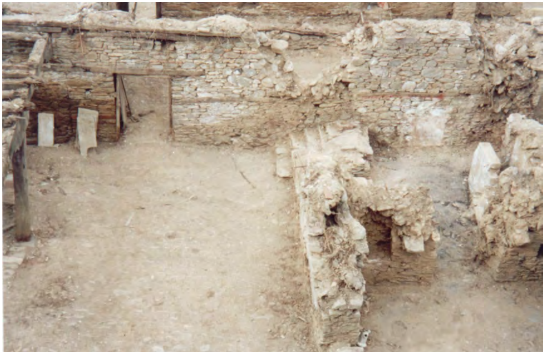
Φωτογραφία 19: Μετά τον καθαρισμό
