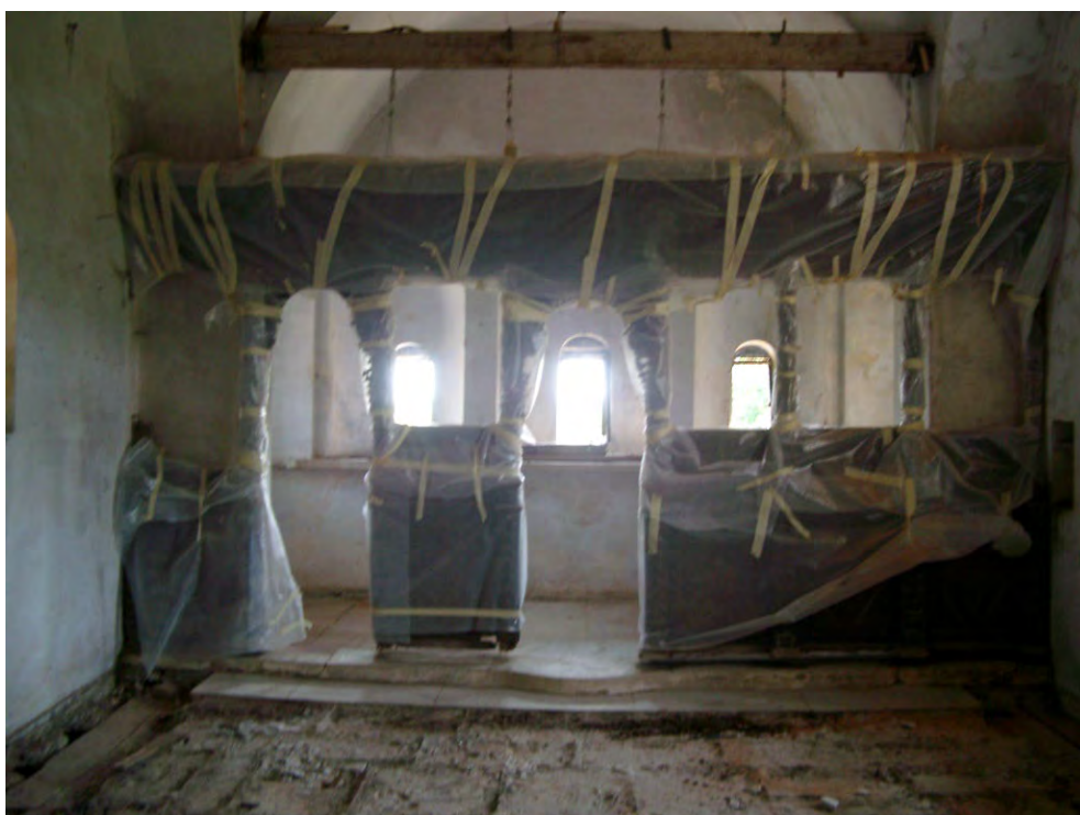
Φωτογραφία 112: Ανάρτηση τέμπλου - Αποξήλωση μαρμάρινου δαπέδου
