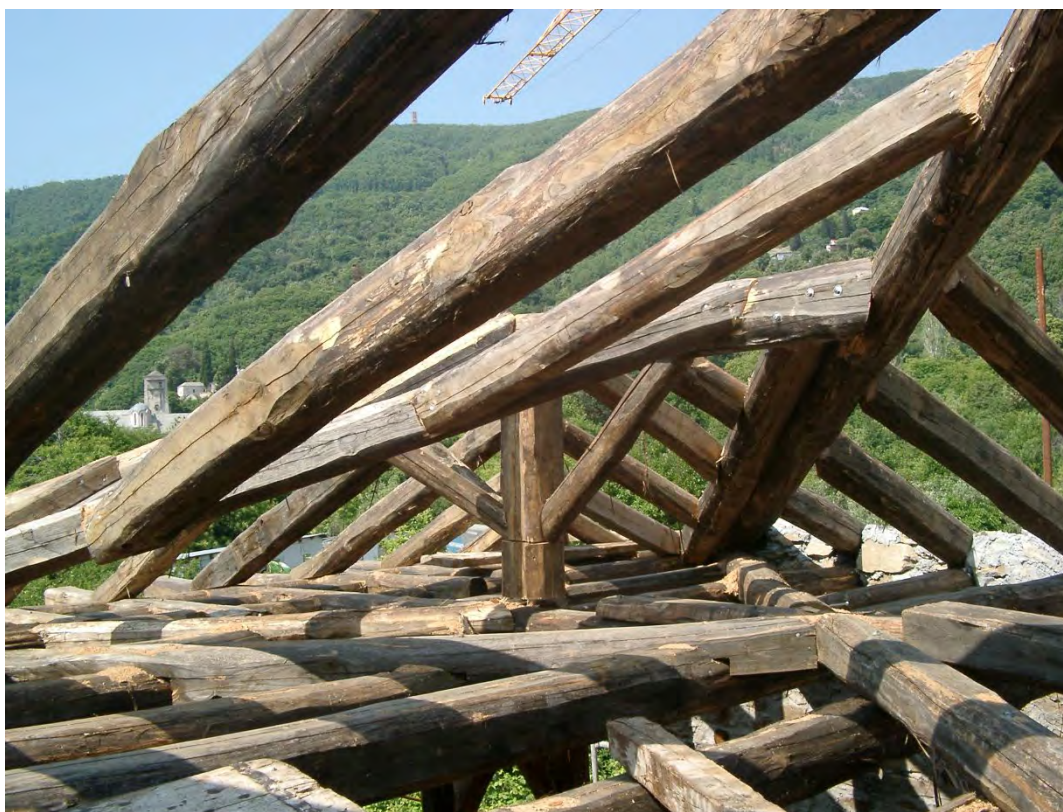
Φωτογραφία 62: Λεπτομέρεια ξύλινου σκελετού στέγης
