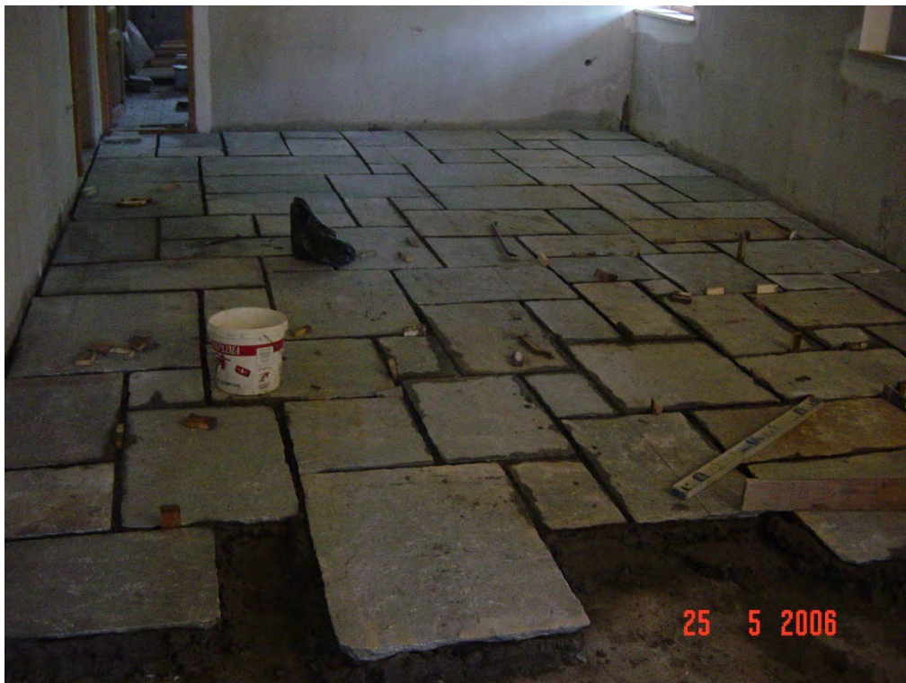
Φωτογραφία 132: Διάστρωση δαπέδου με σχιστόπλακα
