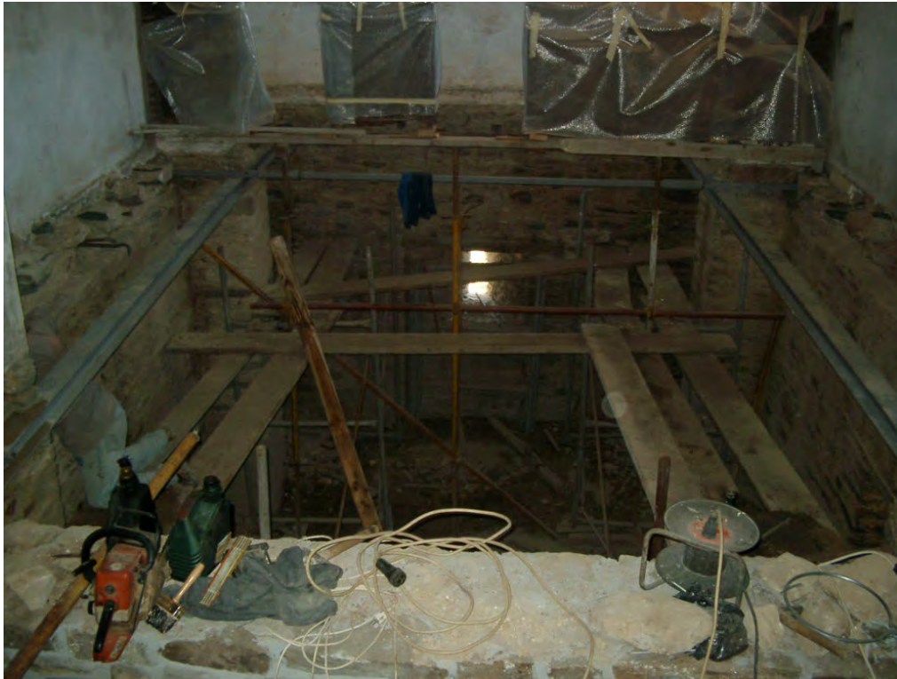
Φωτογραφία 115: Μεταλλικές δοκοί
