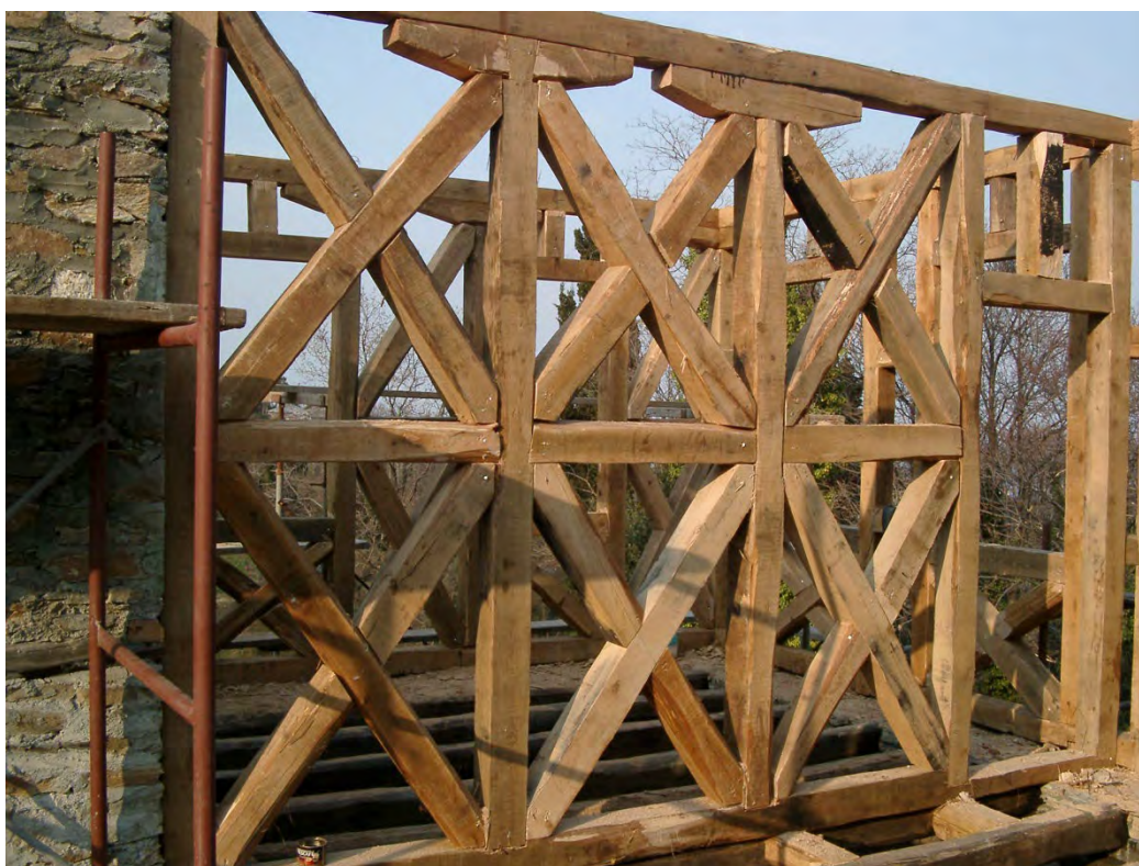
Φωτογραφία 43: Ξύλινοι σκελετοί τοίχων
