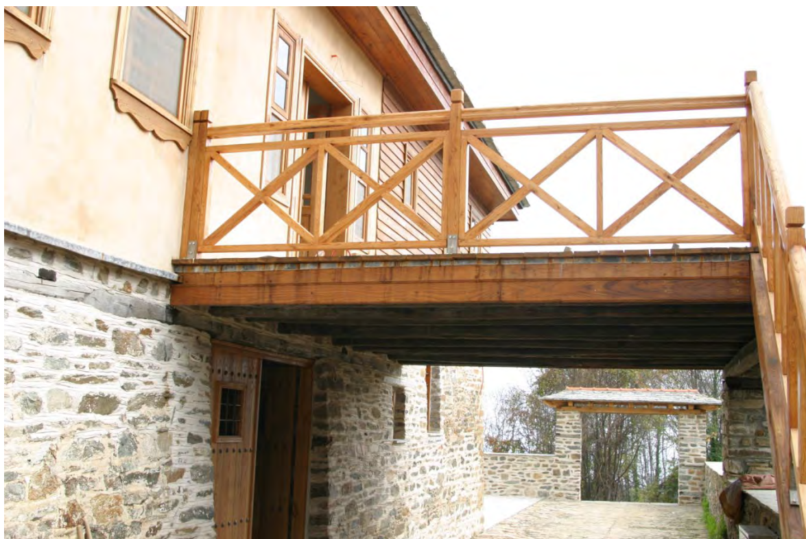
Φωτογραφία 206: Νότια όψη του Αντιπροσωπείου (Ολοκληρωμένο)
