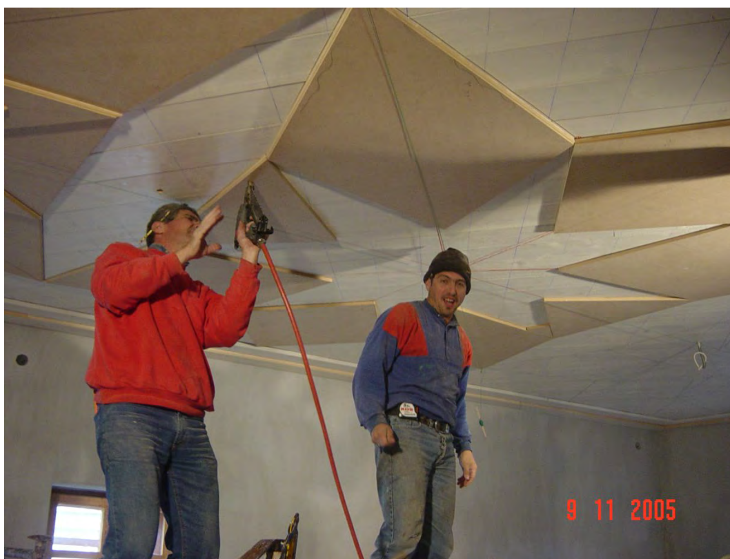
Φωτογραφία 162: Κατασκευή σχεδίου περίτεχνου ταβανώματος
