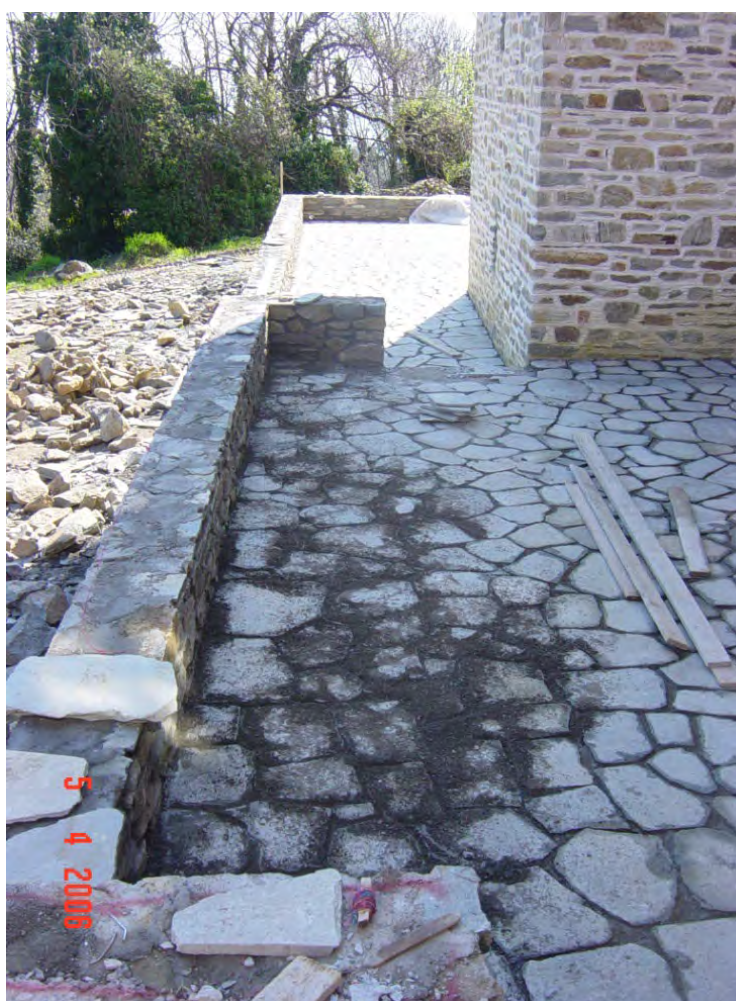
Φωτογραφία 172: Κατασκευή πεζουλιών-Διάστρωση σχιστόπλακας
