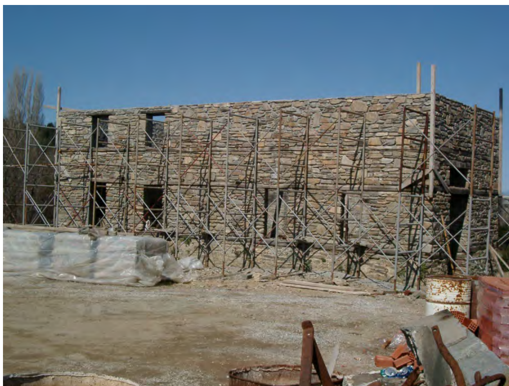
Φωτογραφία 52: Κατασκευή λιθοδομών (Βουρδουναριό)
