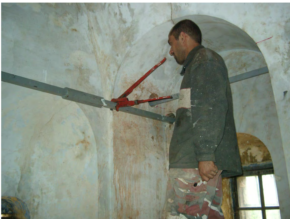
Φωτογραφία 117: Τοποθέτηση μεταλλικών ελκυστήρων
