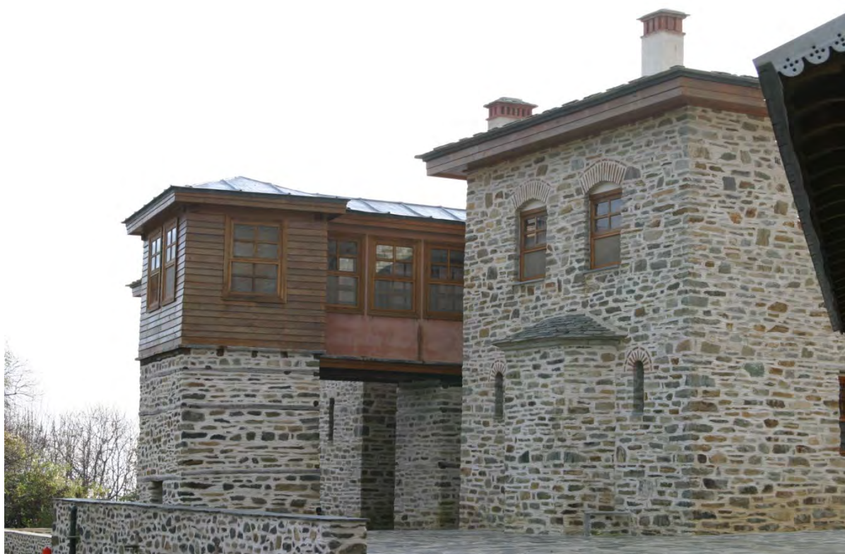
Φωτογραφία 210: Δυτική και Βόρεια όψεις του Αντιπροσωπείου (Ολοκληρωμένο)
