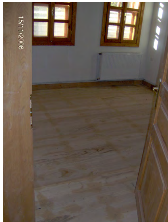
Φωτογραφία 152: Τοποθέτηση ξύλινων πατωμάτων
