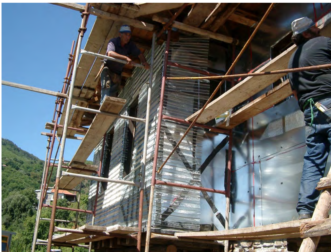
Φωτογραφία 95: Επένδυση τοίχων με νευρομετάλ
