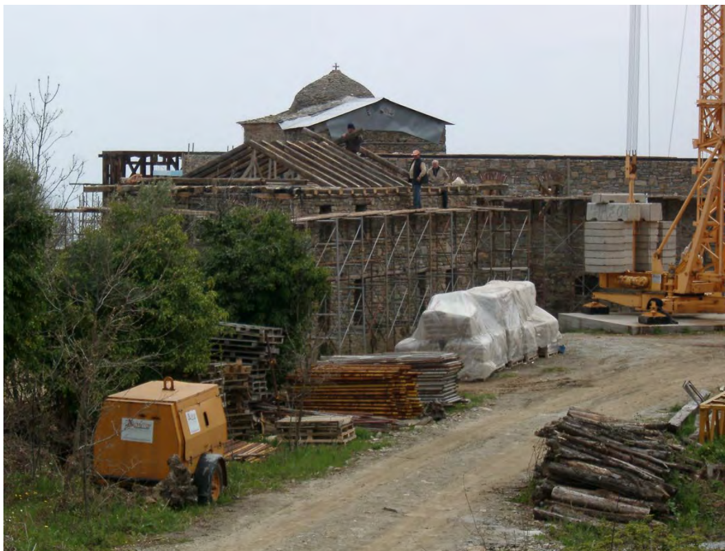
Φωτογραφία 61: Ξύλινος σκελετός στέγης
