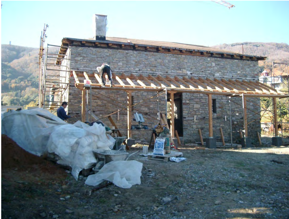
Φωτογραφία 185: Κατασκευή σκελετού στεγάστρου
