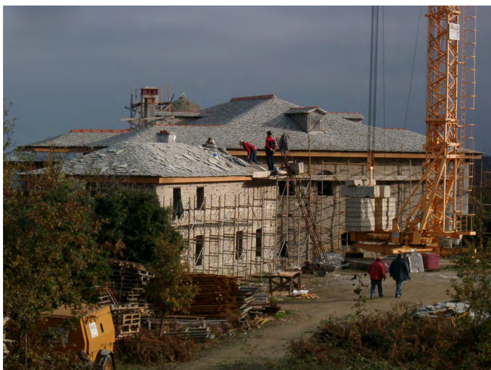
Φωτογραφία 82: Διάστρωση σχιστόπλακας στέγης (ολοκληρωμένη)
