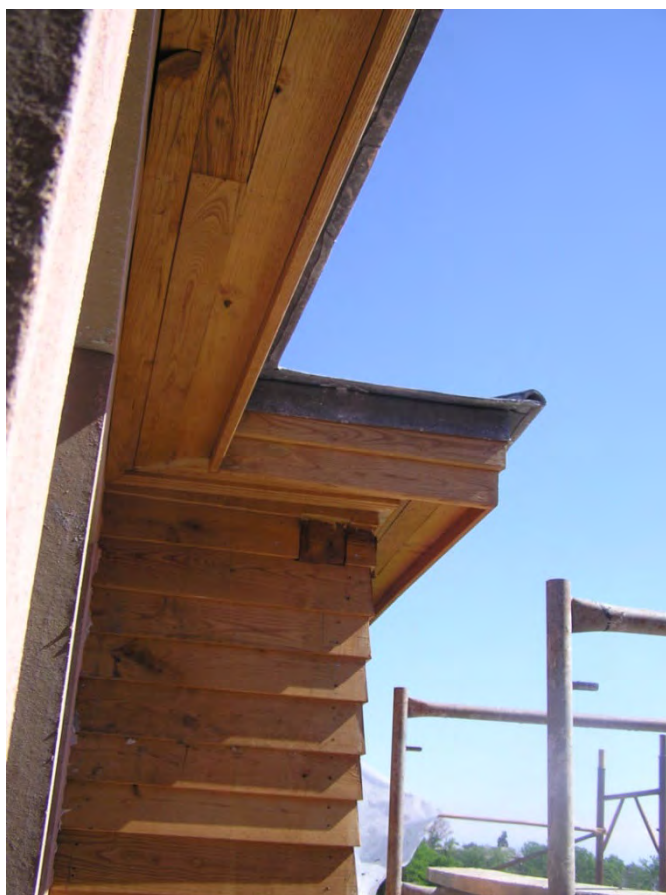
Φωτογραφία 134: Ξύλινη κορνίζα γείσου στέγης
