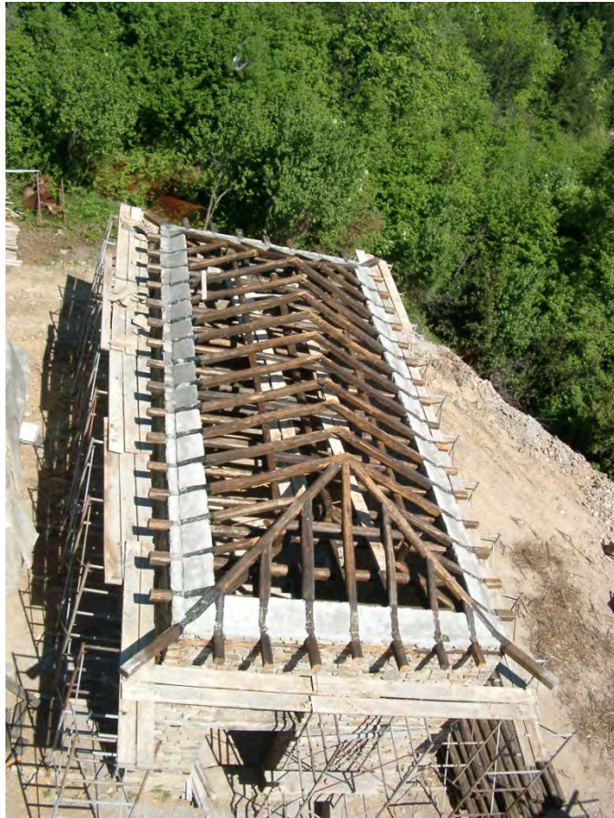
Φωτογραφία 65: Ξύλινος σκελετός στέγης
