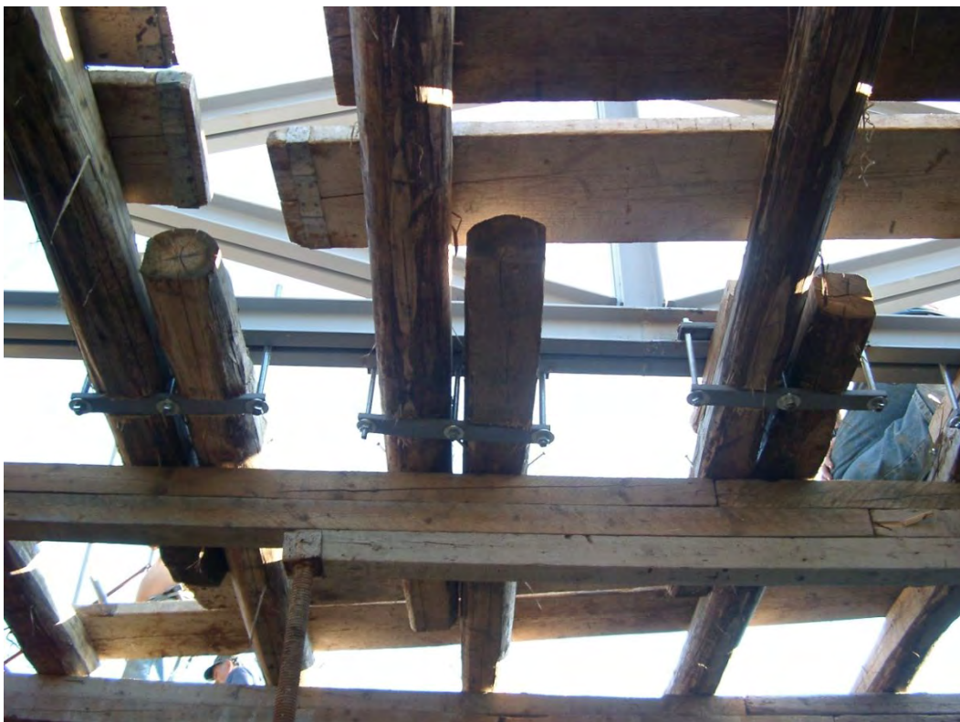
Φωτογραφία 60: Λεπτομέρεια σύνδεσης μεταλλικού ζευκτού στέγης
