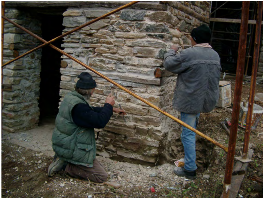
Φωτογραφία 76: Εκβάθυνση αρμών
