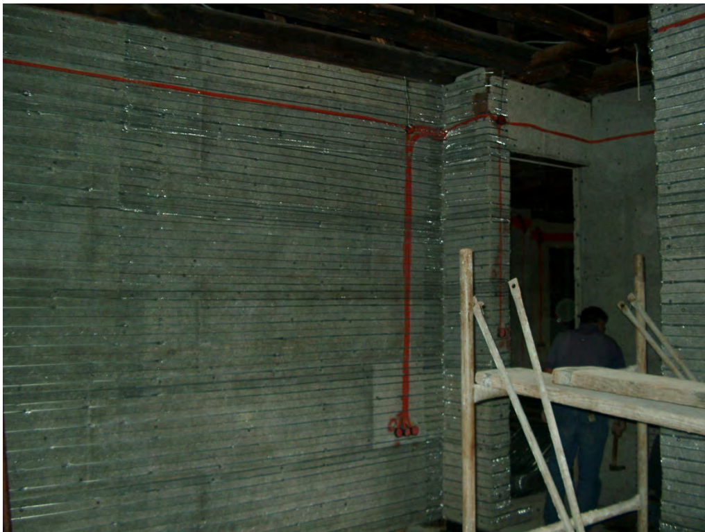
Φωτογραφία 90: Επένδυση τοίχων με νευρομετάλ
