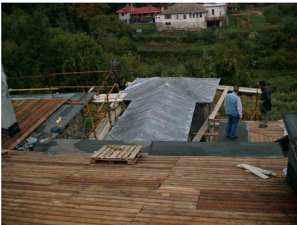
Φωτογραφία 84: Επικάλυψη στέγης με φύλλο μολυβιού (ολοκληρωμένο)
