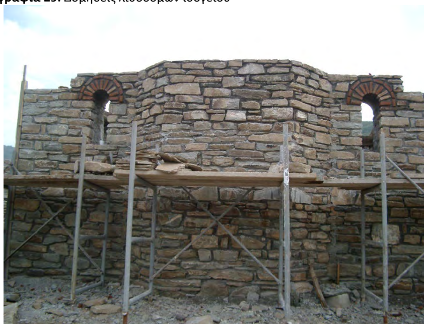
Φωτογραφία 30: Δομήσεις λιθοδομών ισογείου
