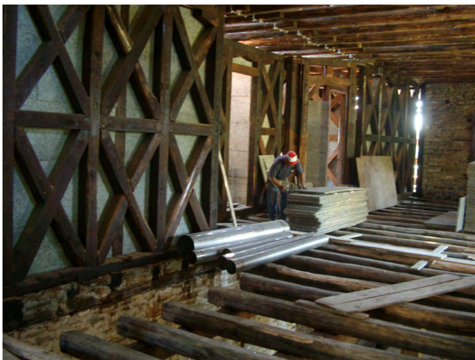
Φωτογραφία 87: Τοποθέτηση πλακών Ηρακλίτη
