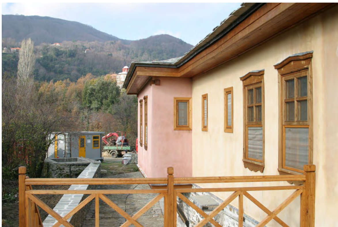
Φωτογραφία 207: Νότια όψη του Αντιπροσωπείου (Ολοκληρωμένο)
