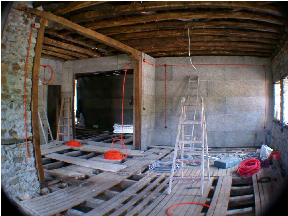
Φωτογραφία 89: Τοποθέτηση σωληνώσεων ηλεκτρολογικών
