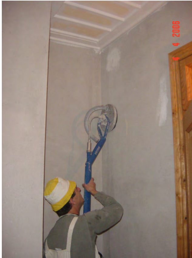
Φωτογραφία 191: Επεξεργασία τοίχων πριν τους χρωματισμούς
