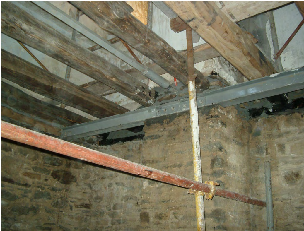
Φωτογραφία 121: Τοποθέτηση νέων πατόξυλων
