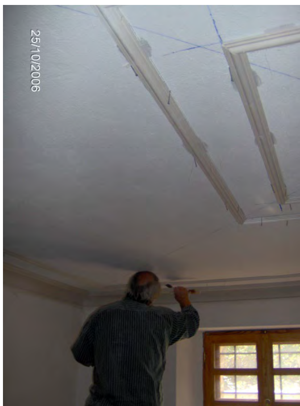
Φωτογραφία 168: Επιχρισμένη οροφή με γύψινη διακόσμηση
