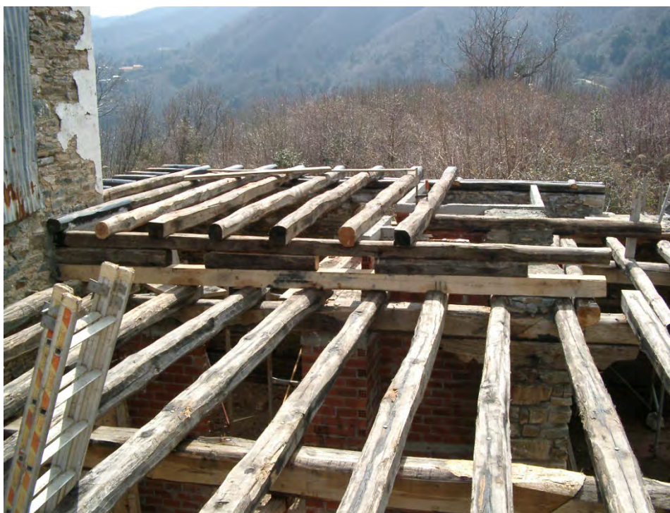
Φωτογραφία 37: Ξύλινοι σκελετοί πατωμάτων
