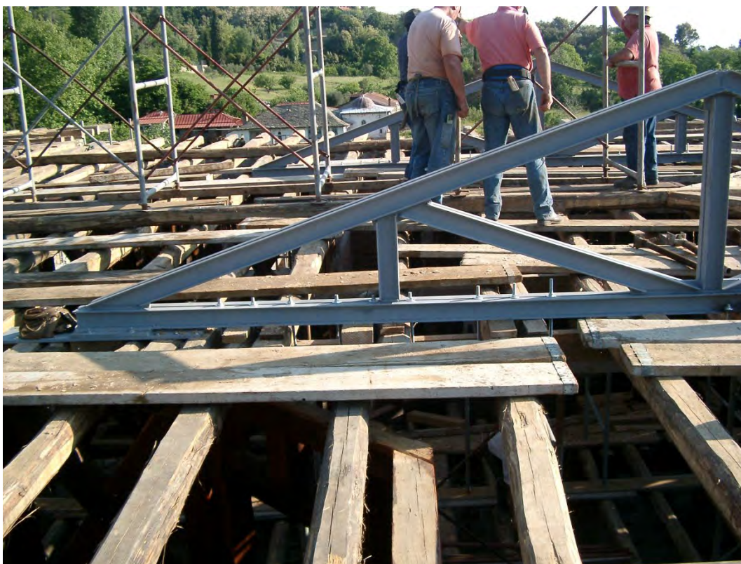
Φωτογραφία 58: Μεταλλικά ζευκτά στέγης
