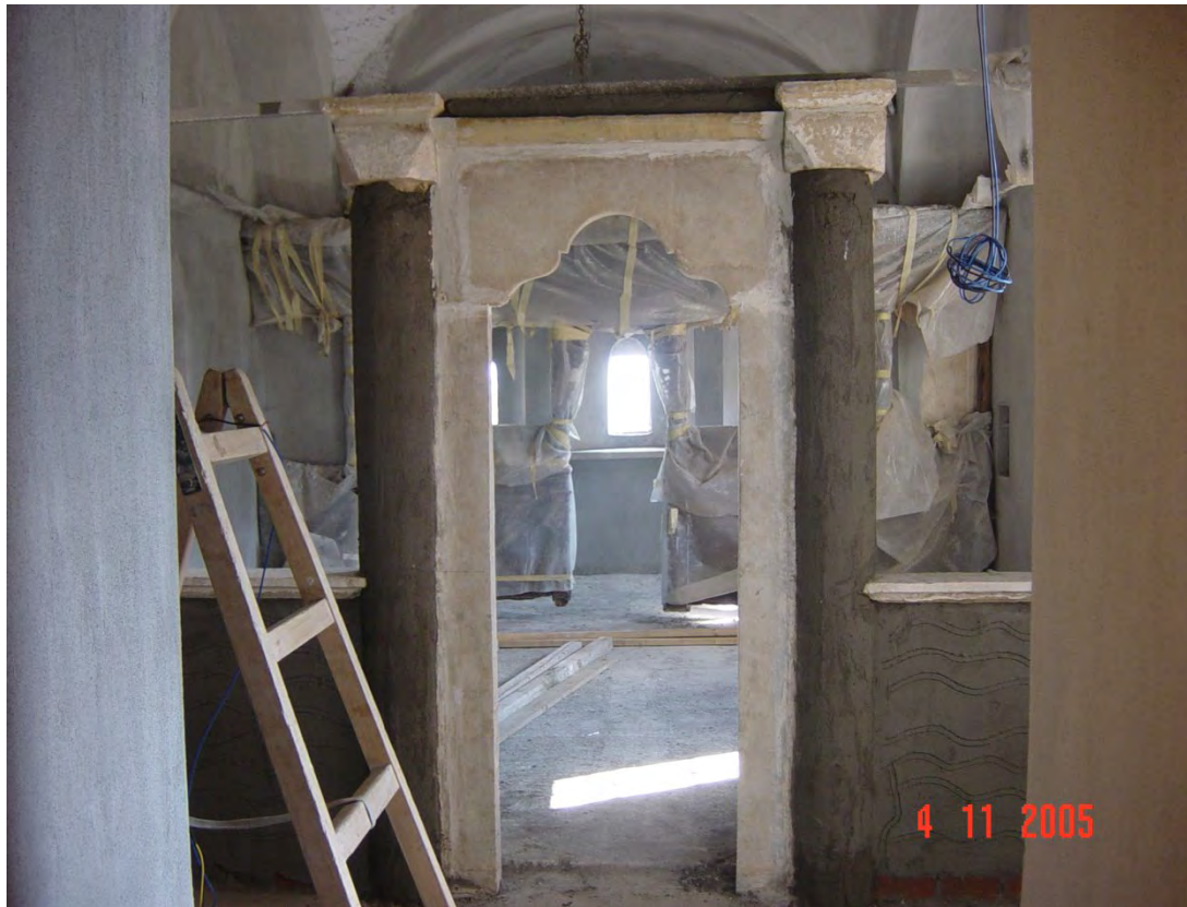
Φωτογραφία 123: Αποκατάσταση Λητής – Επιχρίσματα
