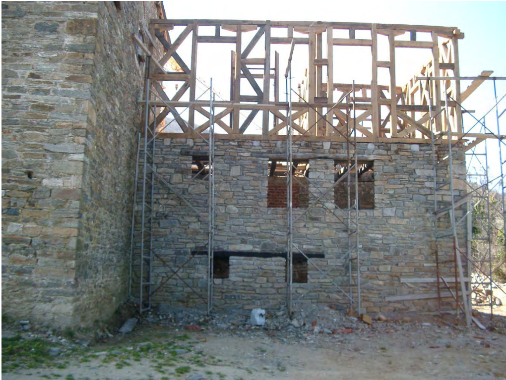
Φωτογραφία 49: Ξύλινοι σκελετοί τοίχων
