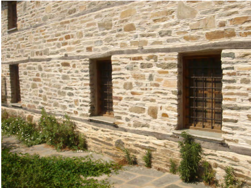
Φωτογραφία 139: Ποδιές παραθύρων από σχιστόπλακα-Προστατευτικές σιδεριές
