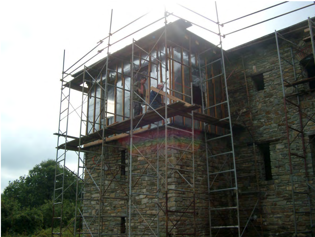
Φωτογραφία 101: Προετοιμασία για την ξύλινη επένδυση
