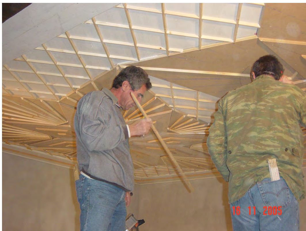
Φωτογραφία 164: Κατασκευή σχεδίου περίτεχνου ταβανώματος
