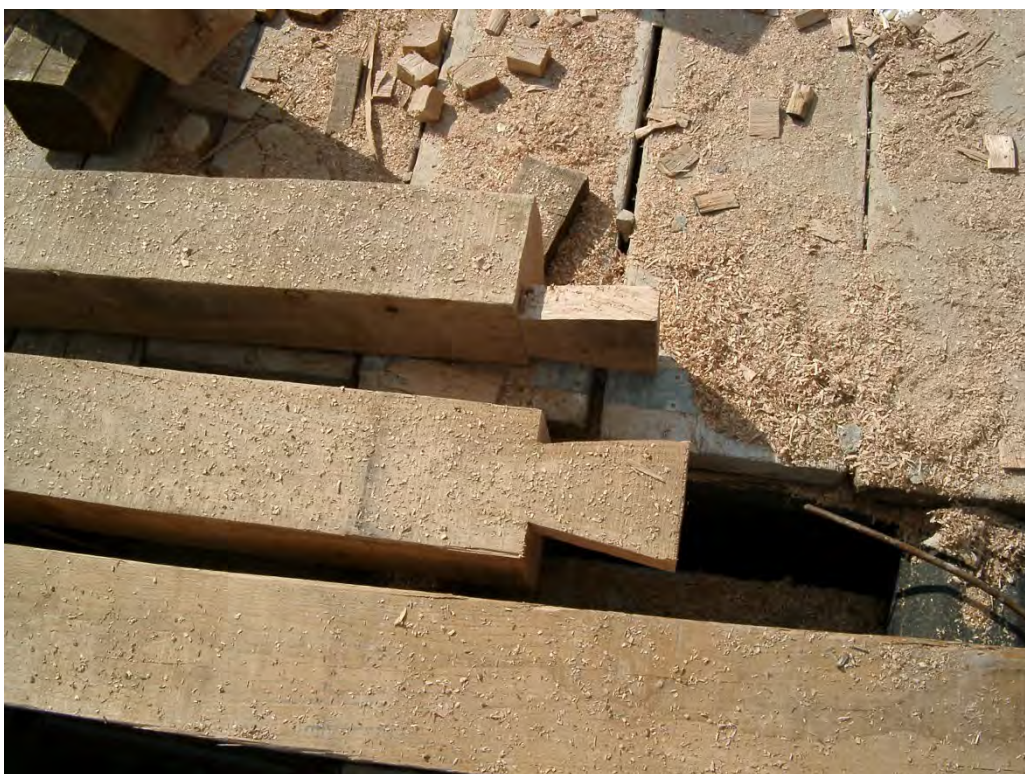
Φωτογραφία 47: Κατασκευαστική λεπτομέρεια ξύλινων σκελετών τοίχων
