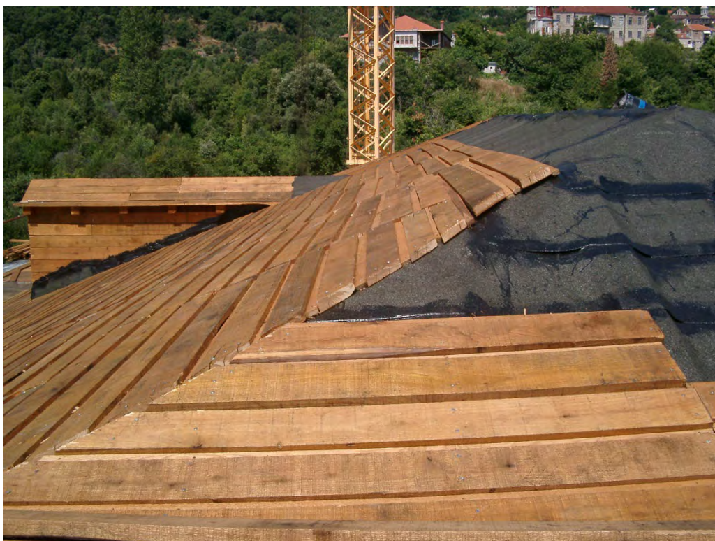
Φωτογραφία 71: Πέτσωμα στέγης (Δεύτερο)
