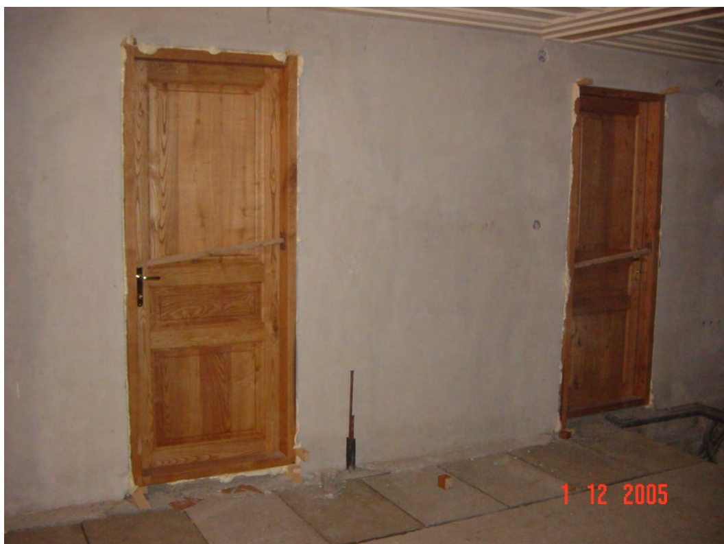
Φωτογραφία 148: Εσωτερικές ταμπλαδωτές πόρτες
