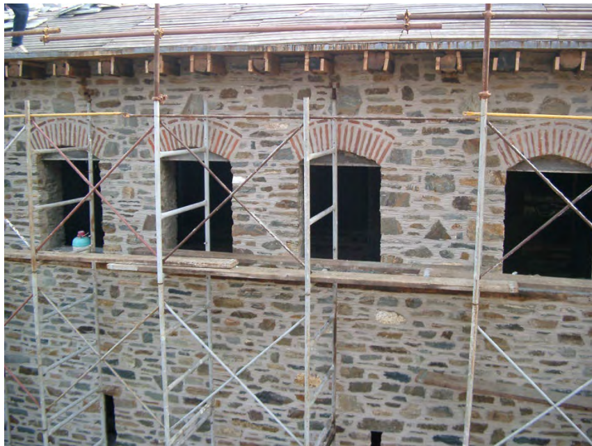
Φωτογραφία 78: Αρμολόγημα ολοκληρωμένο
