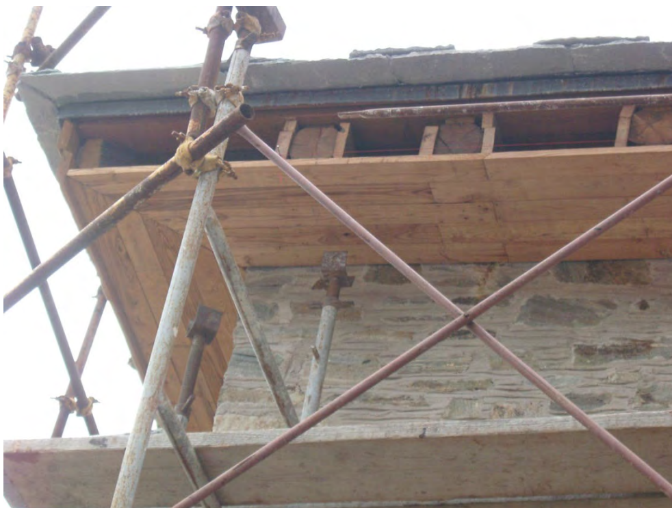
Φωτογραφία 133: Ξύλινη κορνίζα γείσου στέγης
