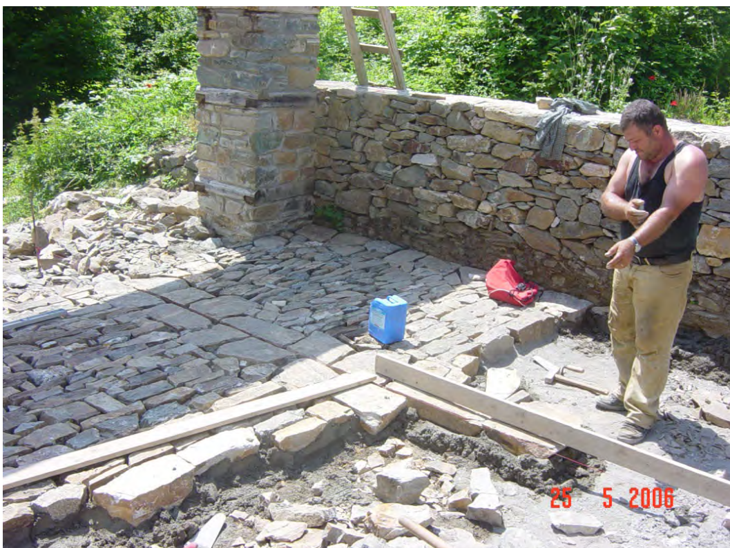
Φωτογραφία 176: Κατασκευή παραδοσιακού λιθόστρωτου
