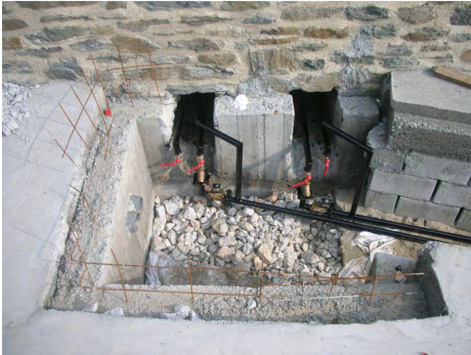
Φωτογραφία 183: Συνδέσεις ηλεκτρομηχανολογικών εγκαταστάσεων
