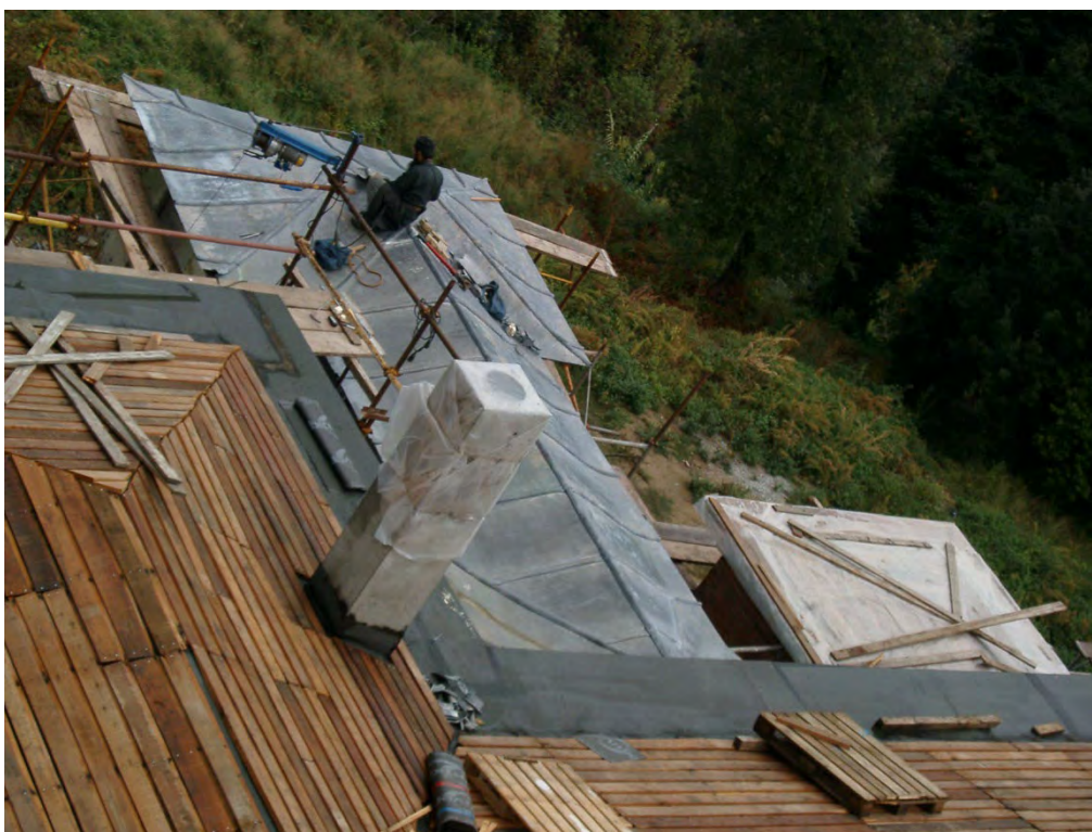
Φωτογραφία 83: Επικάλυψη στέγης με φύλλο μολυβιού
