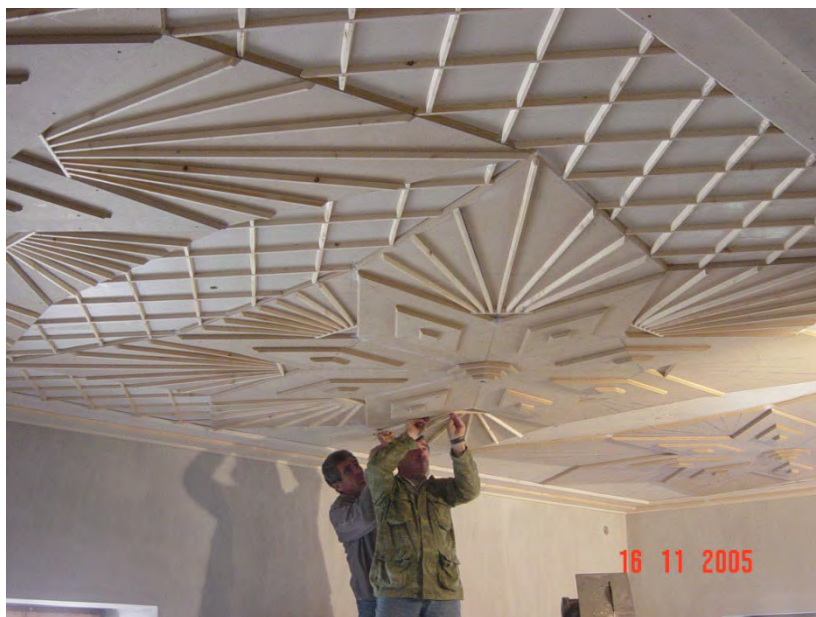
Φωτογραφία 166: Κατασκευή σχεδίου περίτεχνου ταβανώματος
