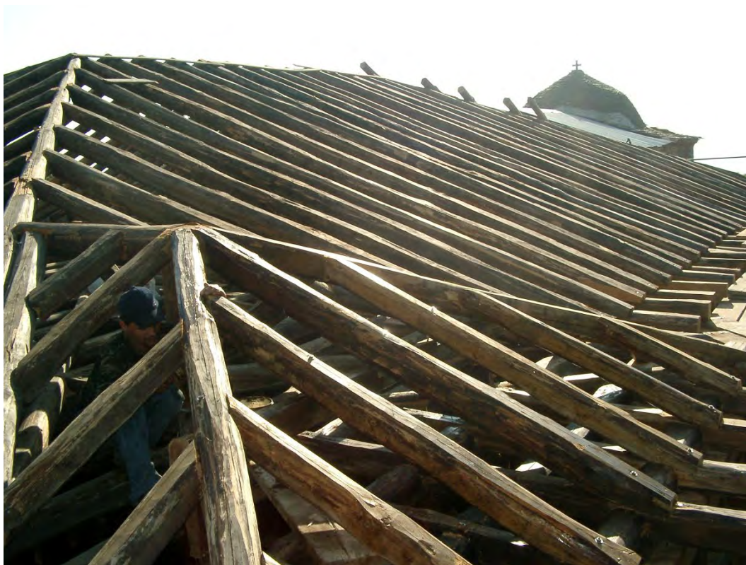
Φωτογραφία 63: Λεπτομέρεια ξύλινου σκελετού στέγης
