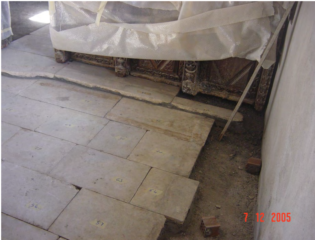
Φωτογραφία 125: Επανατοποθέτηση μαρμάρινων πλακών
