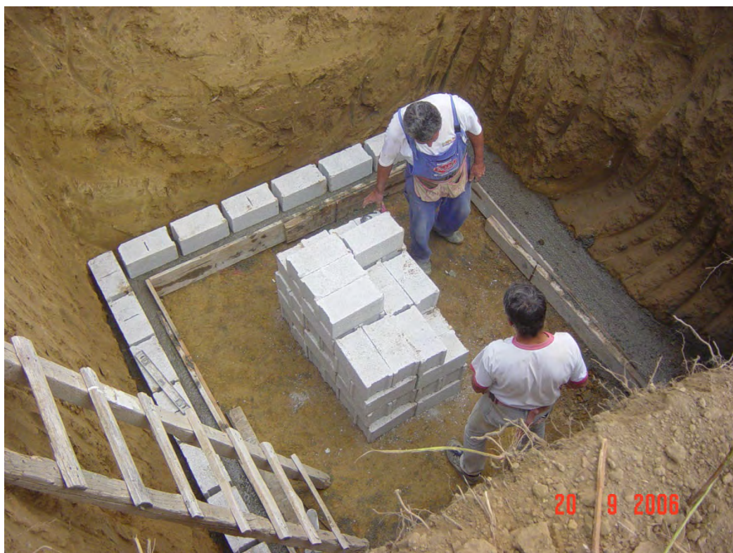
Φωτογραφία 181: Κατασκευή βόθρου
