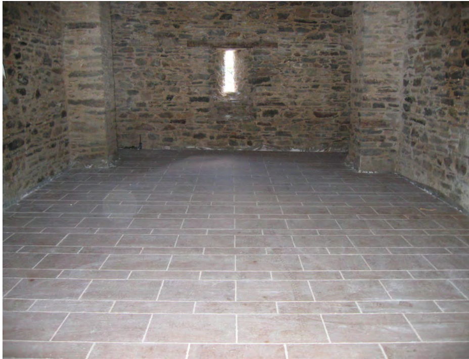
Φωτογραφία 155: Διάστρωση δαπέδου με κεραμικά πλακίδια
