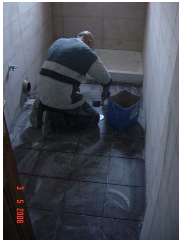
Φωτογραφία 154: Διάστρωση δαπέδου με κεραμικά πλακίδια
