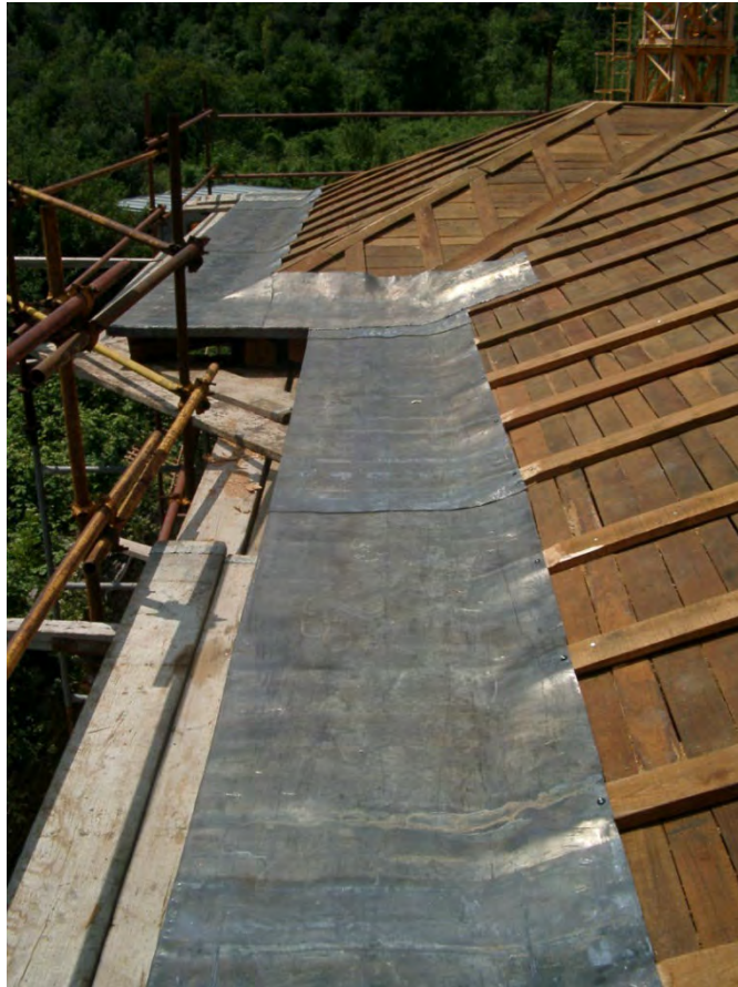
Φωτογραφία 67: Φύλλο μολυβιού γείσου στέγης
