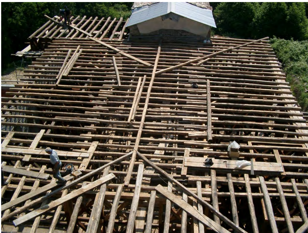
Φωτογραφία 57: Ξύλινος σκελετός στέγης
