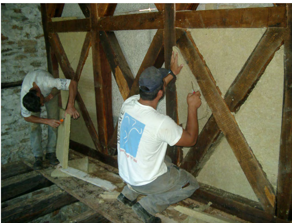
Φωτογραφία 88: Τοποθέτηση παπλώματος πετροβάμβακα
