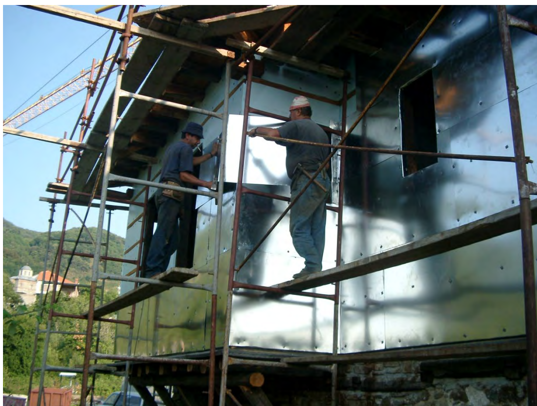
Φωτογραφία 94: Τοποθέτηση προστατευτικών φύλλων λαμαρίνας
