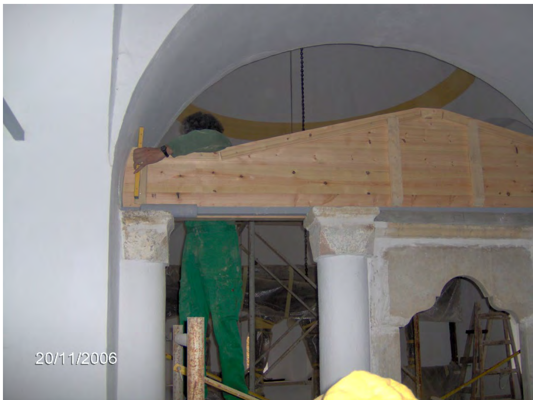
Φωτογραφία 124: Αποκατάσταση Λητής - Επιχρίσματα
