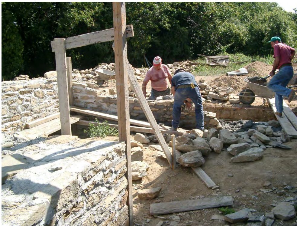
Φωτογραφία 28: Δομήσεις λιθοδομών ισογείου
