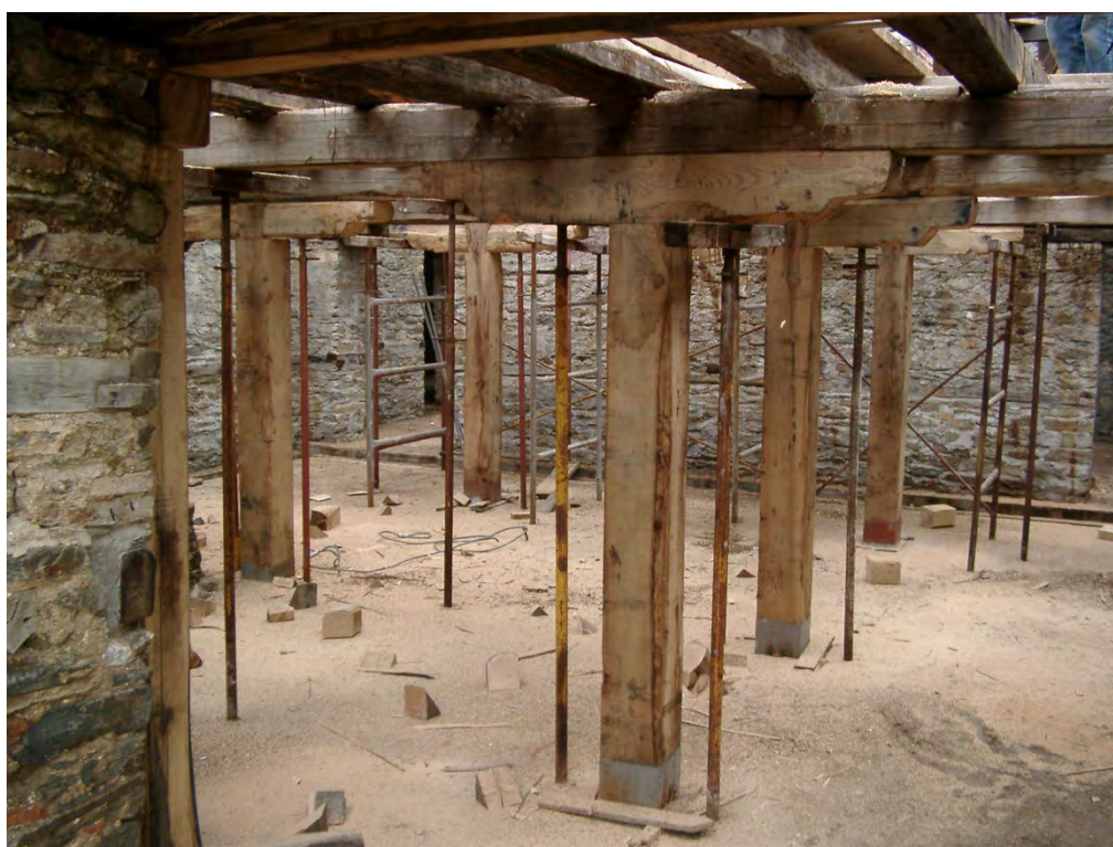
Φωτογραφία 38: Ξύλινοι σκελετοί πατωμάτων-Κολώνες-Μαξιλάρια-Ποταμοί
