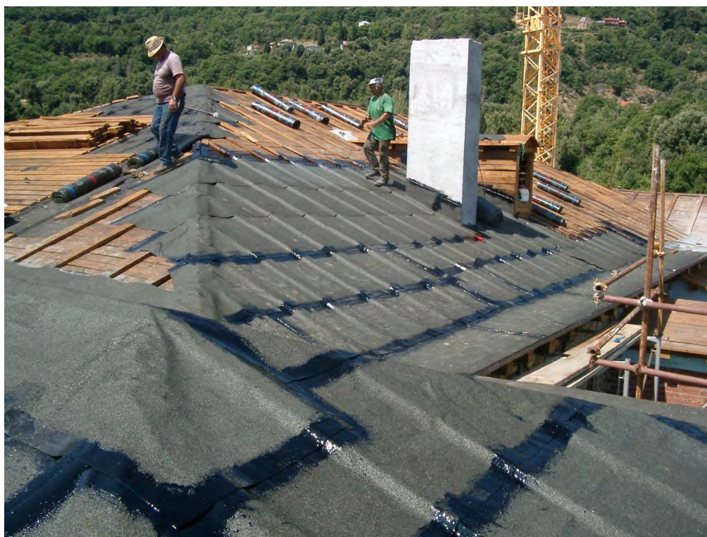
Φωτογραφία 70: Διάστρωση ασφαλτόπανου
