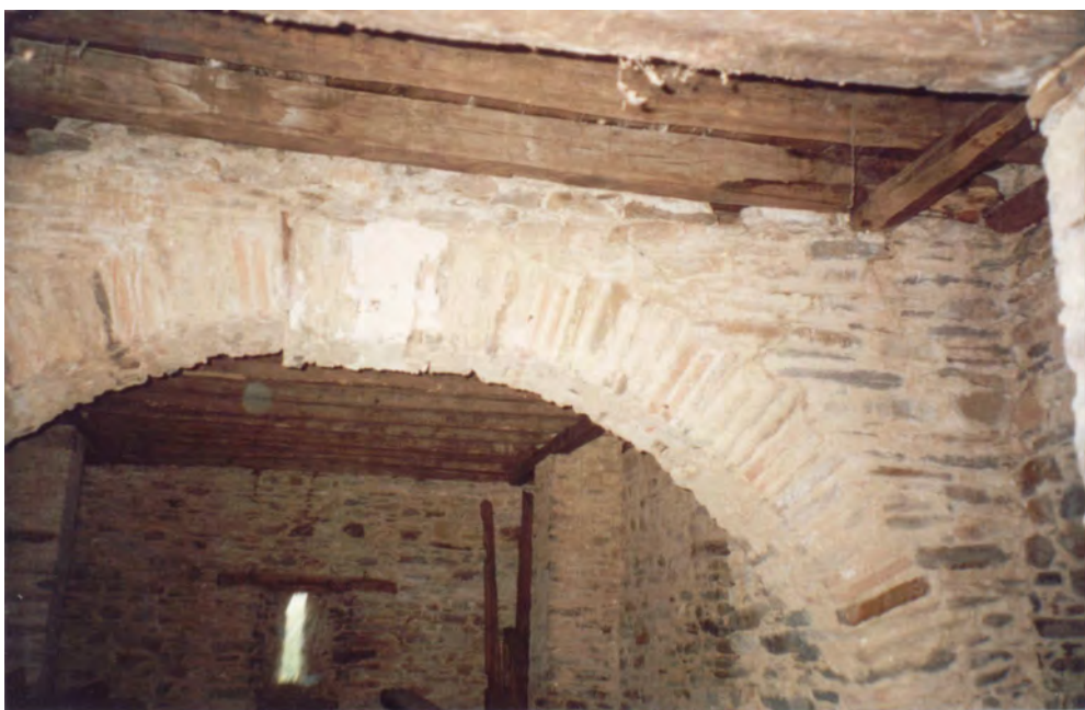
Φωτογραφία 111: Υπάρχουσα κατάσταση-Ισόγειο
