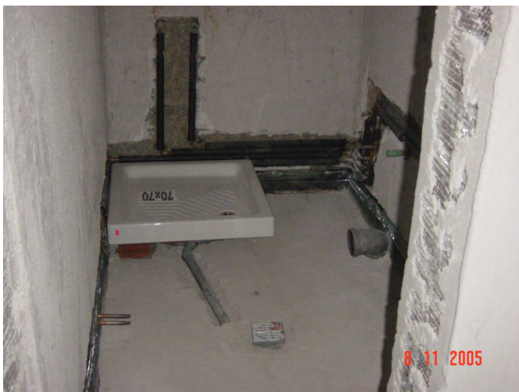
Φωτογραφία 104: Υδραυλική εγκατάσταση-Τοποθέτηση ειδών υγιεινής
