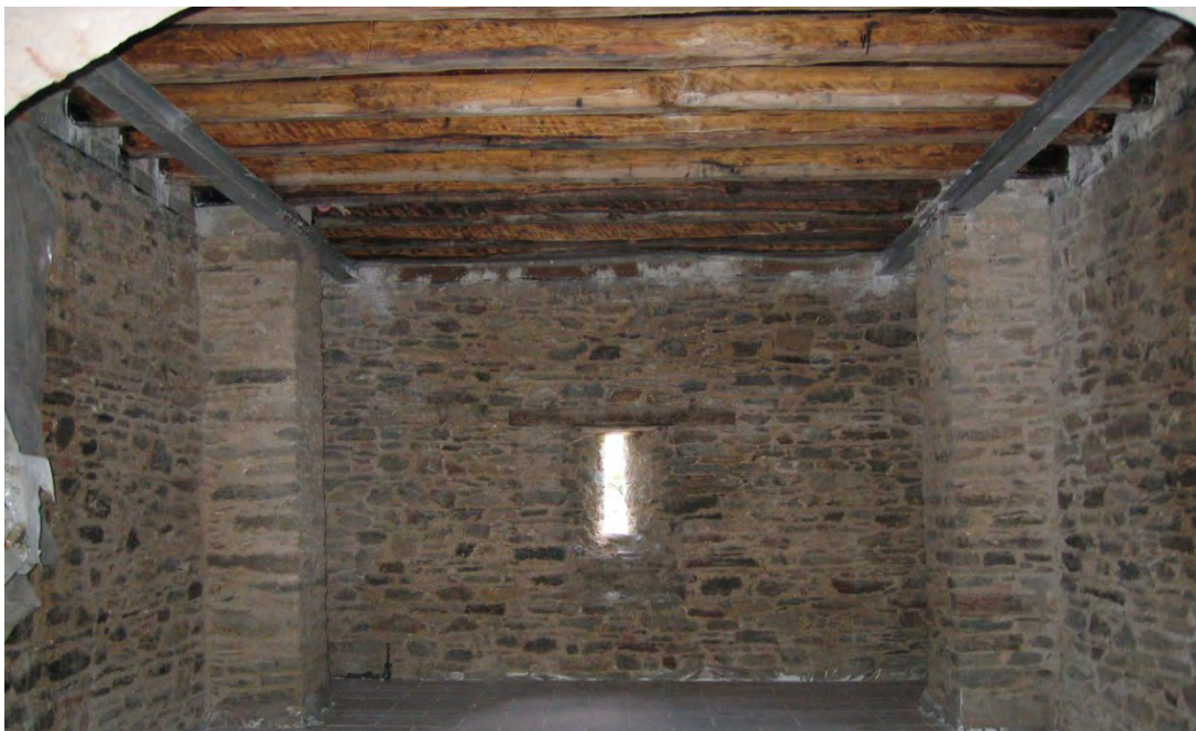
Φωτογραφία 122: Τοποθέτηση νέων πατόξυλων - Ψευτοπατώματος
