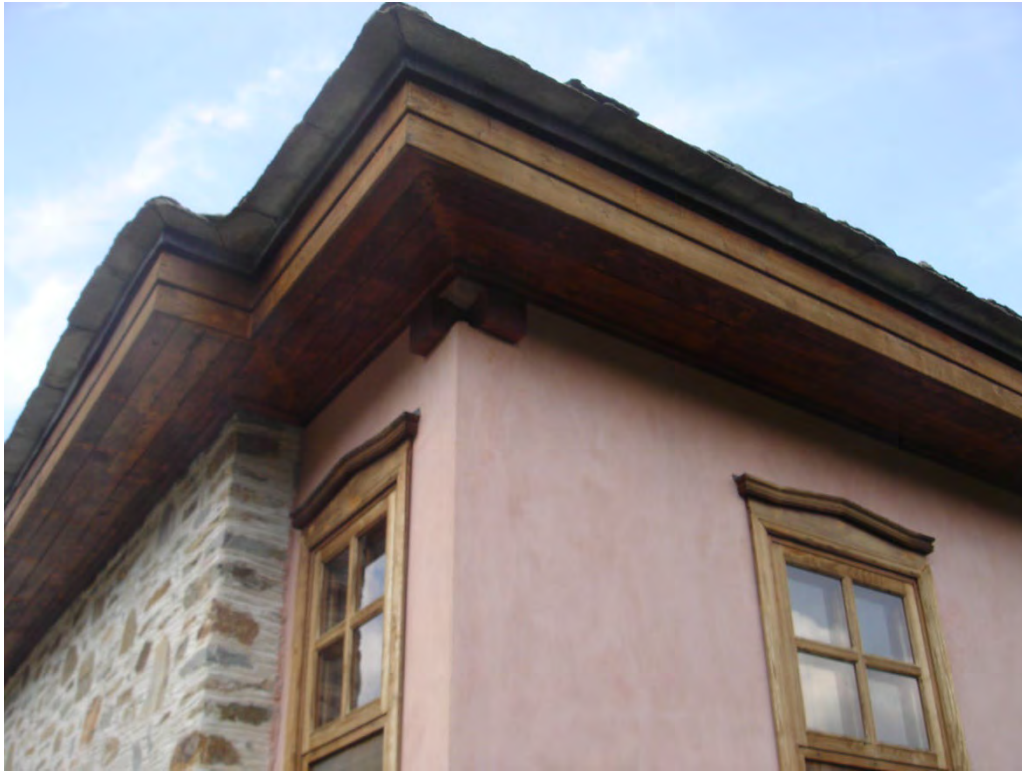
Φωτογραφία 137: Ξύλινες κορνίζες κουφωμάτων
