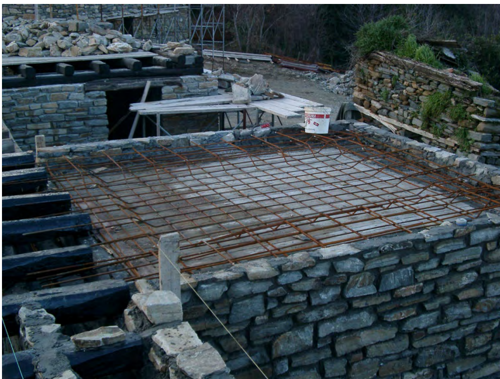
Φωτογραφία 42: Πλάκα σκυροδέματος χώρων υγιεινής
