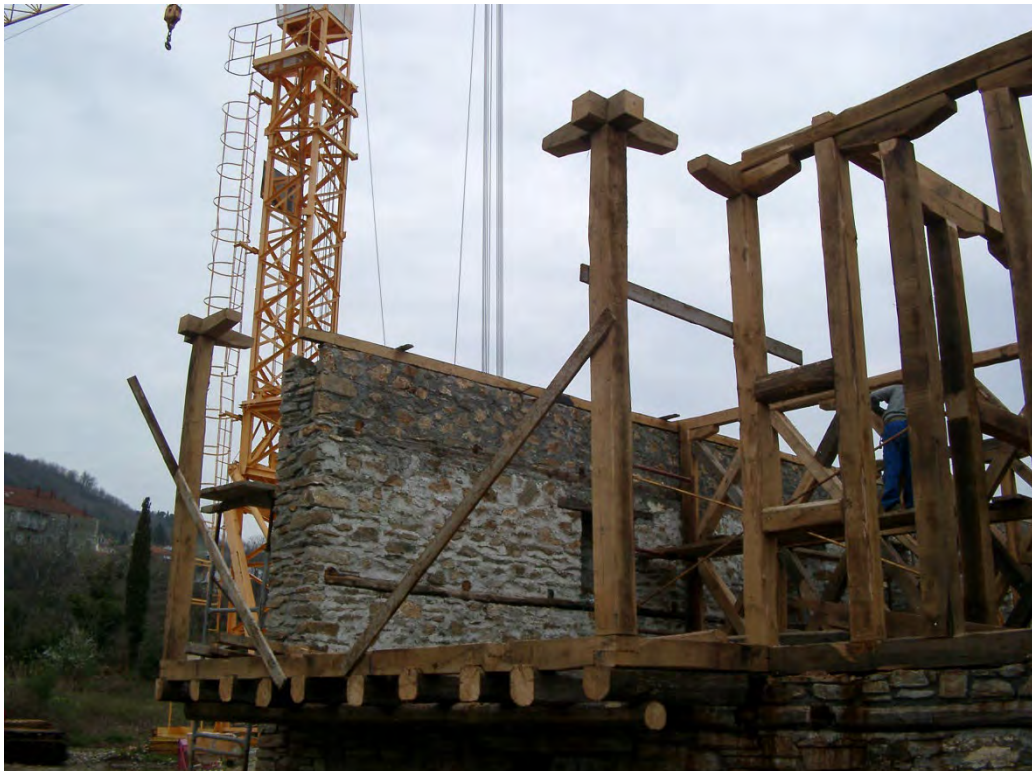
Φωτογραφία 50: Ξύλινοι σκελετοί τοίχων
