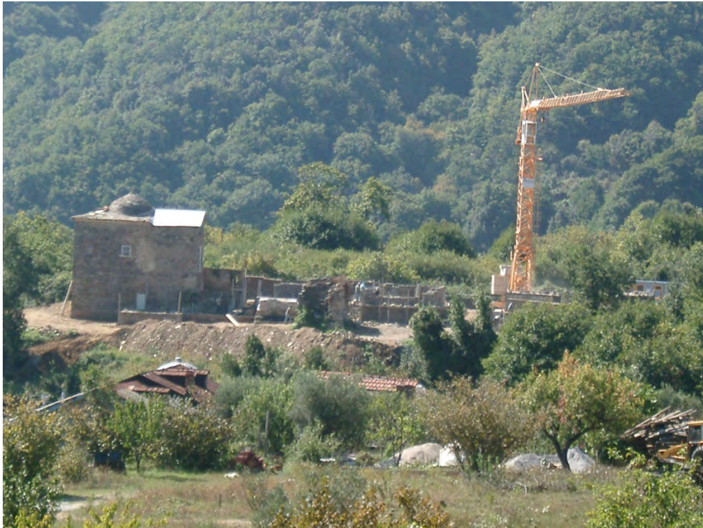
Φωτογραφία 21: Μετά τον καθαρισμό
