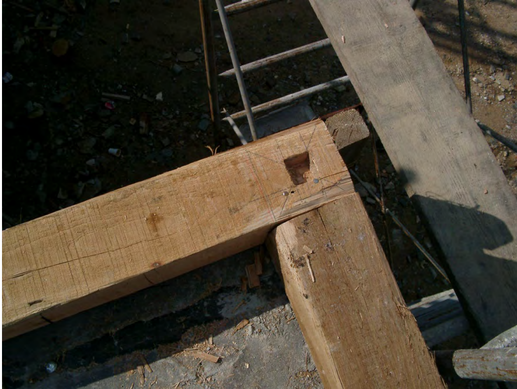
Φωτογραφία 46: Κατασκευαστική λεπτομέρεια ξύλινων σκελετών τοίχων
