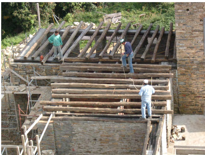
Φωτογραφία 35: Ξύλινοι σκελετοί πατωμάτων
