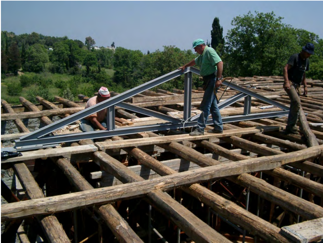
Φωτογραφία 59: Μεταλλικό ζευκτό στέγης
