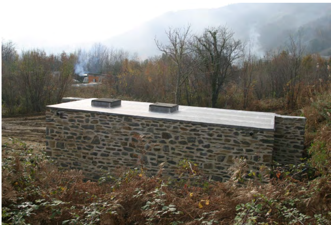
Φωτογραφία 179: Επένδυση τοιχίου δεξαμενής καυσίμων με λιθοδομή
