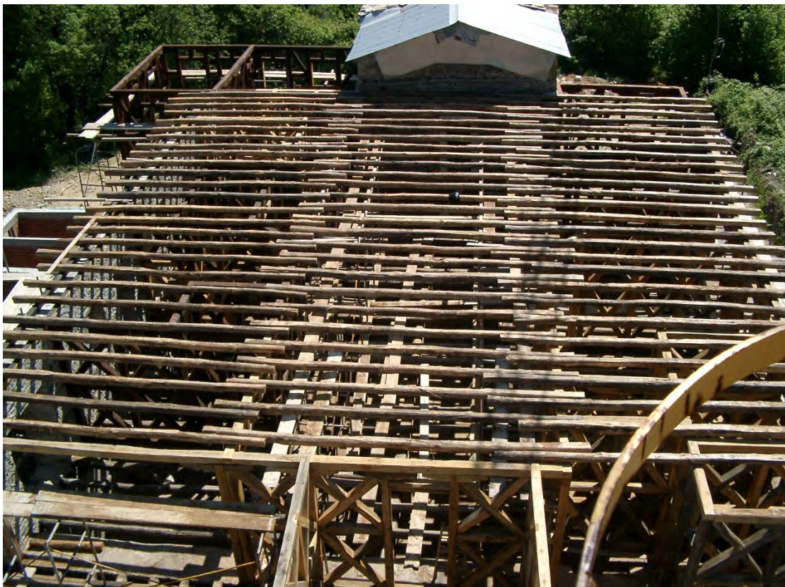
Φωτογραφία 54: Ξύλινος σκελετός στέγης
