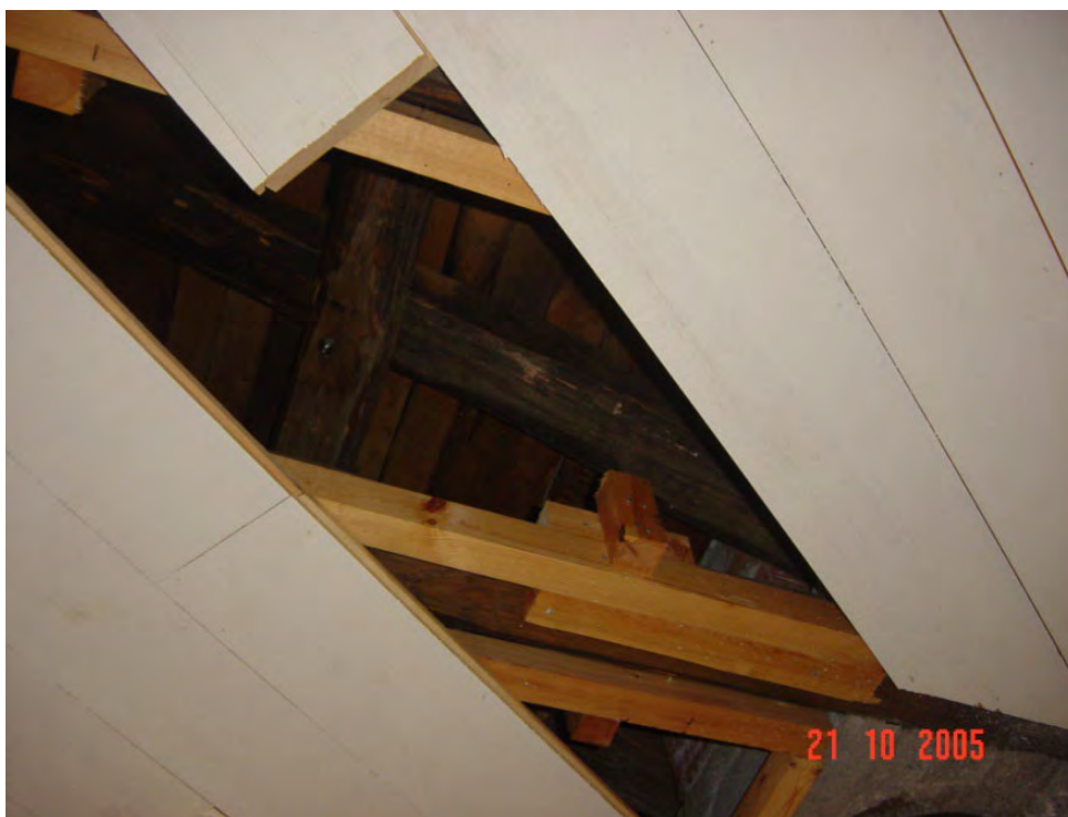
Φωτογραφία 161: Κατασκευή ψευδοτάβανου
