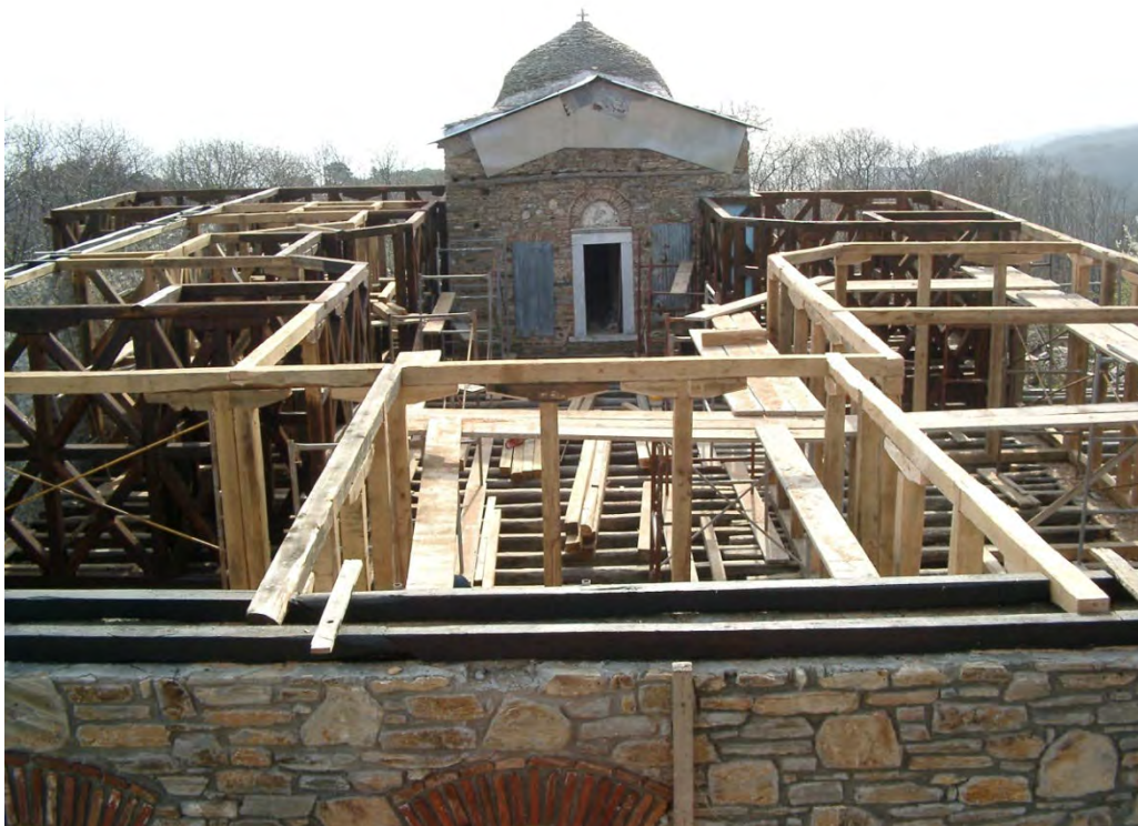
Φωτογραφία 51: Ξύλινοι σκελετοί τοίχων
