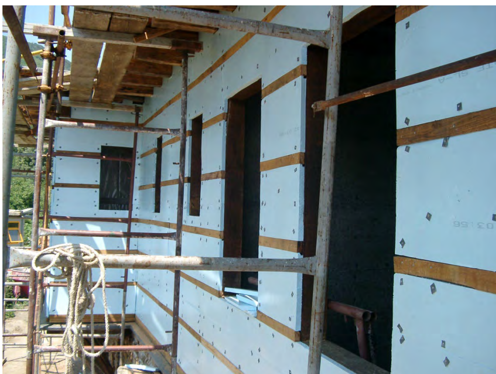
Φωτογραφία 92: Τοποθέτηση πλακών εξηλασμένης πολυστερόλης
