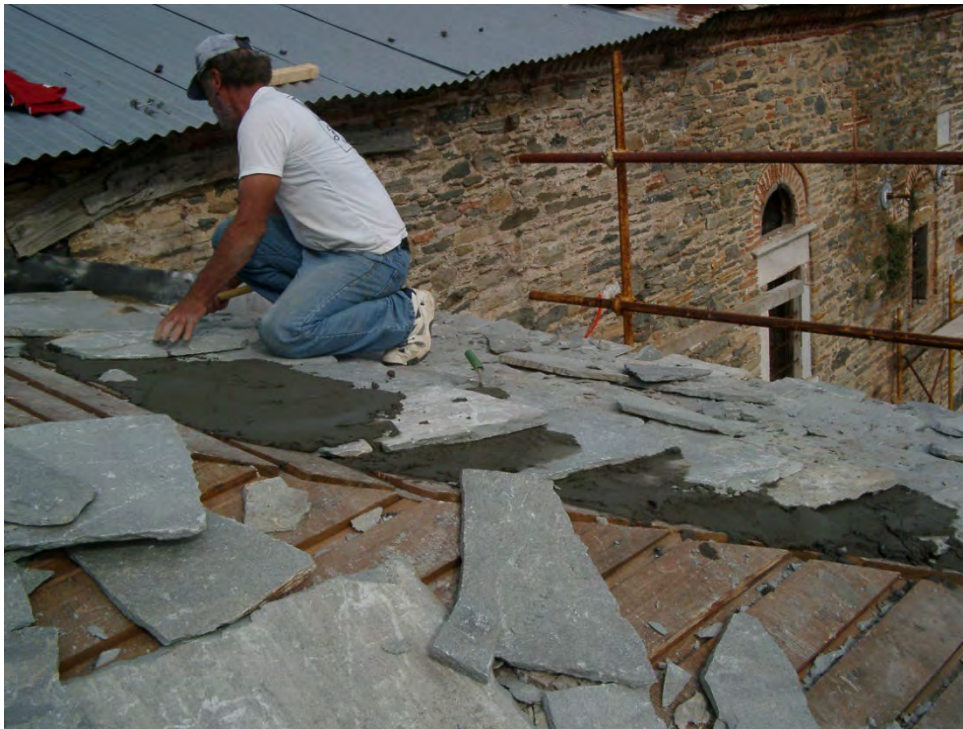
Φωτογραφία 80: Διάστρωση σχιστόπλακας στέγης
