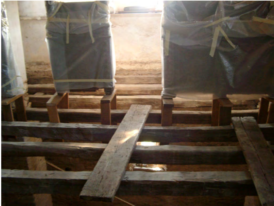
Φωτογραφία 113: Αποξήλωση ψευτοπατώματος
