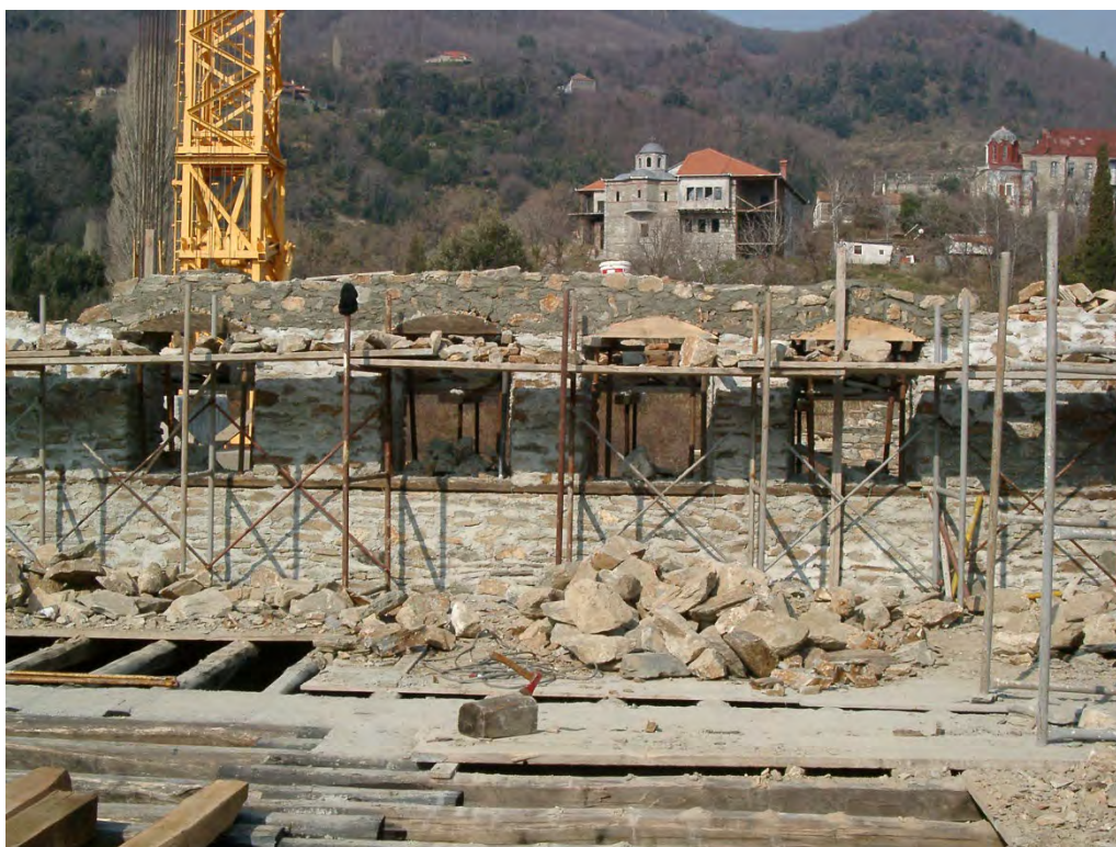
Φωτογραφία 39: Δομήσεις λιθοδομών ορόφου
