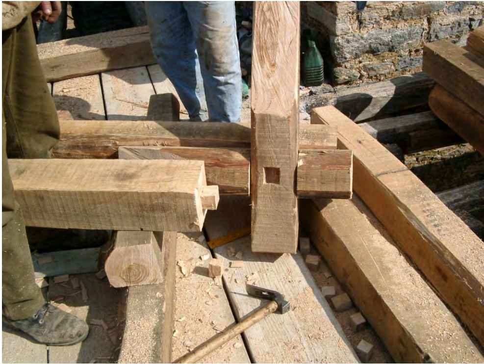
Φωτογραφία 45: Κατασκευαστική λεπτομέρεια ξύλινων σκελετών τοίχων
