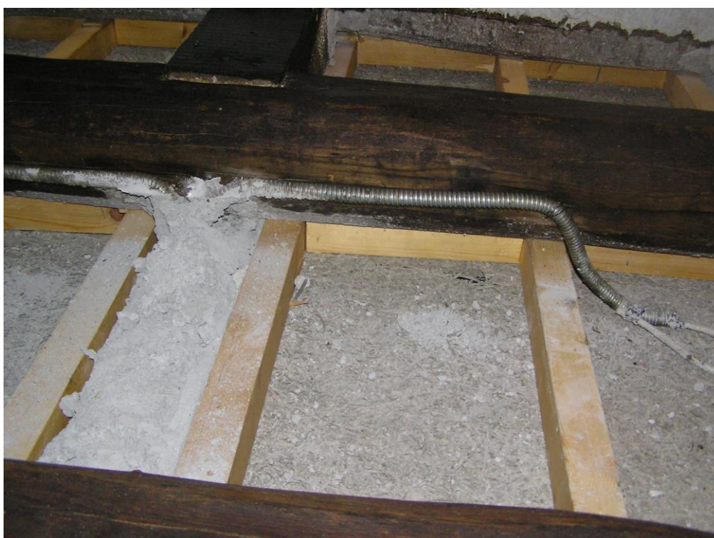
Φωτογραφία 131: Καδρονιαρίσματα οροφών - Τοποθέτηση Ηρακλίου
