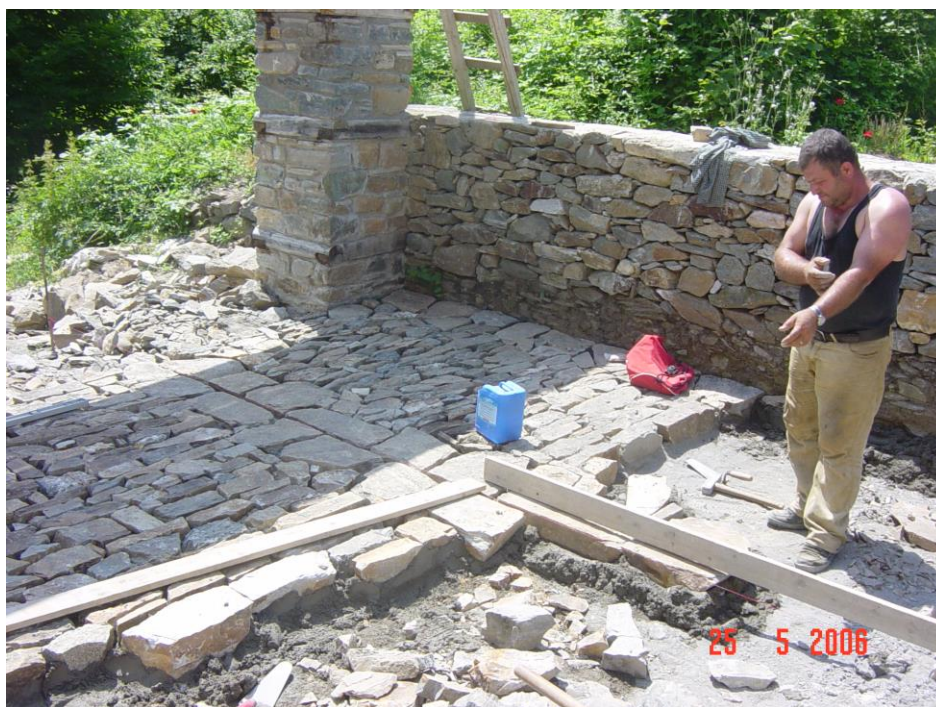
Φωτογραφία 176: Κατασκευή παραδοσιακού λιθόστρωτου
