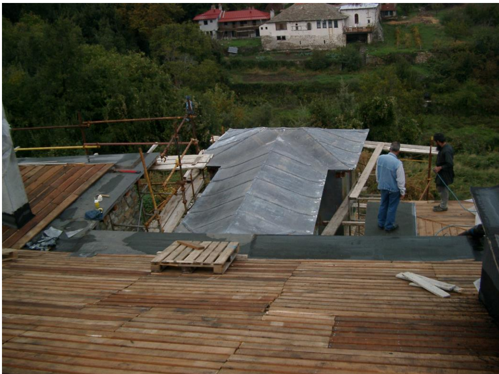
Φωτογραφία 84: Επικάλυψη στέγης με φύλλο μολυβιού (ολοκληρωμένο)
