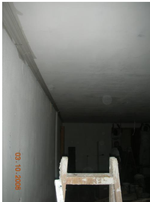
Φωτογραφία 169: Ψευδοροφή τσιμεντοσανίδας με γύψινη κορνίζα
