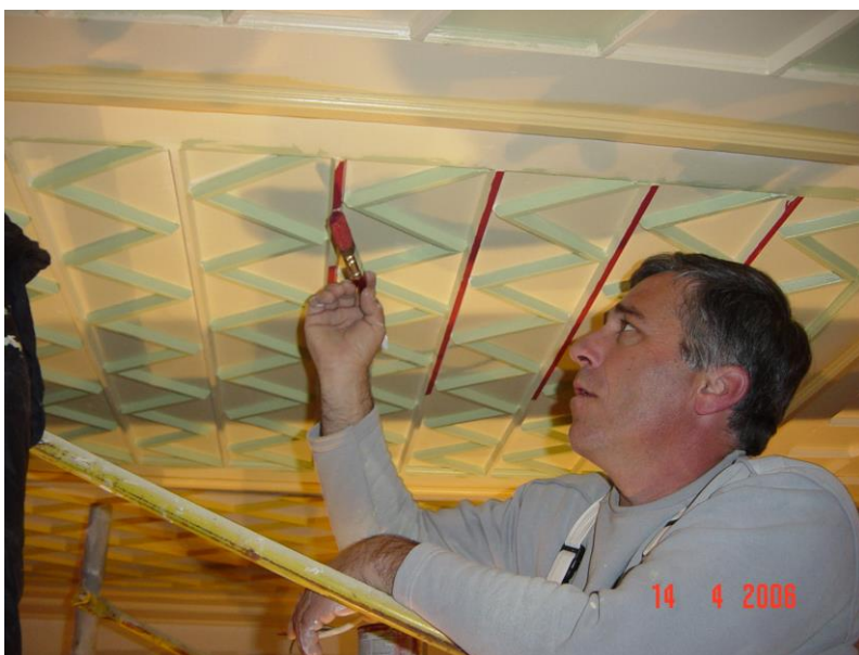
Φωτογραφία 193: Χρωματισμοί περίτεχνων ταβανωμάτων
