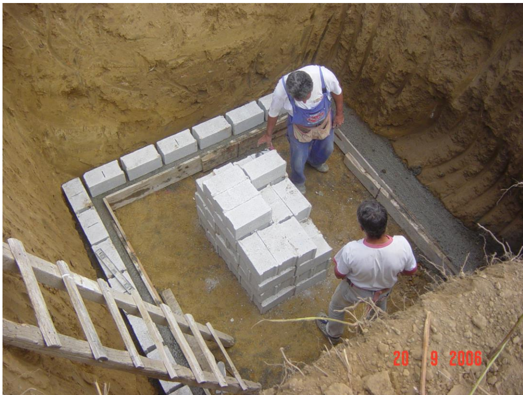
Φωτογραφία 181: Κατασκευή βόθρου
