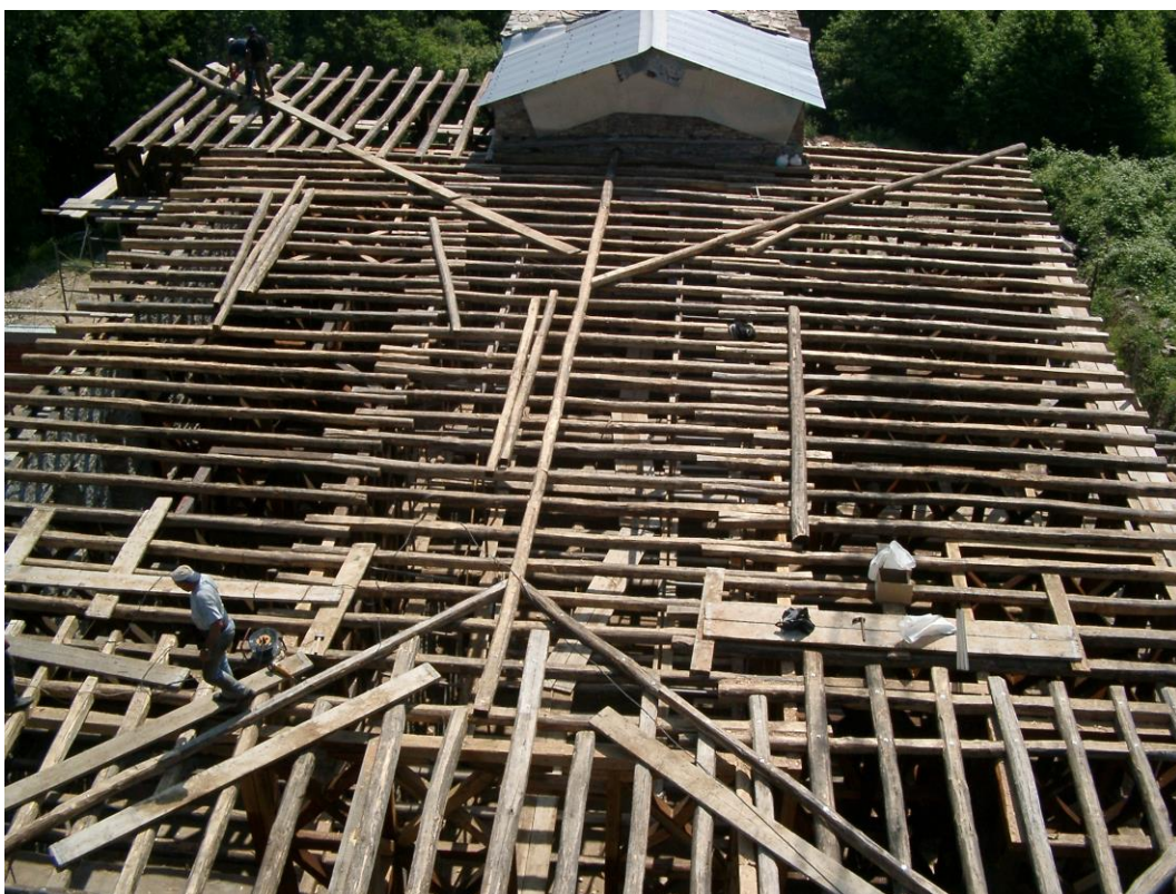
Φωτογραφία 57: Ξύλινος σκελετός στέγης
