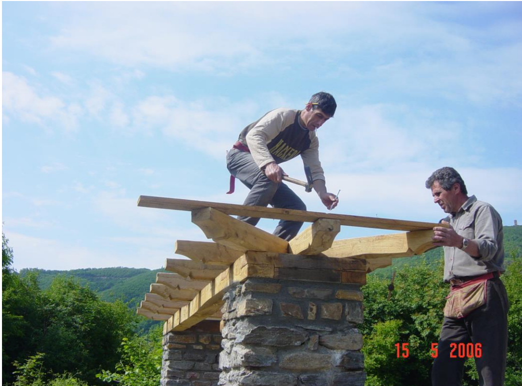
Φωτογραφία 174: Κατασκευή πεσσών και παραδοσιακού στεγάστρου καγκελόπορτας
