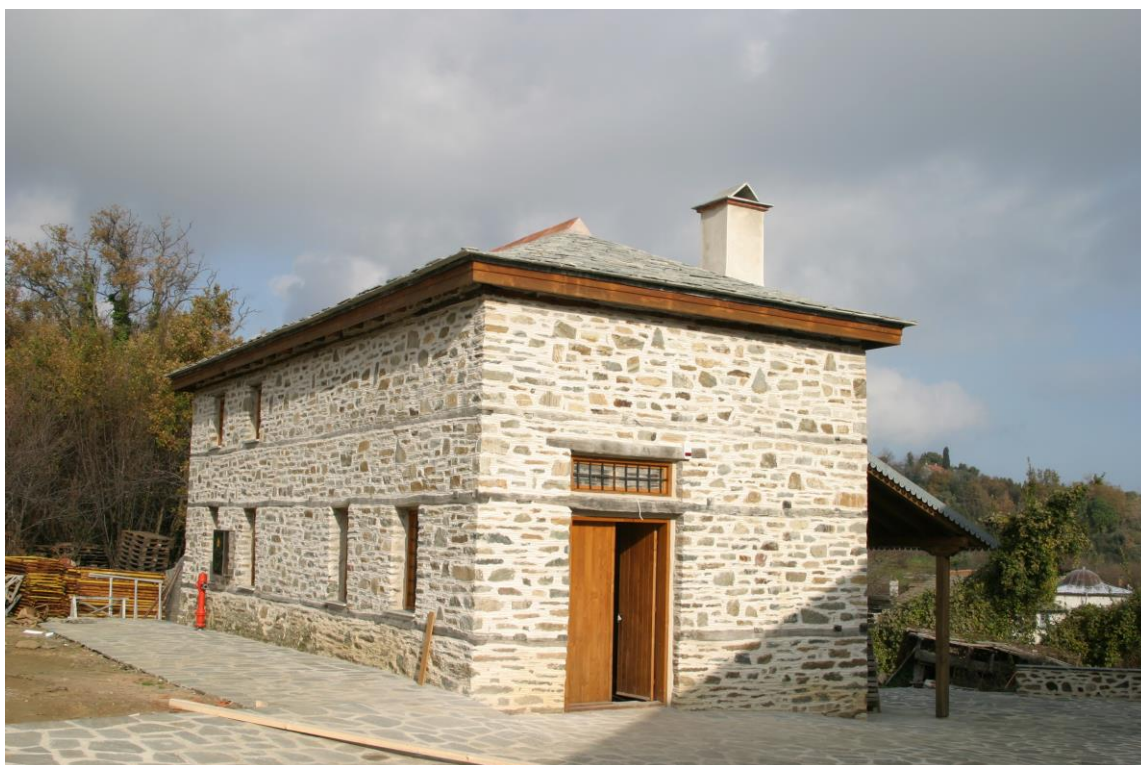
Φωτογραφία 205: Δυτική και Νότια όψεις του βοηθητικού κτίσματος (Ολοκληρωμένο)
