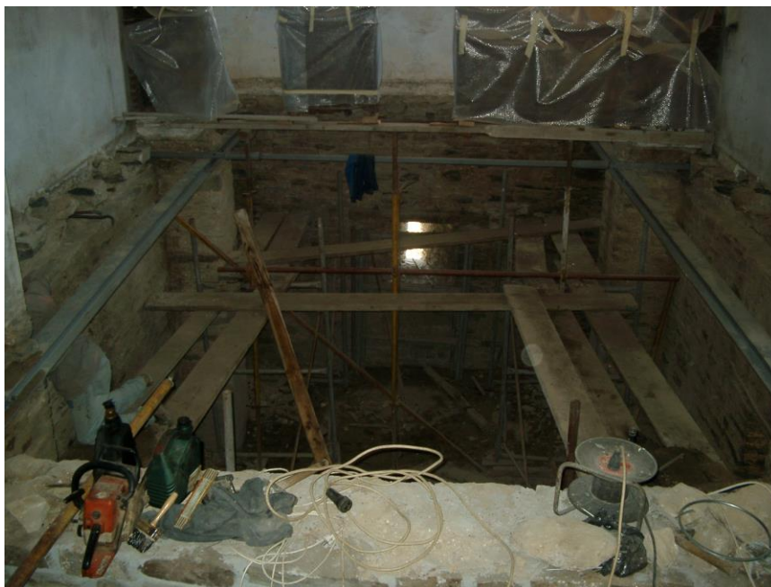
Φωτογραφία 115: Μεταλλικές δοκοί
