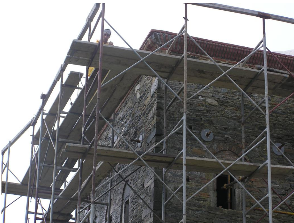
Φωτογραφία 86: Επισκευή γειώματος με συμπαγείς κεραμικές πλάκες
