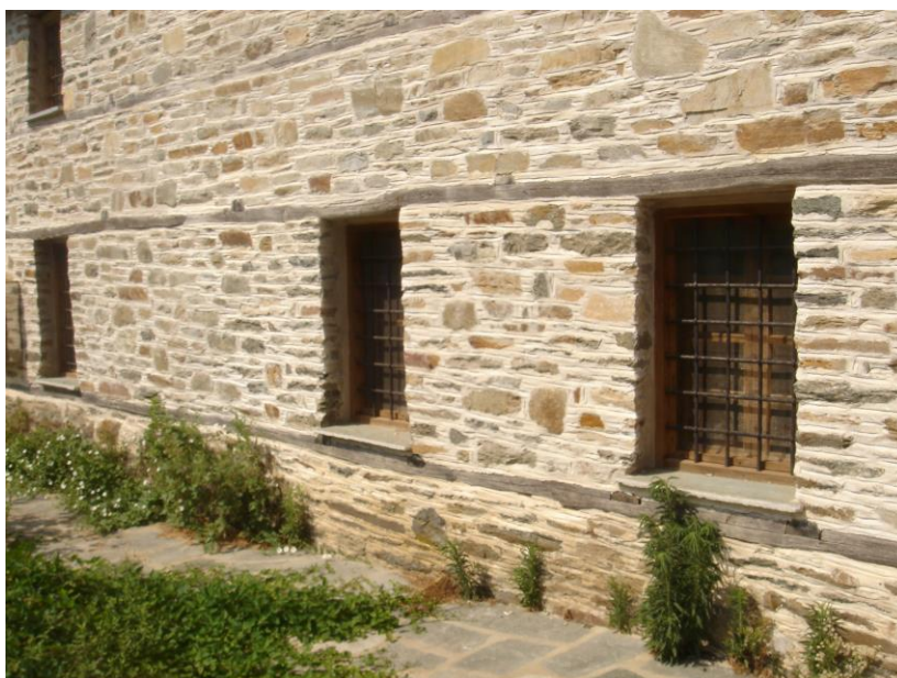
Φωτογραφία 139: Ποδιές παραθύρων από σχιστόπλακα-Προστατευτικές σιδεριές
