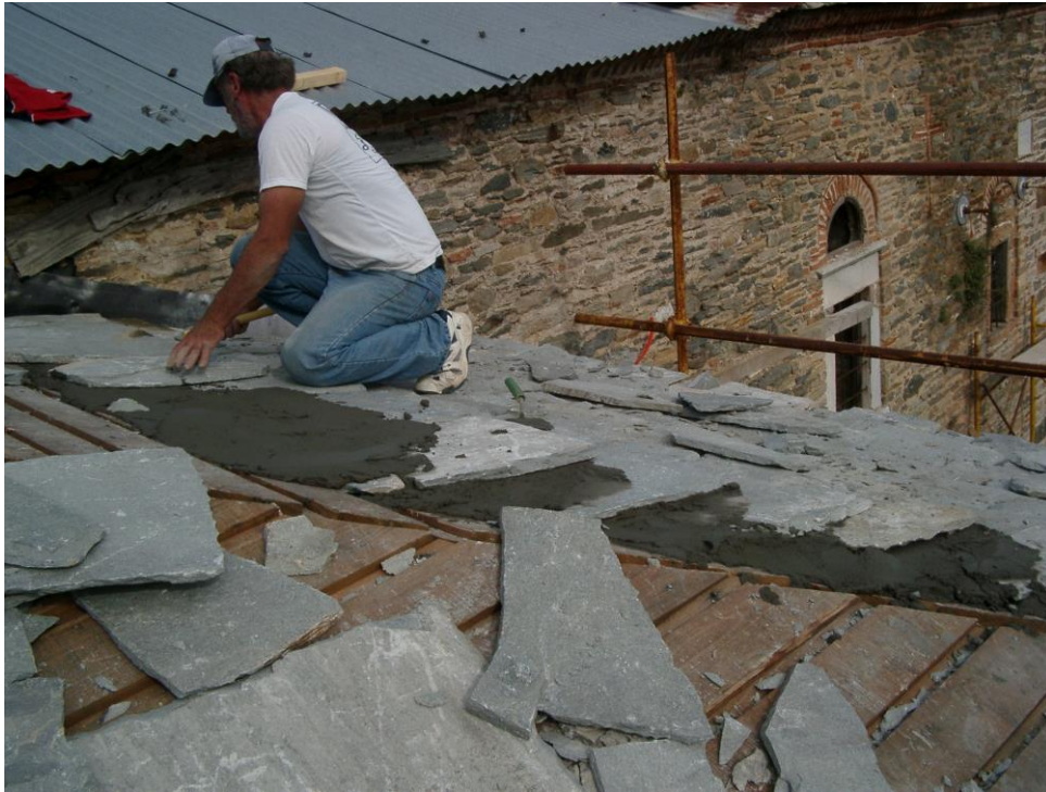
Φωτογραφία 80: Διάστρωση σχιστόπλακας στέγης
