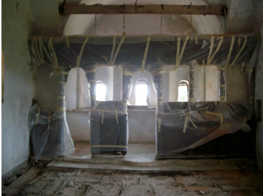
Φωτογραφία 112: Ανάρτηση τέμπλου - Αποξήλωση μαρμαρίνου δαπέδου
