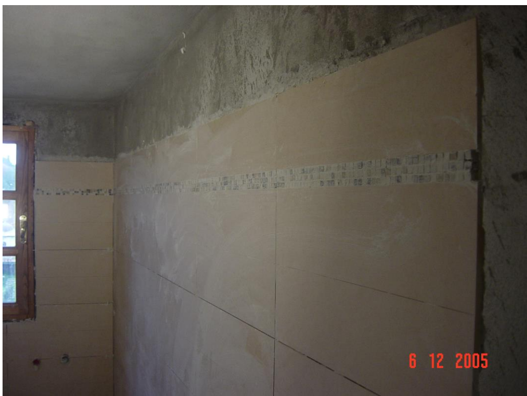
Φωτογραφία 105: Τοποθέτηση κεραμικών πλακιδίων
