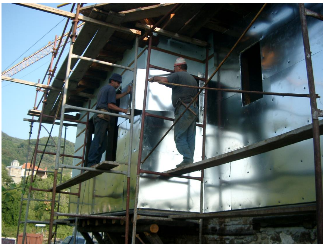
Φωτογραφία 94: Τοποθέτηση προστατευτικών φύλλων λαμαρίνας
