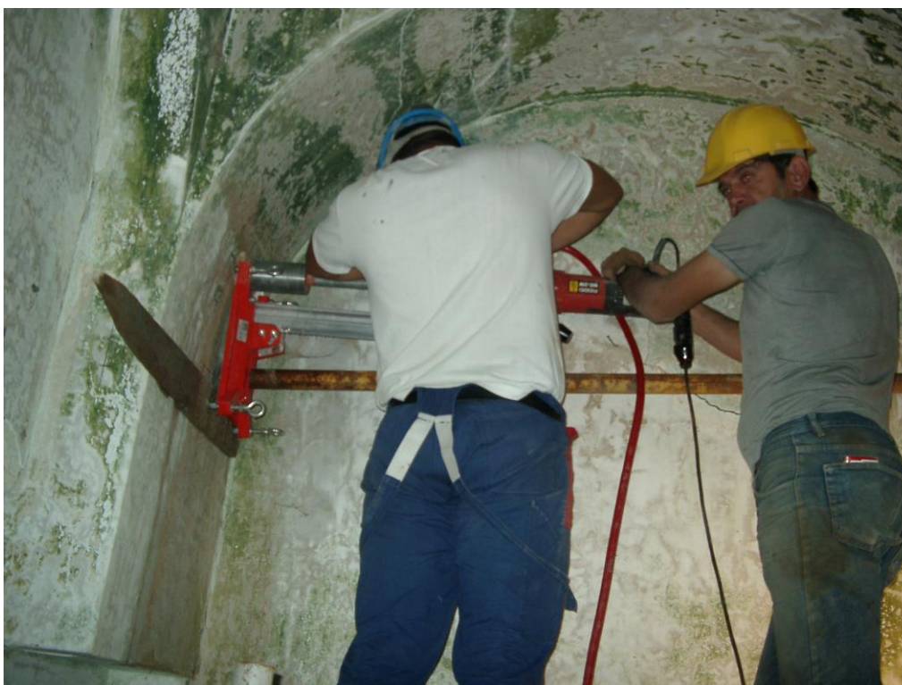
Φωτογραφία 116: Διάτρηση λιθοδομών
