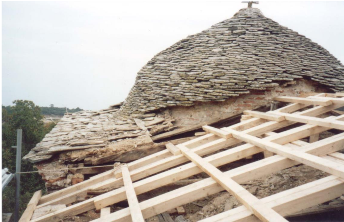
Φωτογραφία 15: Προστασία στέγης εκκλησίας
