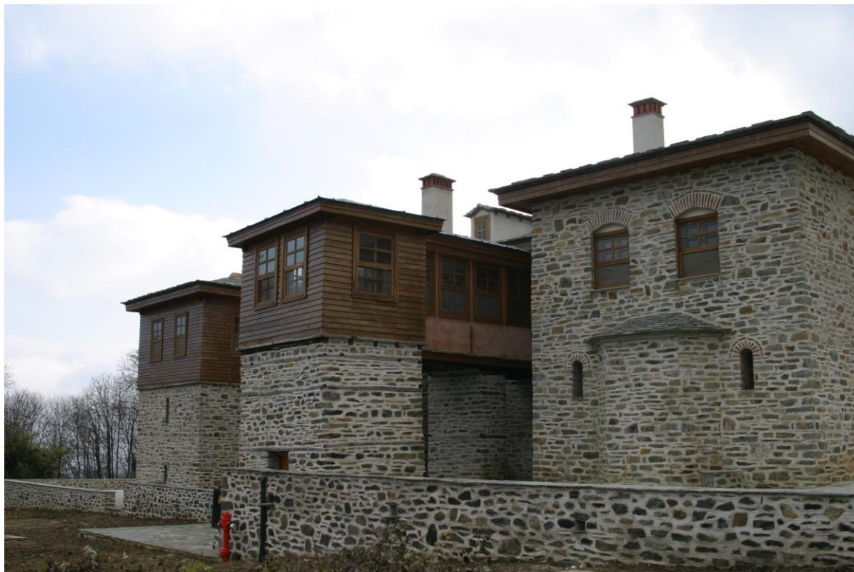
Φωτογραφία 211: Δυτική και Βόρεια όψεις του Αντιπροσωπείου (Ολοκληρωμένο)
