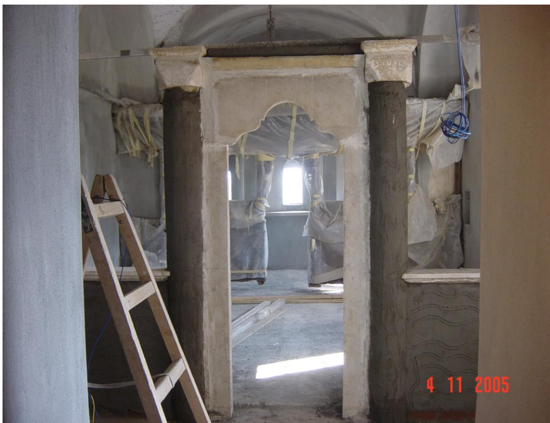
Φωτογραφία 123: Αποκατάσταση Λητής - Επιχρίσματα
