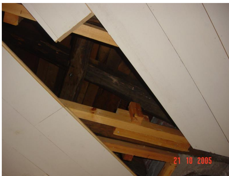
Φωτογραφία 161: Κατασκευή ψευδοτάβανου
