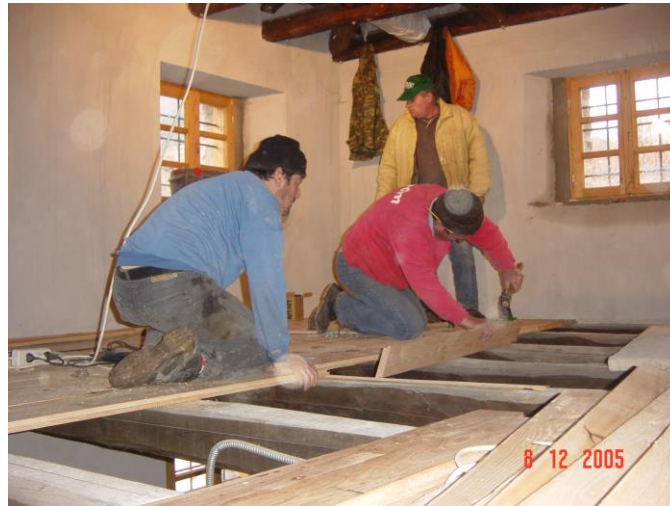
Φωτογραφία 151: Τοποθέτηση ξύλινων πατωμάτων
