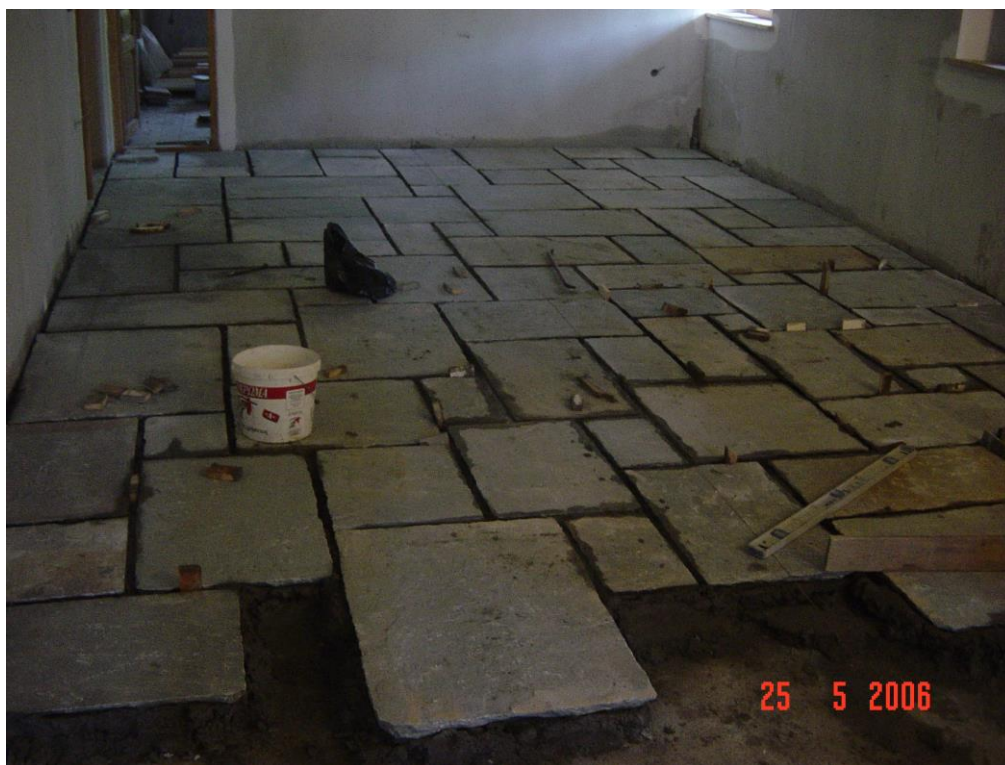
Φωτογραφία 132: Διάστρωση δαπέδου με σχιστόπλακα
