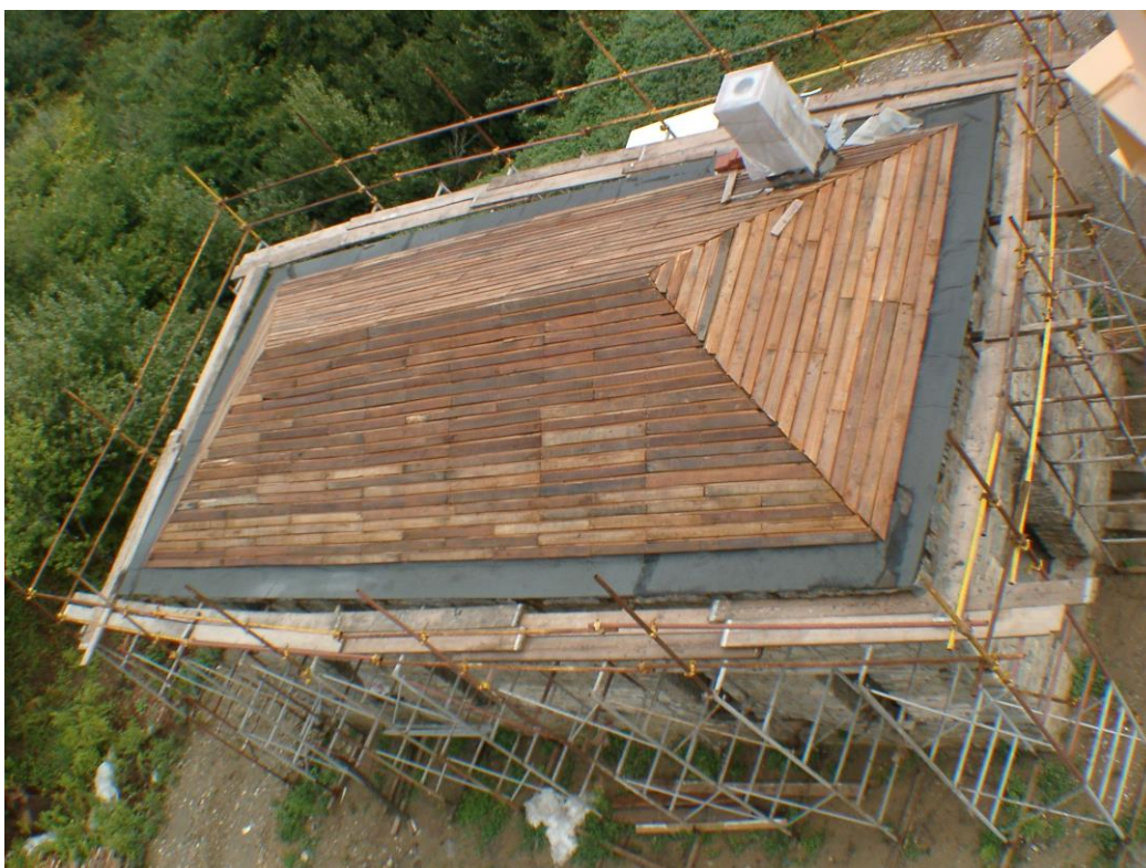
Φωτογραφία 72: Πέτσωμα στέγης ολοκληρωμένο
