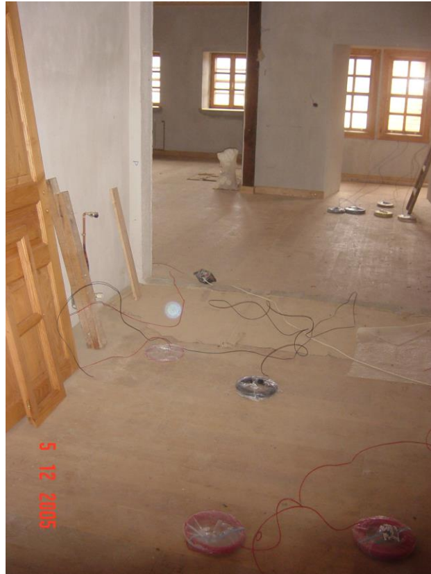
Φωτογραφία 153: Τοποθέτηση ξύλινων σοβατεπιών
