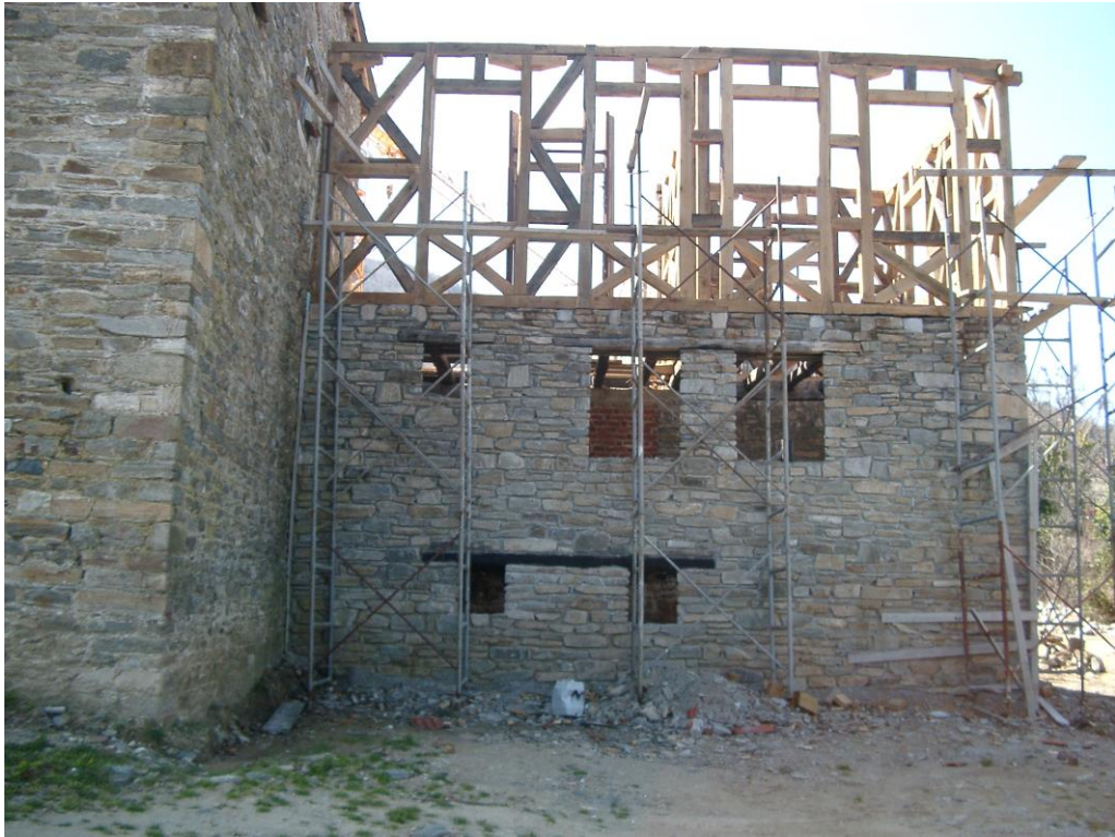
Φωτογραφία 49: Ξύλινοι σκελετοί τοίχων
