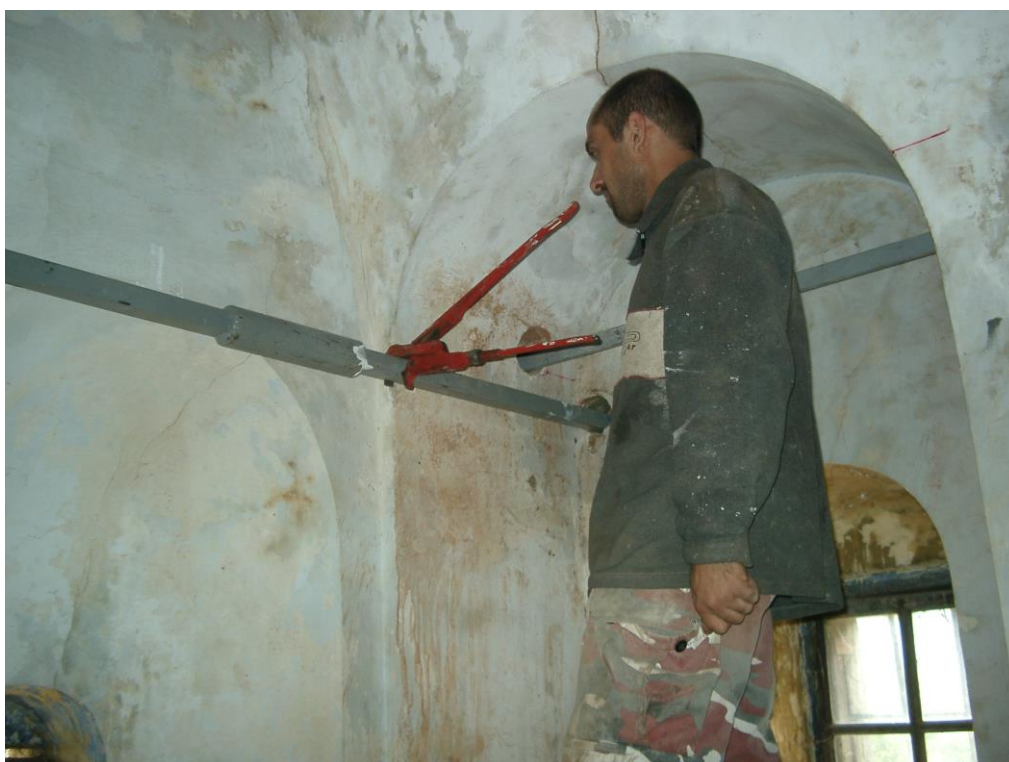
Φωτογραφία 117: Τοποθέτηση μεταλλικών ελκυστήρων
