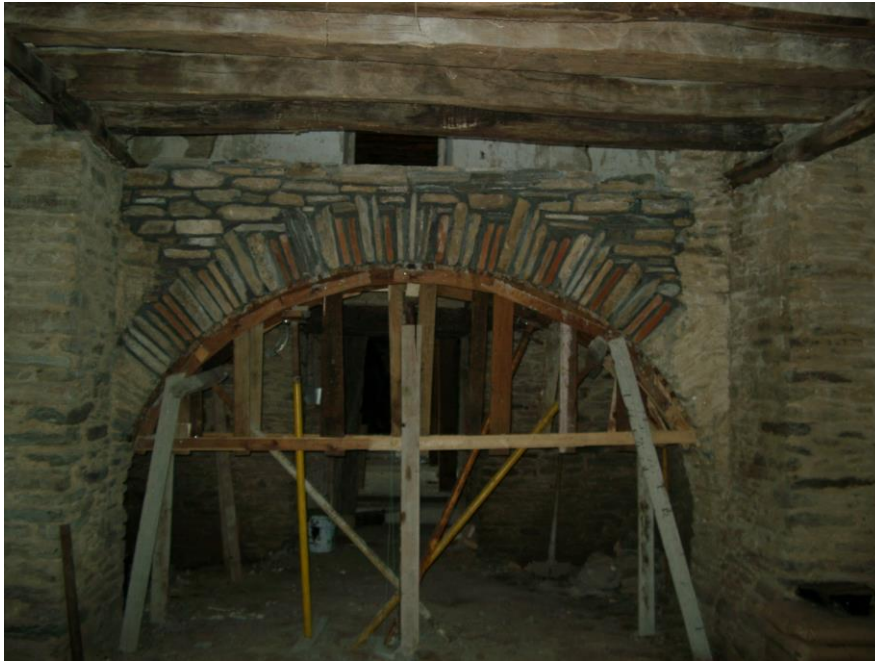
Φωτογραφία 114: Αναδόμηση τόξου
