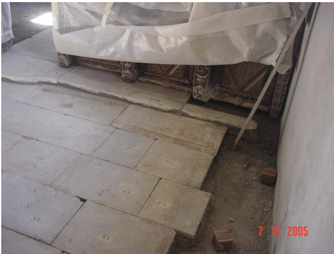
Φωτογραφία 125: Επανατοποθέτηση μαρμάρινων πλακών
