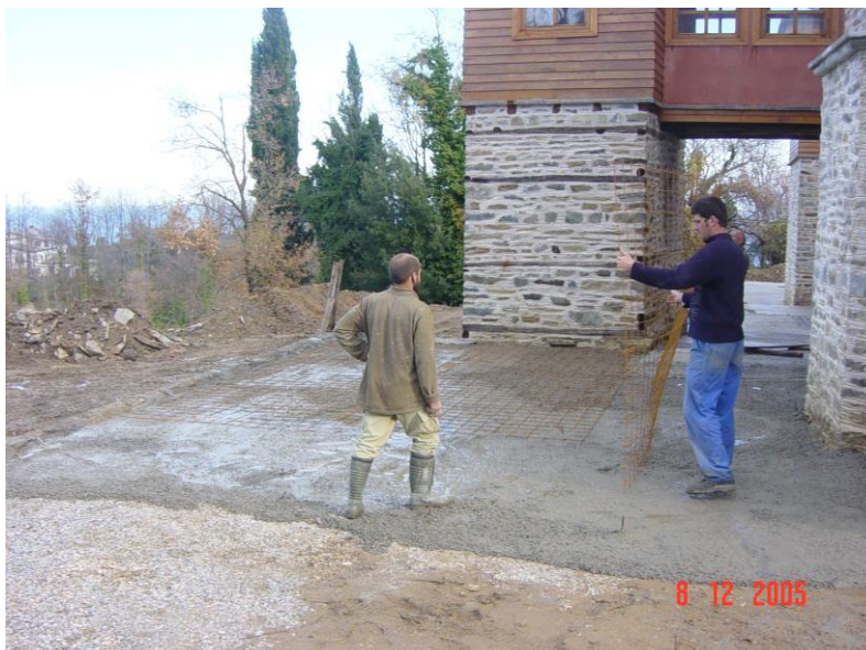
Φωτογραφία 171: Διάστρωση σκυροδέματος με δομικό πλέγμα
