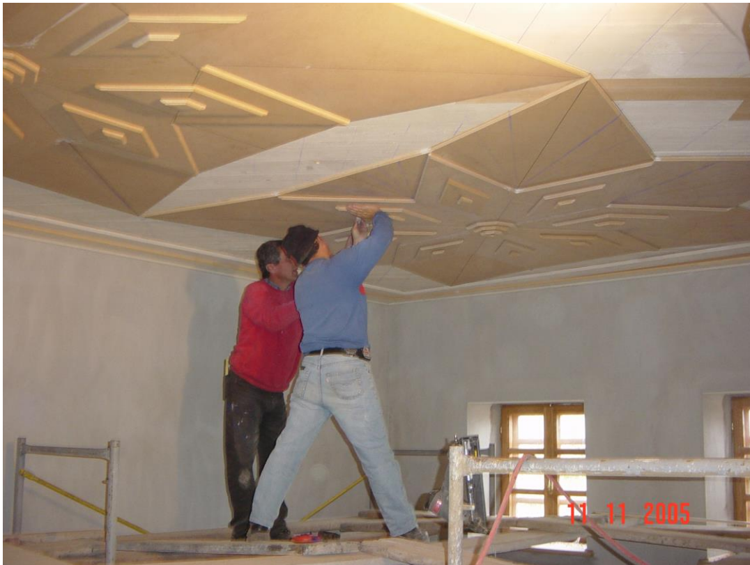
Φωτογραφία 163: Κατασκευή σχεδίου περίτεχνου ταβανώματος
