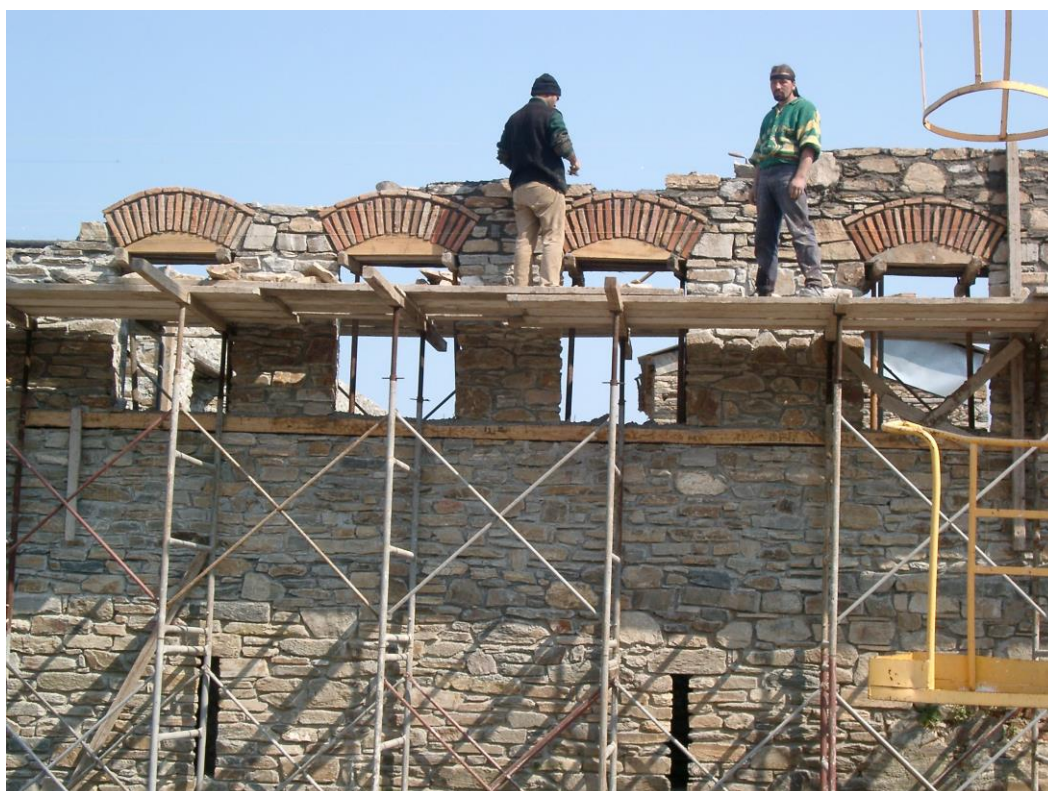
Φωτογραφία 40: Δομήσεις λιθοδομών ορόφου
