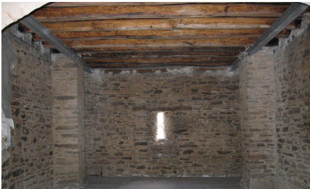
Φωτογραφία 122: Τοποθέτηση νέων πατόξυλων - Ψευτοπατώματος
