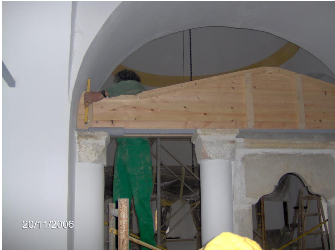
Φωτογραφία 124: Αποκατάσταση Λητής - Επιχρίσματα
