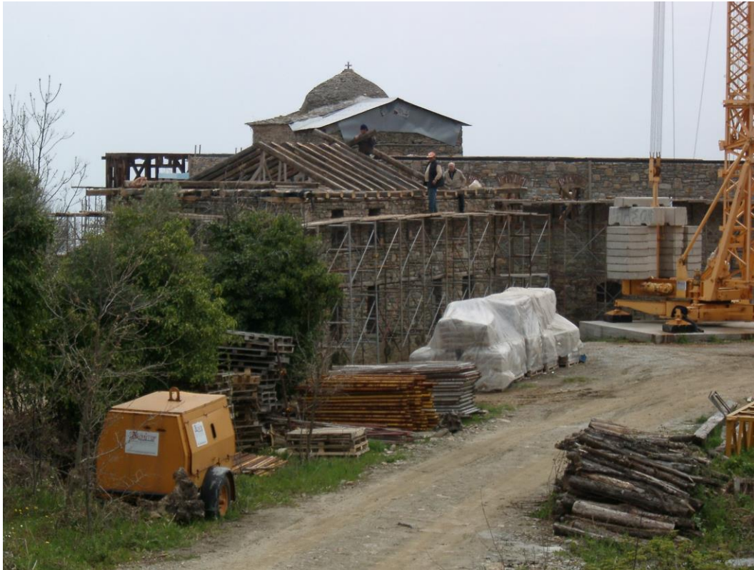
Φωτογραφία 61: Ξύλινος σκελετός στέγης
