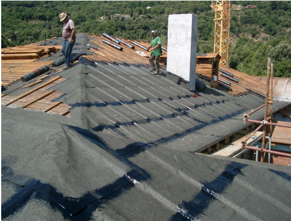
Φωτογραφία 70: Διάστρωση ασφαλτόπανου
