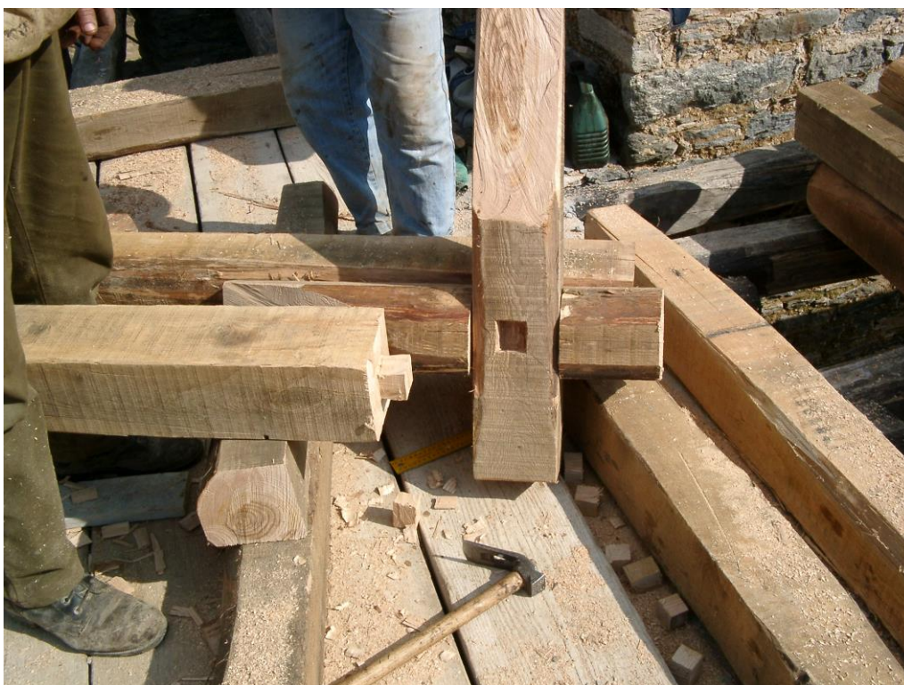
Φωτογραφία 45: Κατασκευαστική λεπτομέρεια ξύλινων σκελετών τοίχων
