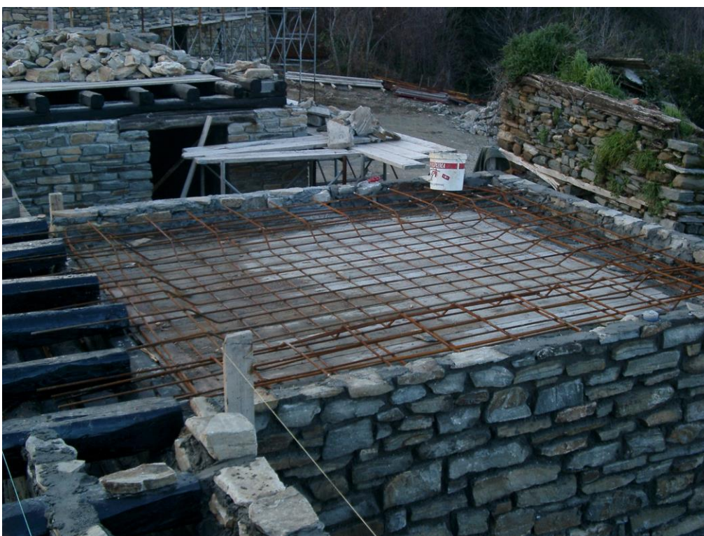
Φωτογραφία 42: Πλάκα σκυροδέματος χώρων υγιεινής
