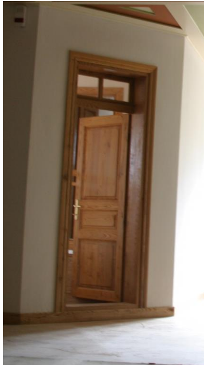
Φωτογραφία 149: Εσωτερική ταμπλαδωτή πόρτα με φεγγίτη
