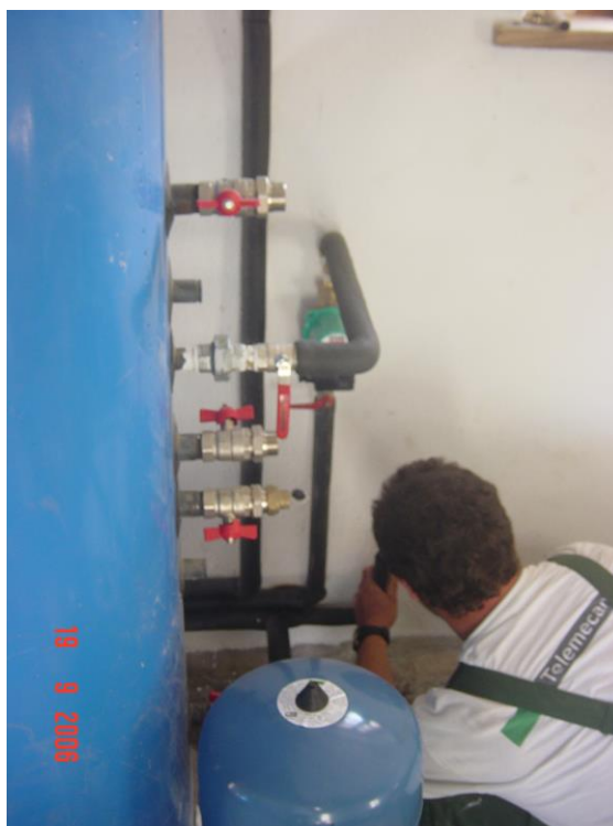
Φωτογραφία 182: Συνδέσεις ηλεκτρομηχανολογικών εγκαταστάσεων
