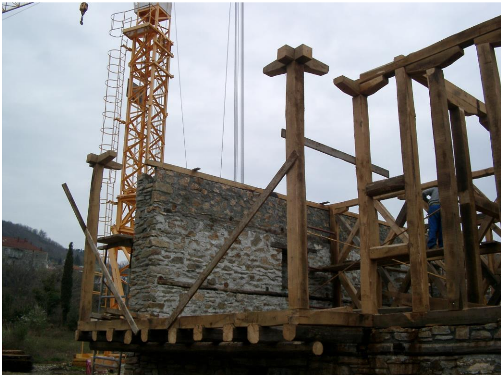
Φωτογραφία 50: Ξύλινοι σκελετοί τοίχων
