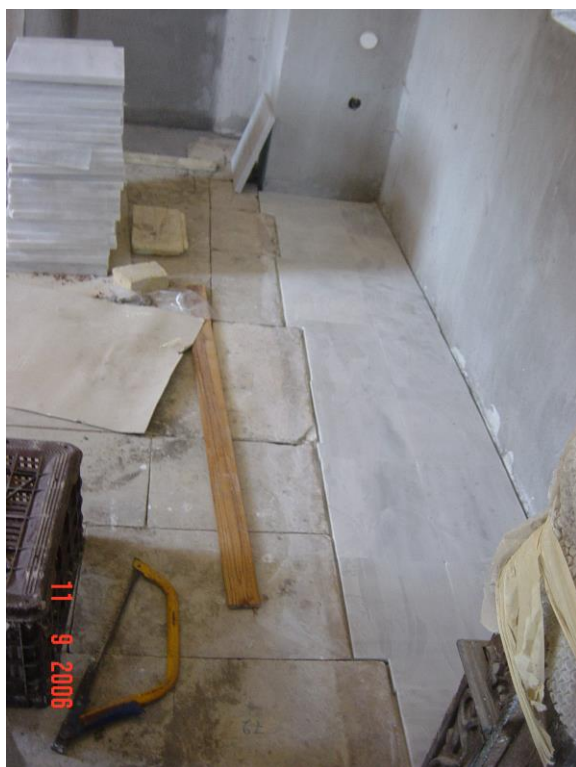
Φωτογραφία 126: Αποκατάσταση δαπέδου με νέες μαρμάρινες πλάκες
