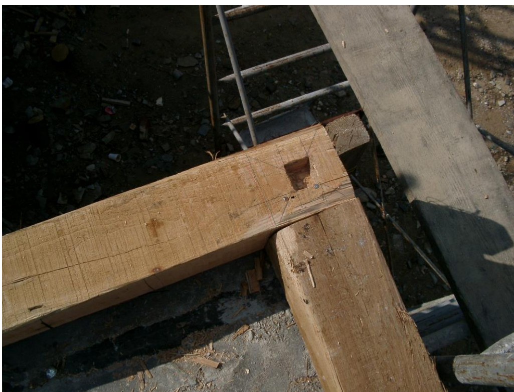
Φωτογραφία 46: Κατασκευαστική λεπτομέρεια ξύλινων σκελετών τοίχων
