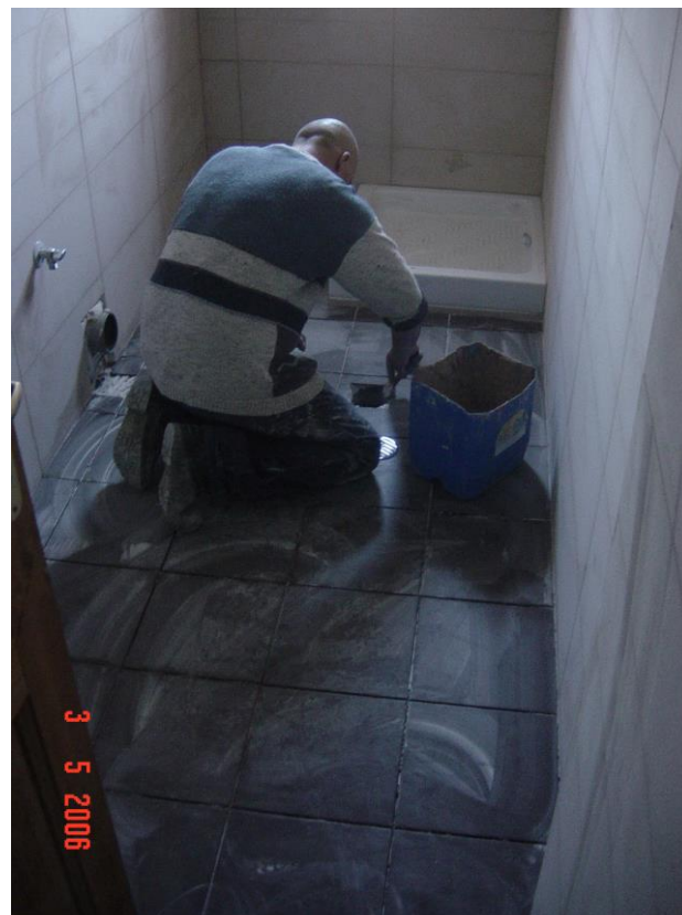
Φωτογραφία 154: Διάστρωση δαπέδου με κεραμικά πλακίδια
