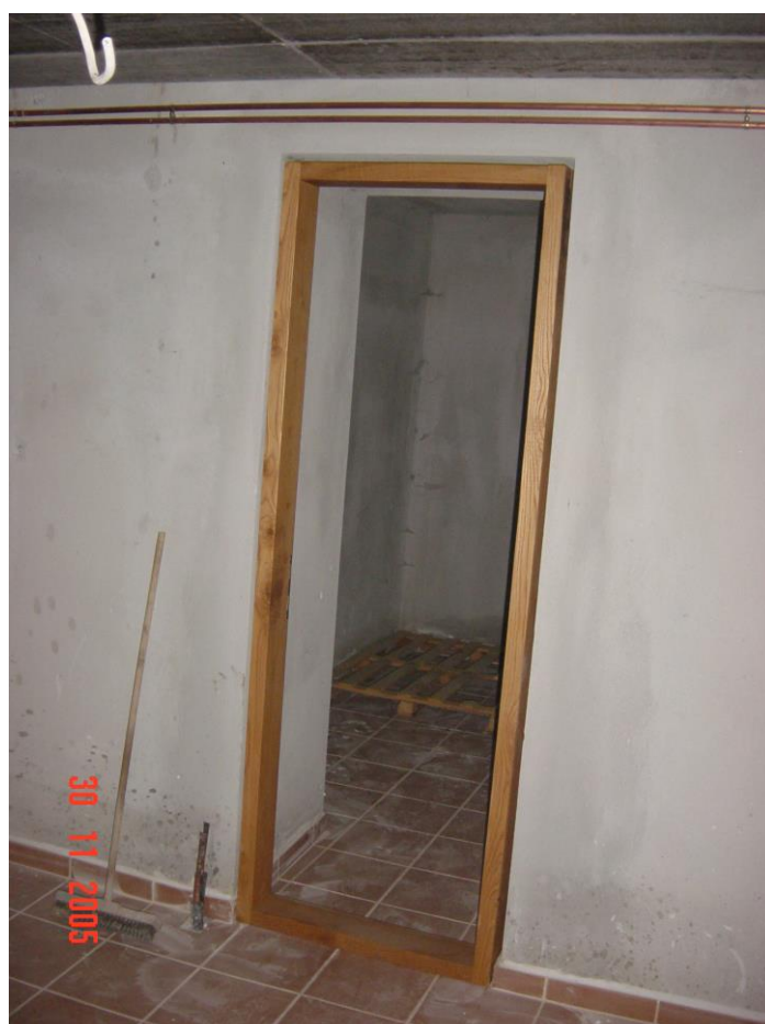
Φωτογραφία 156: Διάστρωση δαπέδου με κεραμικά πλακίδια
