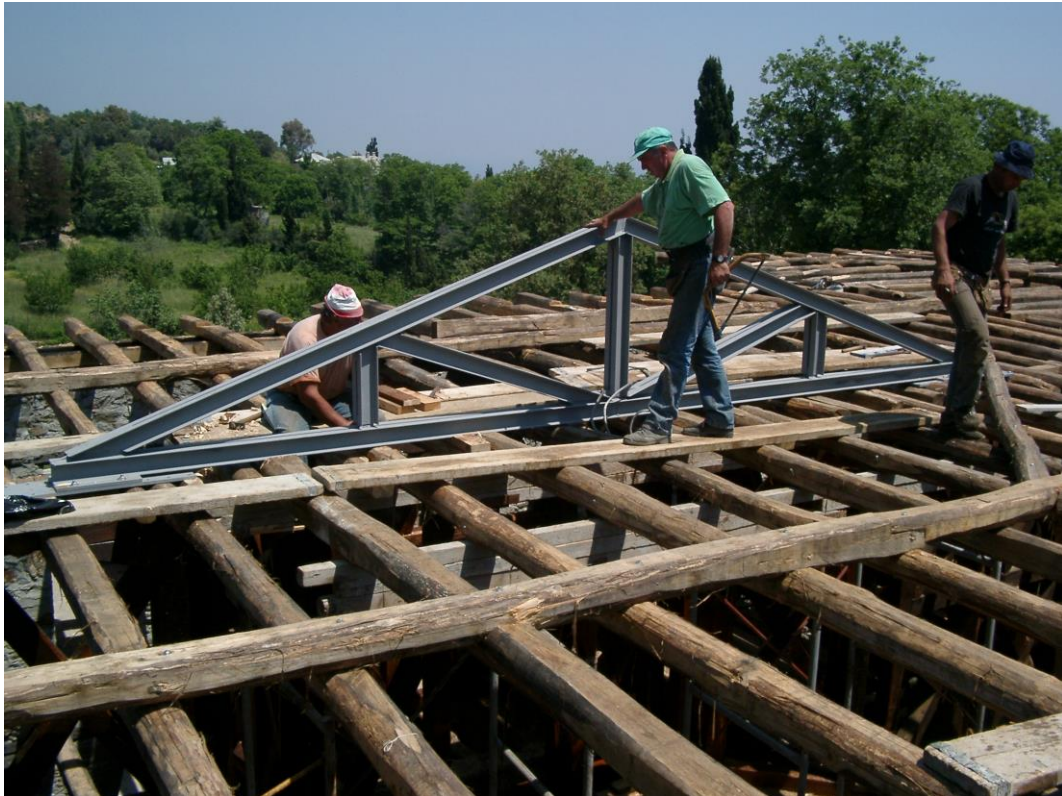
Φωτογραφία 59: Μεταλλικό ζευκτό στέγης
