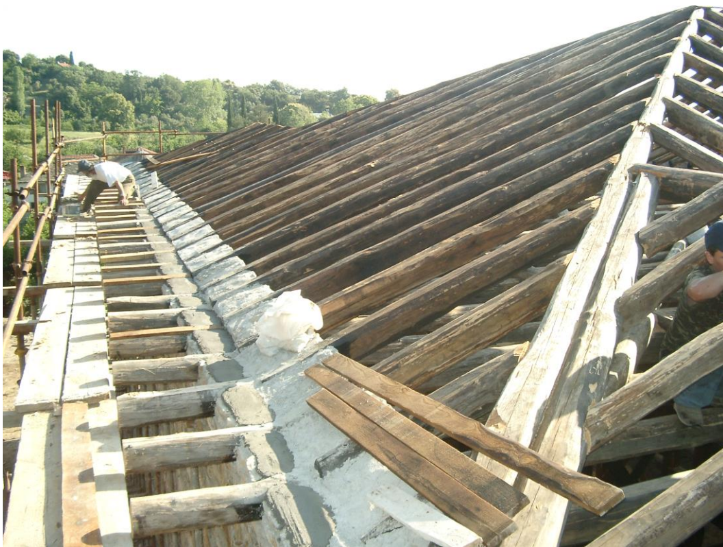
Φωτογραφία 64: Λεπτομέρεια ξύλινου σκελετού στέγης
