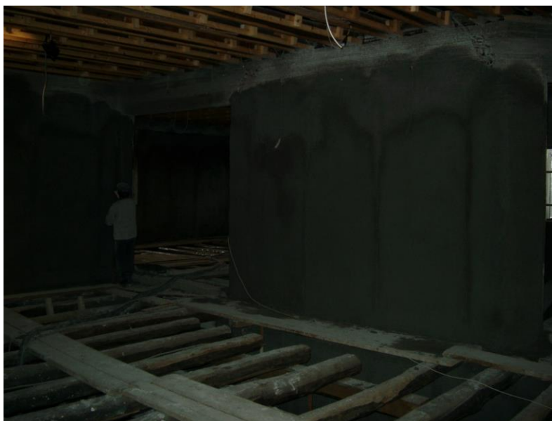
Φωτογραφία 97: Εσωτερικά επιχρίσματα (Δεύτερο χέρι)
