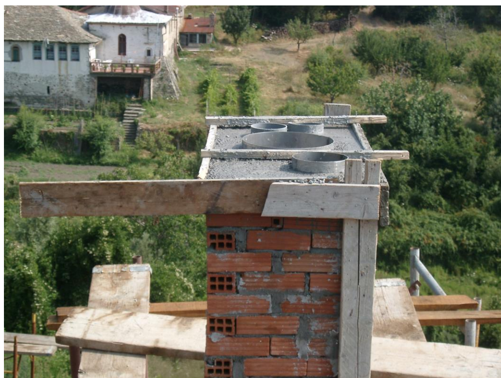
Φωτογραφία 69: Δόμηση καμινάδας
