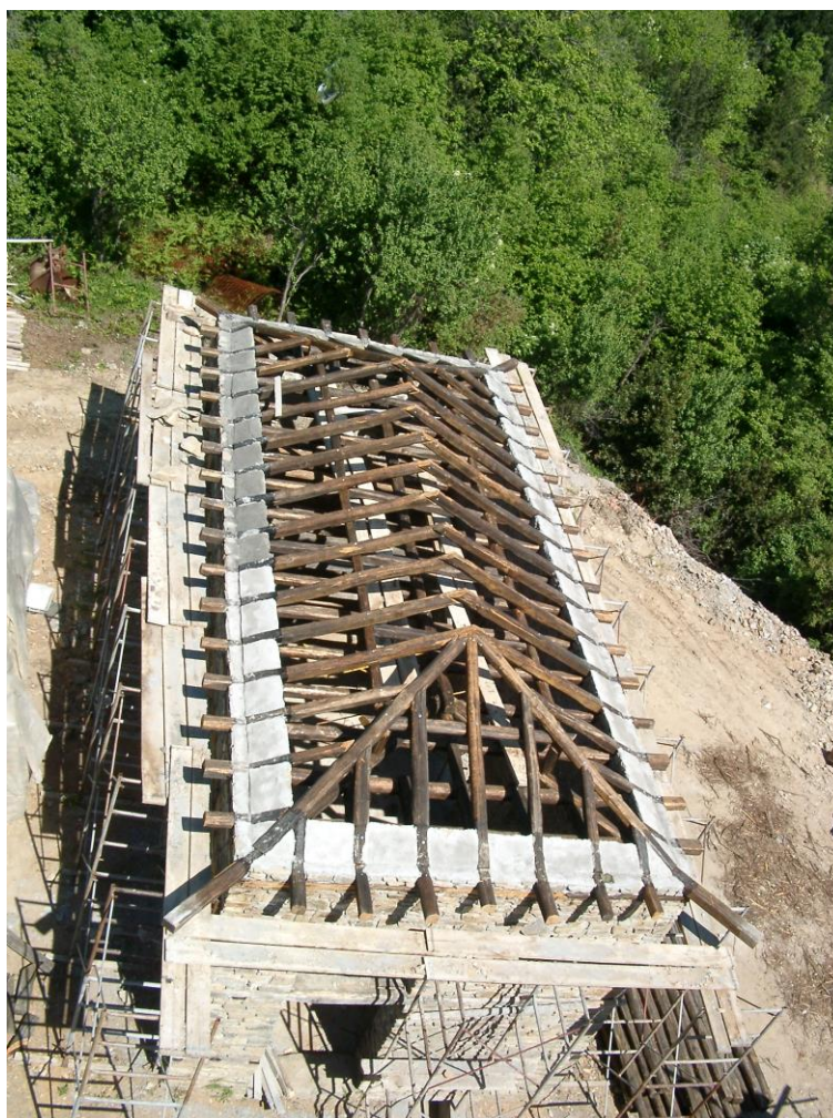
Φωτογραφία 65: Ξύλινος σκελετός στέγης
