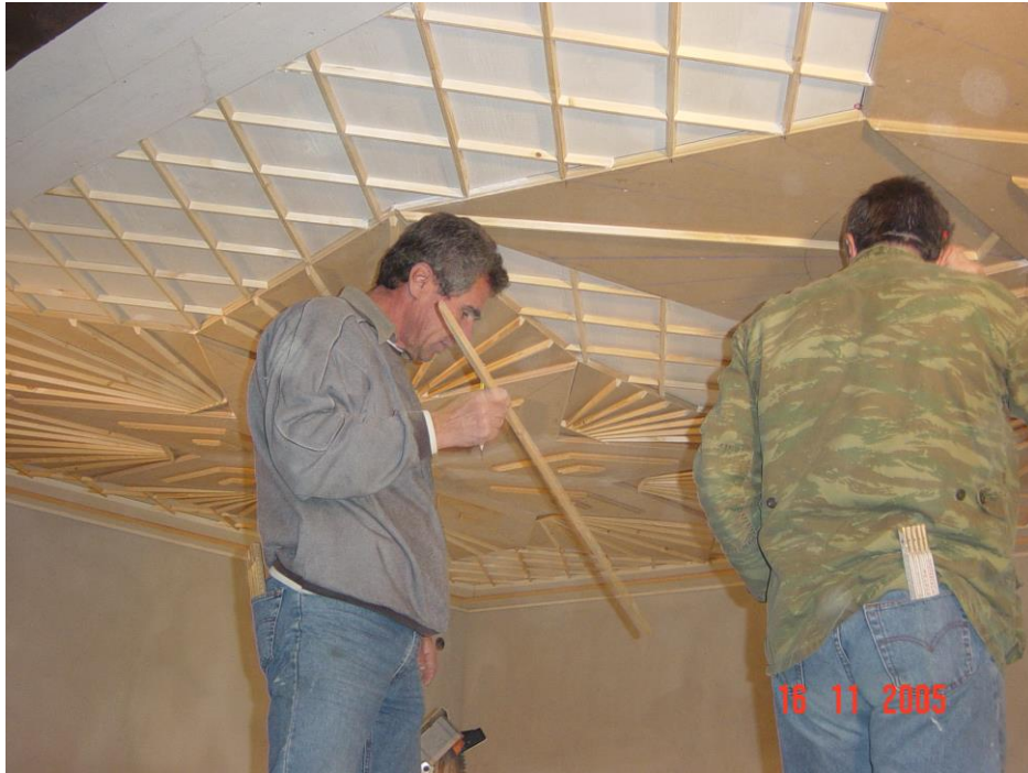
Φωτογραφία 164: Κατασκευή σχεδίου περίτεχνου ταβανώματος
