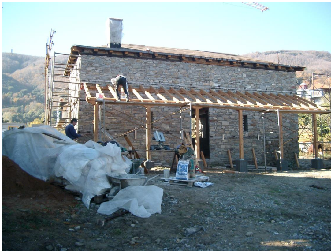
Φωτογραφία 185: Κατασκευή σκελετού στεγάστρου
