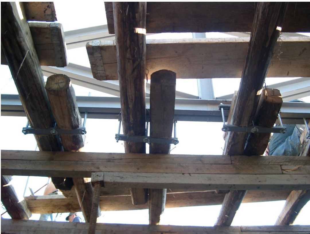
Φωτογραφία 60: Λεπτομέρεια σύνδεσης μεταλλικού ζευκτού στέγης
