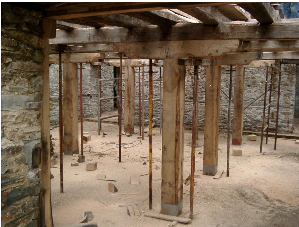
Φωτογραφία 38: Ξύλινοι σκελετοί πατωμάτων-Κολώνες-Μαξιλάρια-Ποταμοί
