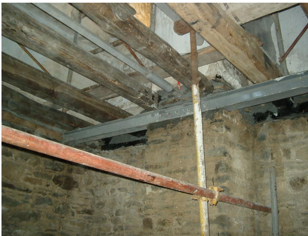
Φωτογραφία 121: Τοποθέτηση νέων πατόξυλων
