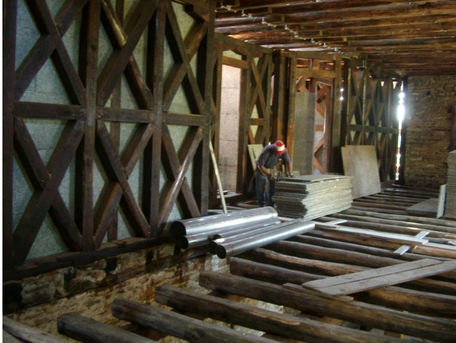
Φωτογραφία 87: Τοποθέτηση πλακών Ηρακλίτη
