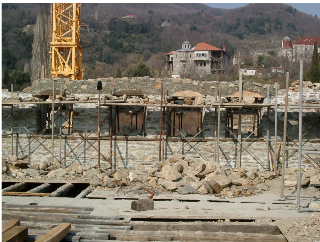
Φωτογραφία 39: Δομήσεις λιθοδομών ορόφου
