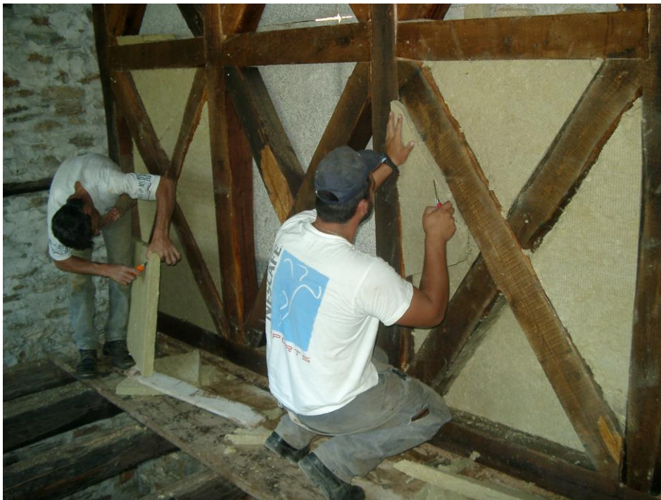
Φωτογραφία 88: Τοποθέτηση παπλώματος πετροβάμβακα
