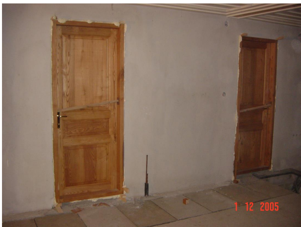
Φωτογραφία 148: Εσωτερικές ταμπλαδωτές πόρτες
