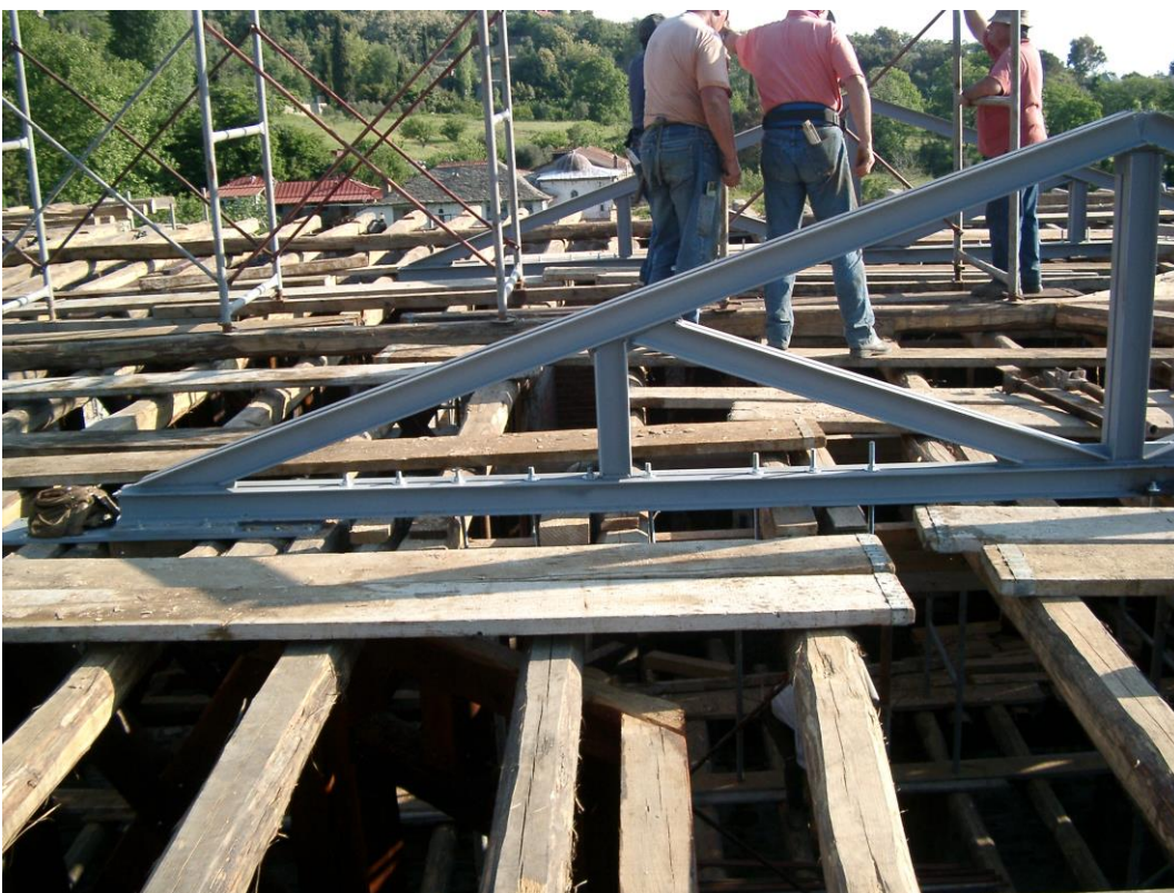
Φωτογραφία 58: Μεταλλικά ζευκτά στέγης
