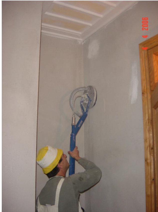
Φωτογραφία 191: Επεξεργασία τοίχων πριν τους χρωματισμούς
