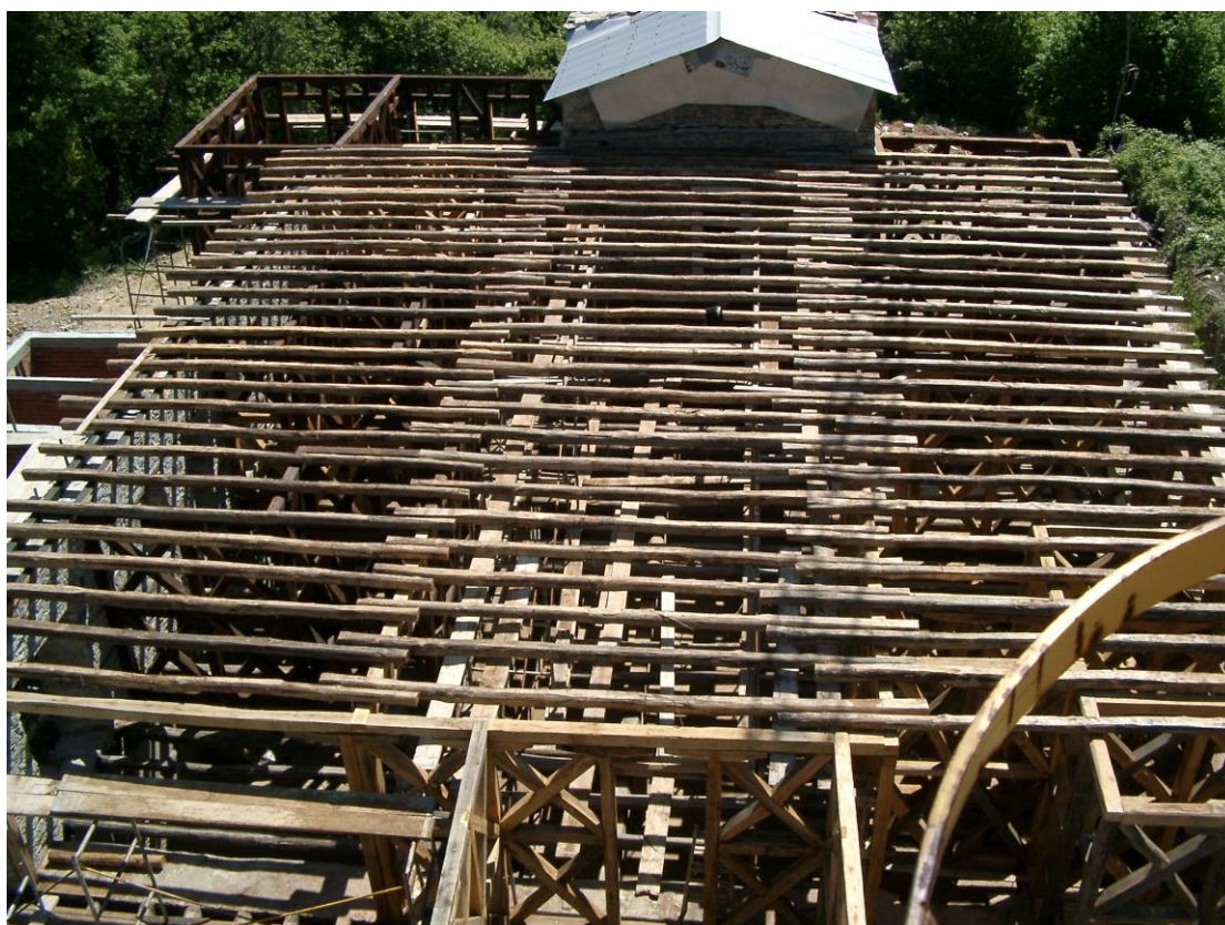
Φωτογραφία 54: Ξύλινος σκελετός στέγης
