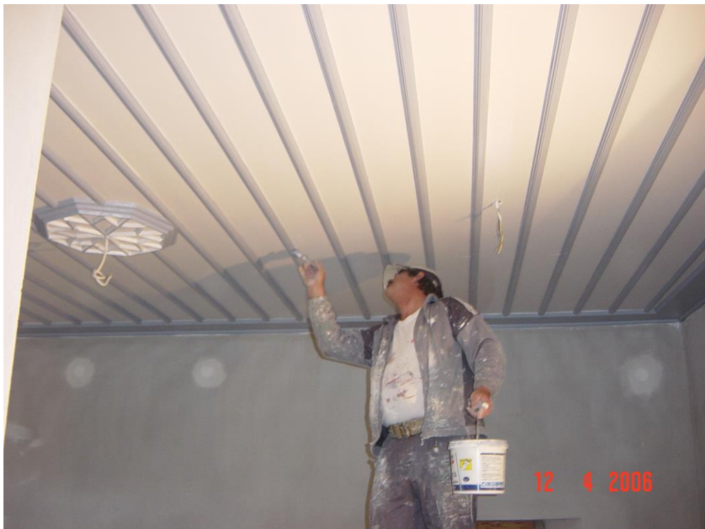
Φωτογραφία 192: Χρωματισμοί απλών ταβανωμάτων
