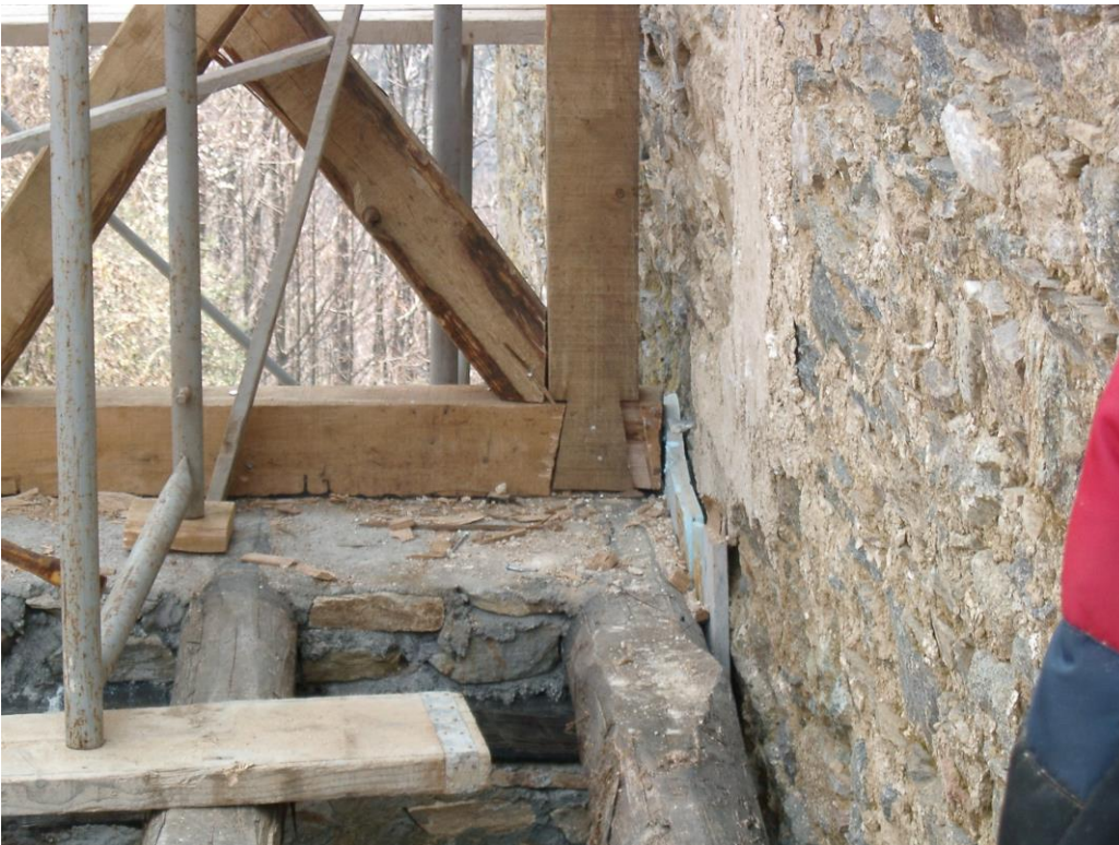
Φωτογραφία 48: Κατασκευαστική λεπτομέρεια ξύλινων σκελετών τοίχων
