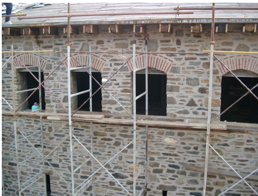
Φωτογραφία 78: Αρμολόγημα ολοκληρωμένο
