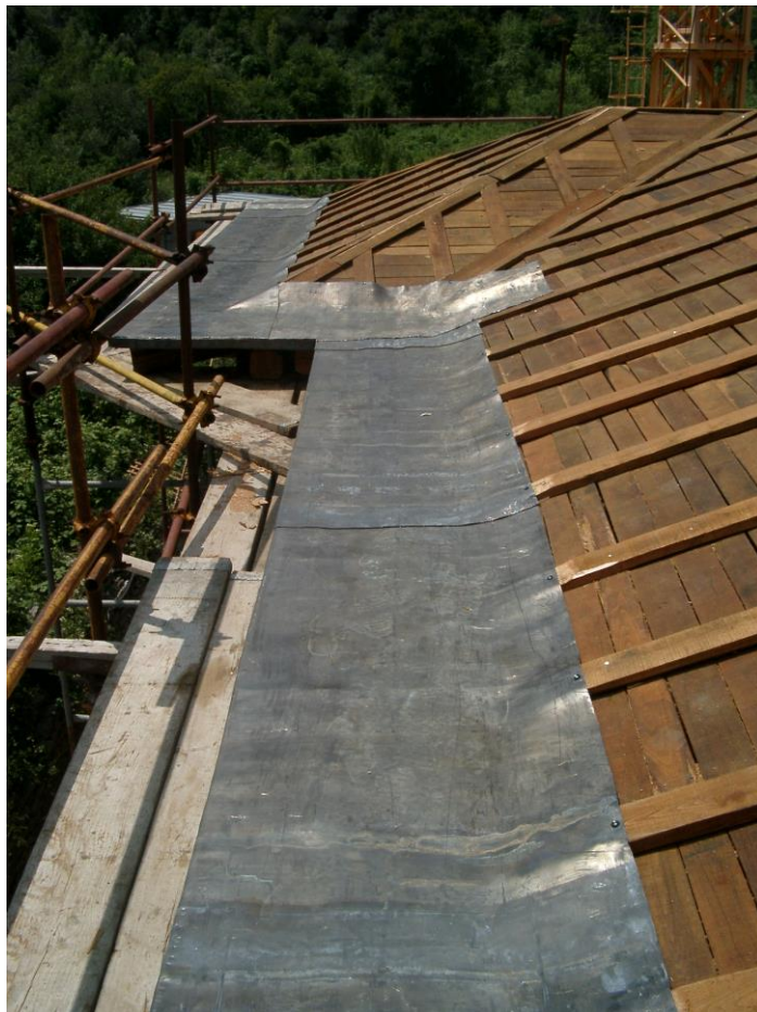
Φωτογραφία 67: Φύλλο μολυβιού γείσου στέγης
