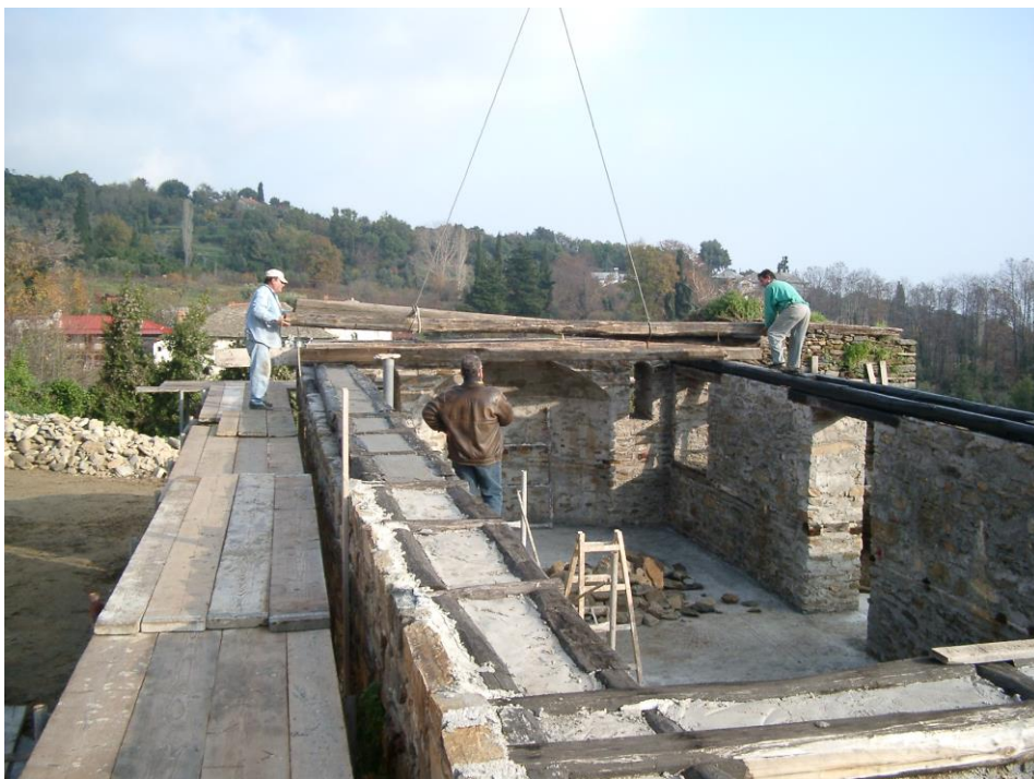
Φωτογραφία 36: Ξύλινοι σκελετοί πατωμάτων
