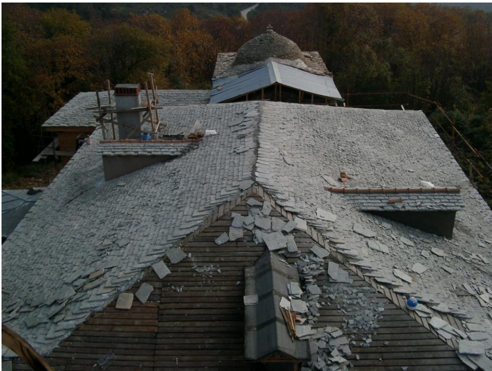
Φωτογραφία 81: Διάστρωση σχιστόπλακας στέγης
