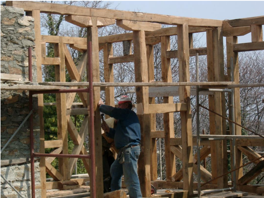
Φωτογραφία 44: Ξύλινοι σκελετοί τοίχων
