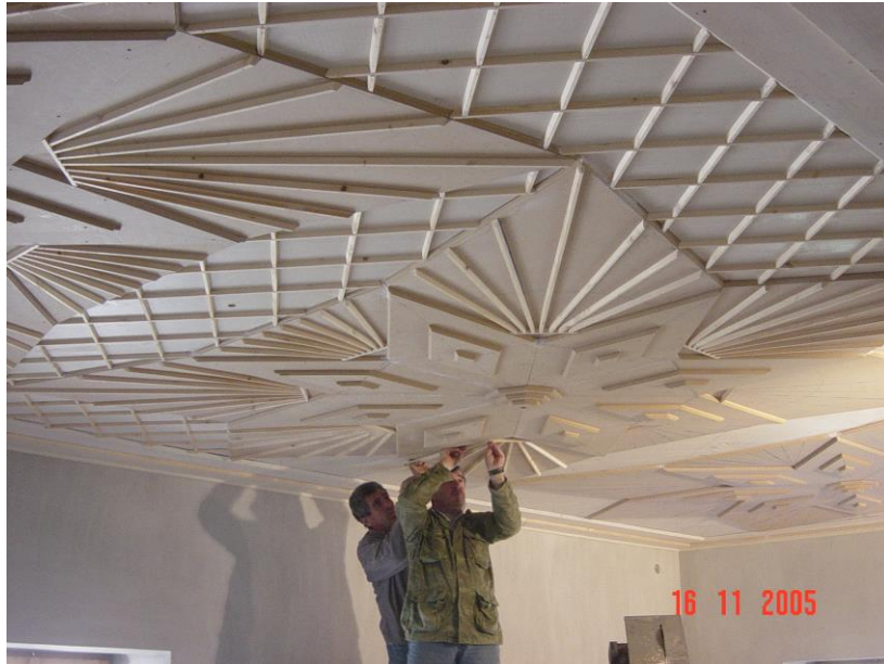
Φωτογραφία 166: Κατασκευή σχεδίου περίτεχνου ταβανώματος
