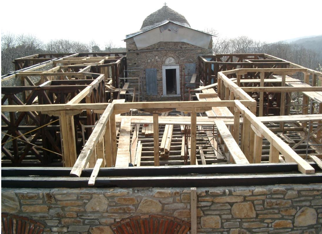
Φωτογραφία 51: Ξύλινοι σκελετοί τοίχων
