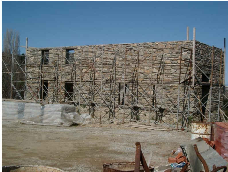
Φωτογραφία 52: Κατασκευή λιθοδομών (Βουρδουναριό)
