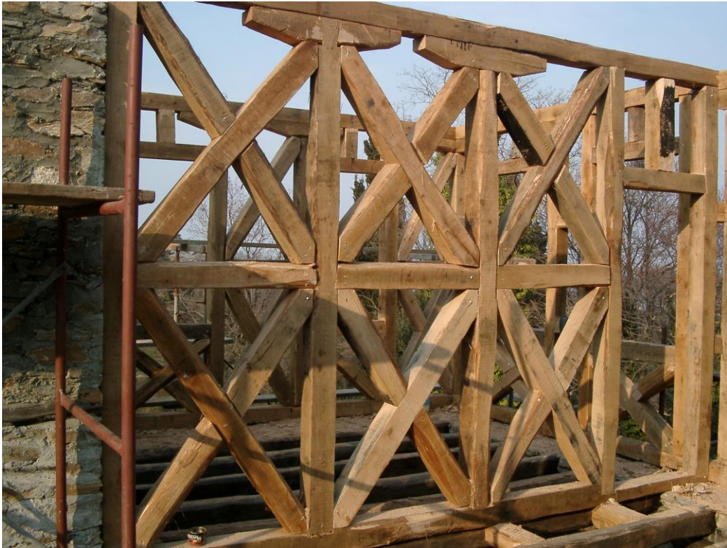
Φωτογραφία 43: Ξύλινοι σκελετοί τοίχων
