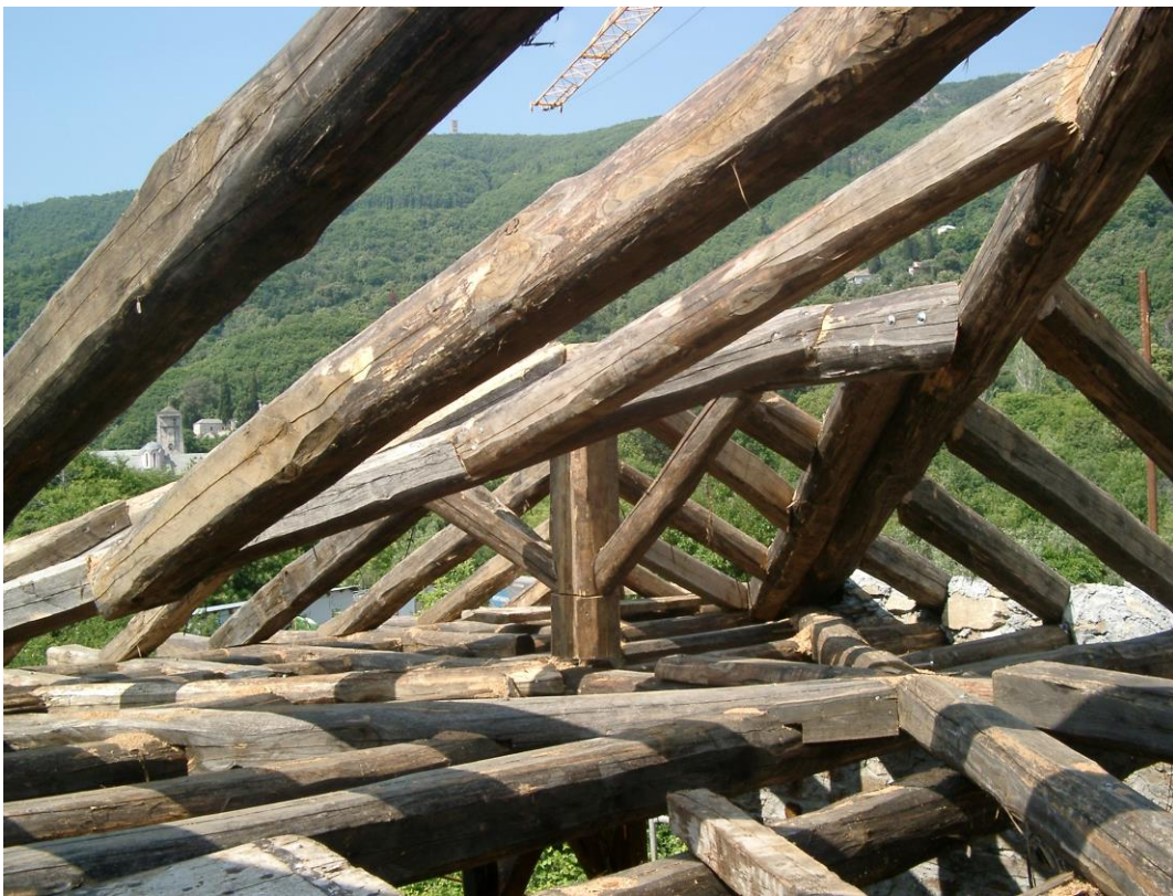
Φωτογραφία 62: Λεπτομέρεια ξύλινου σκελετού στέγης
