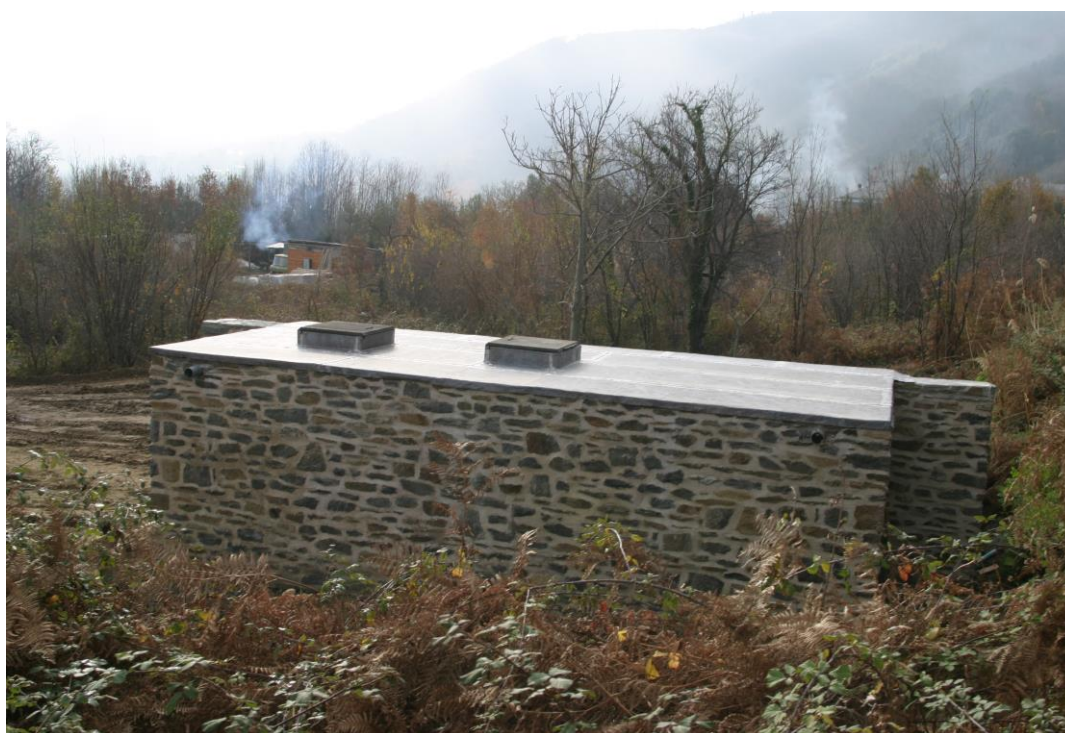
Φωτογραφία 179: Επένδυση τοιχίου δεξαμενής καυσίμων με λιθοδομή
