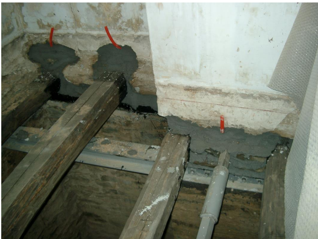
Φωτογραφία 120: Τοποθέτηση νέων πατόξυλων
