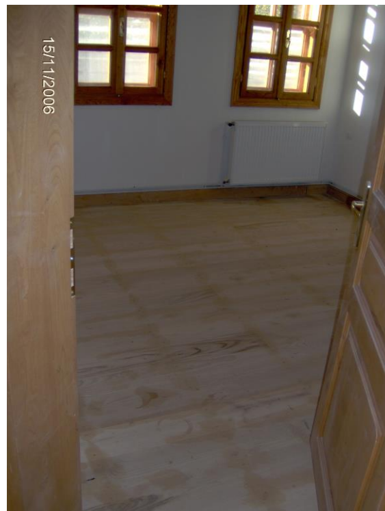
Φωτογραφία 152: Τοποθέτηση ξύλινων πατωμάτων
