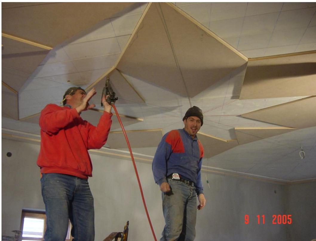
Φωτογραφία 162: Κατασκευή σχεδίου περίτεχνου ταβανώματος
