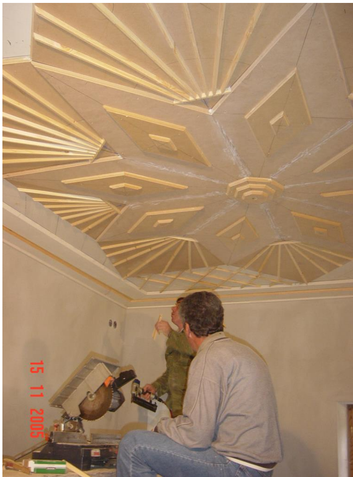
Φωτογραφία 165: Κατασκευή σχεδίου περίτεχνου ταβανώματος
