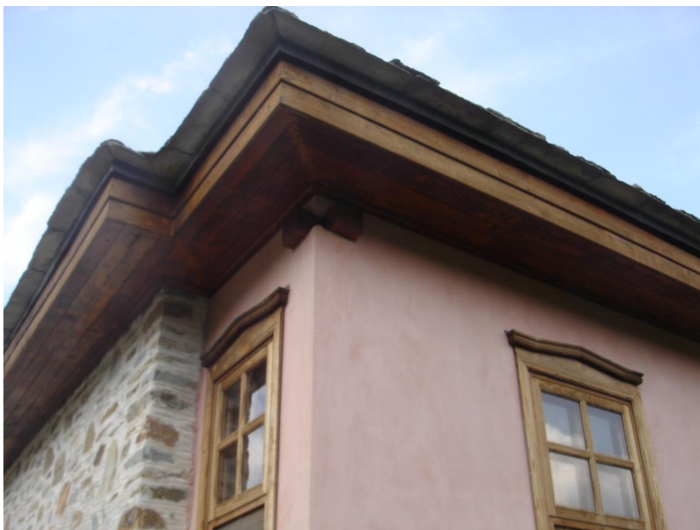
Φωτογραφία 137: Ξύλινες κορνίζες κουφωμάτων
