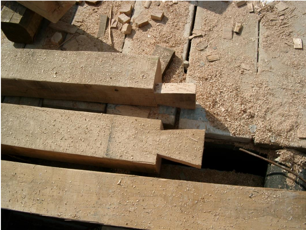
Φωτογραφία 47: Κατασκευαστική λεπτομέρεια ξύλινων σκελετών τοίχων
