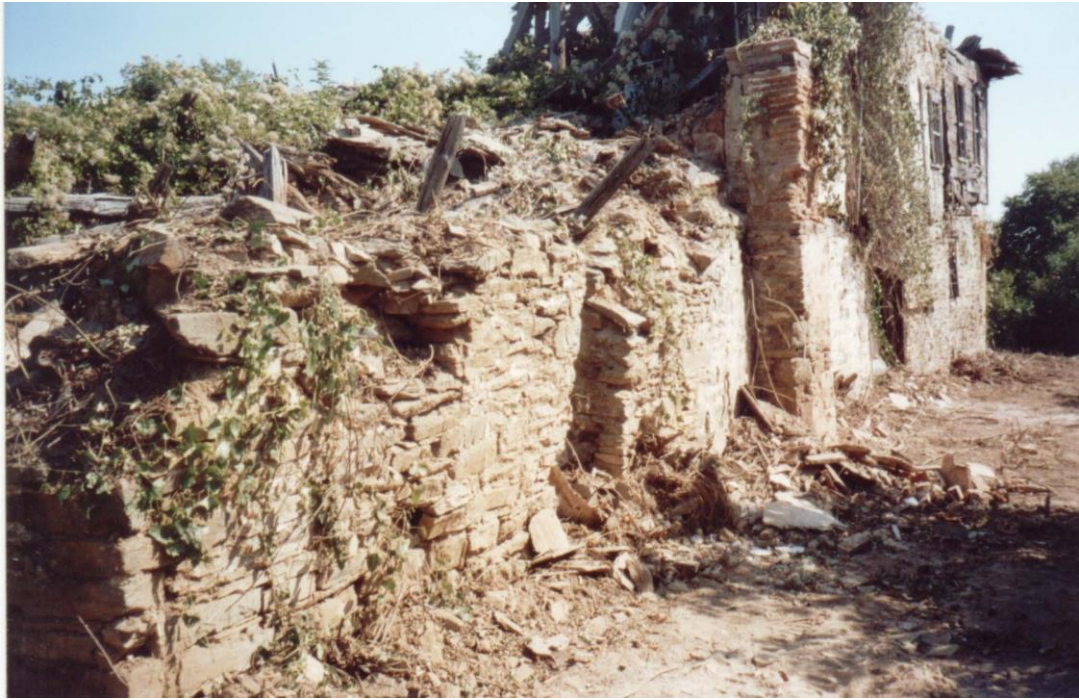
Φωτογραφία 11: Κατά την διάρκεια του καθαρισμού
