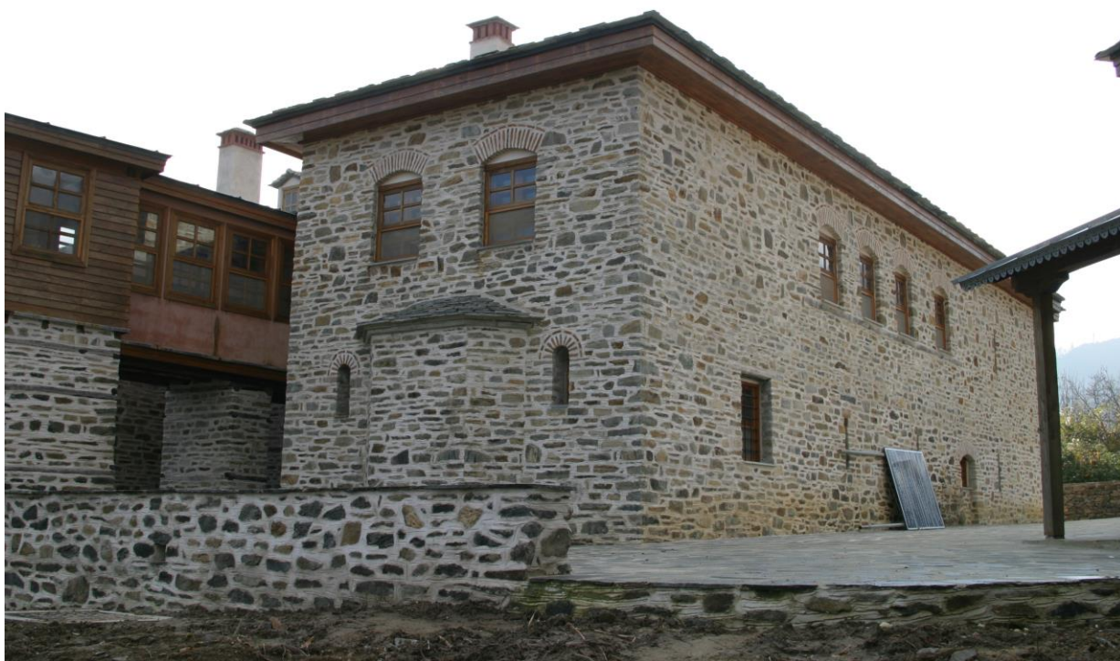
Φωτογραφία 209: Δυτική και Βόρεια όψεις του Αντιπροσωπείου (Ολοκληρωμένο)
