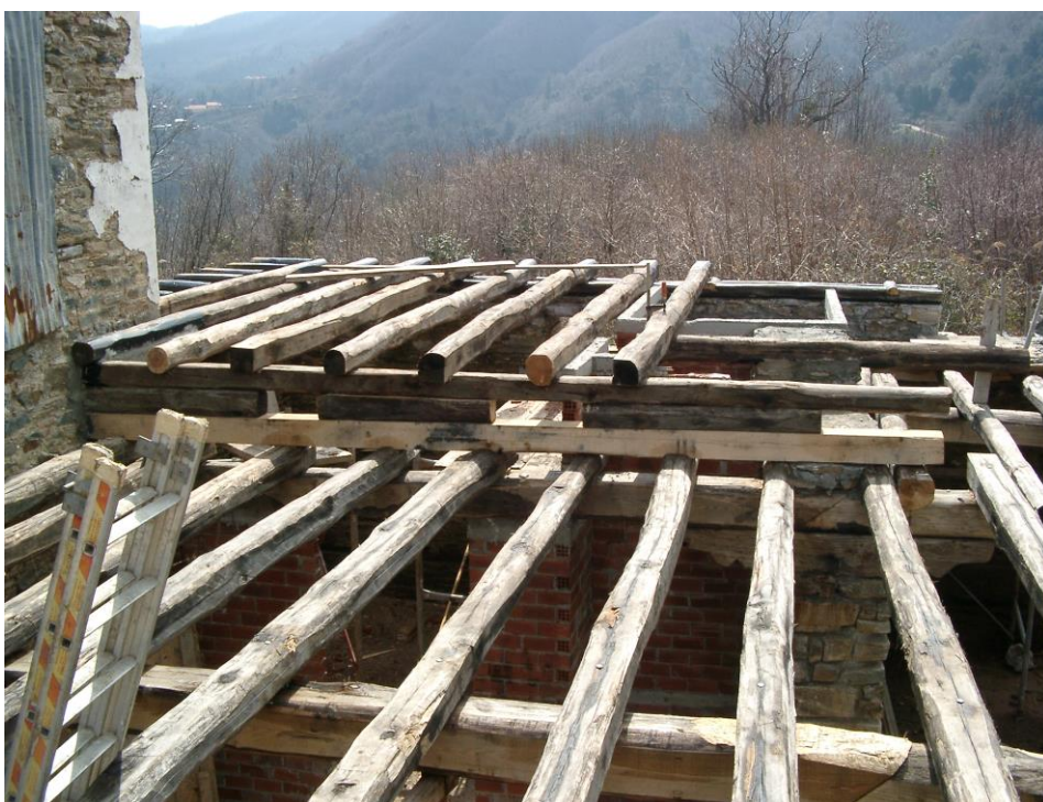
Φωτογραφία 37: Ξύλινοι σκελετοί πατωμάτων
