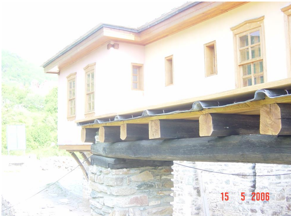
Φωτογραφία 187: Κατασκευή απλωταριάς
