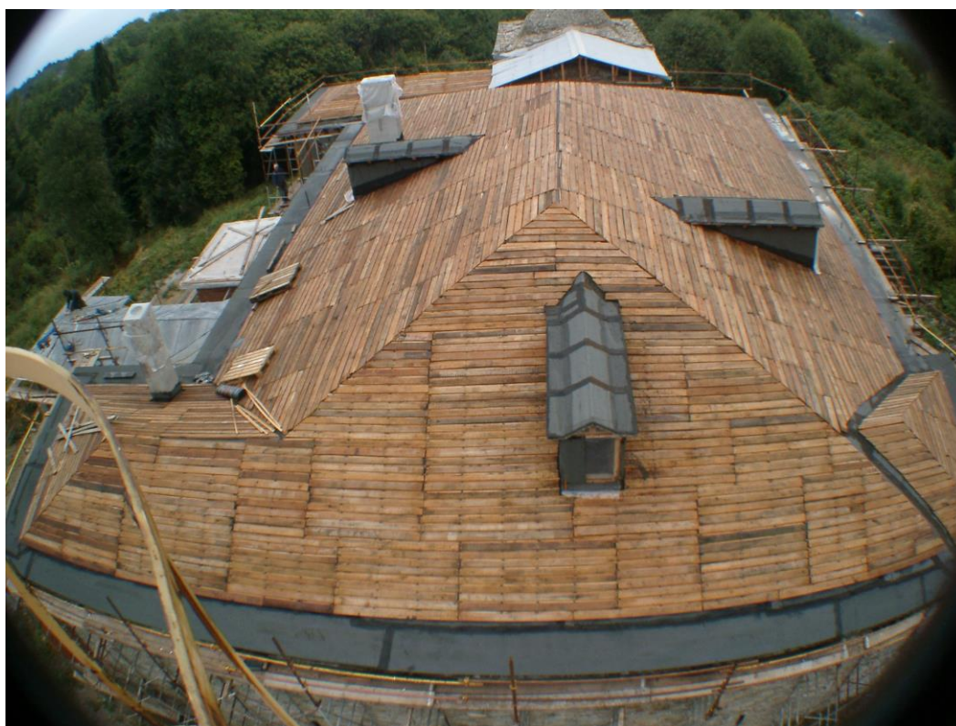
Φωτογραφία 73: Πέτσωμα στέγης ολοκληρωμένο
