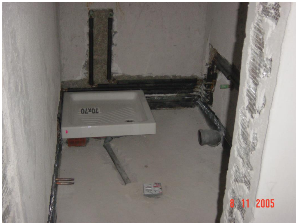
Φωτογραφία 104: Υδραυλική εγκατάσταση-Τοποθέτηση ειδών υγιεινής
