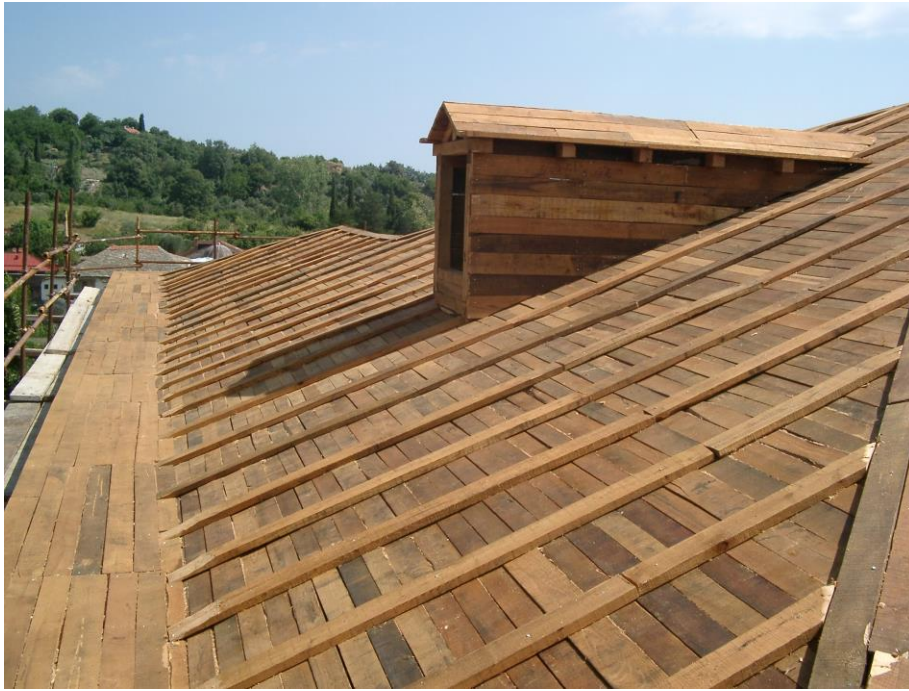
Φωτογραφία 66: Πέτσωμα στέγης (Πρώτο)-Φεγγίτης
