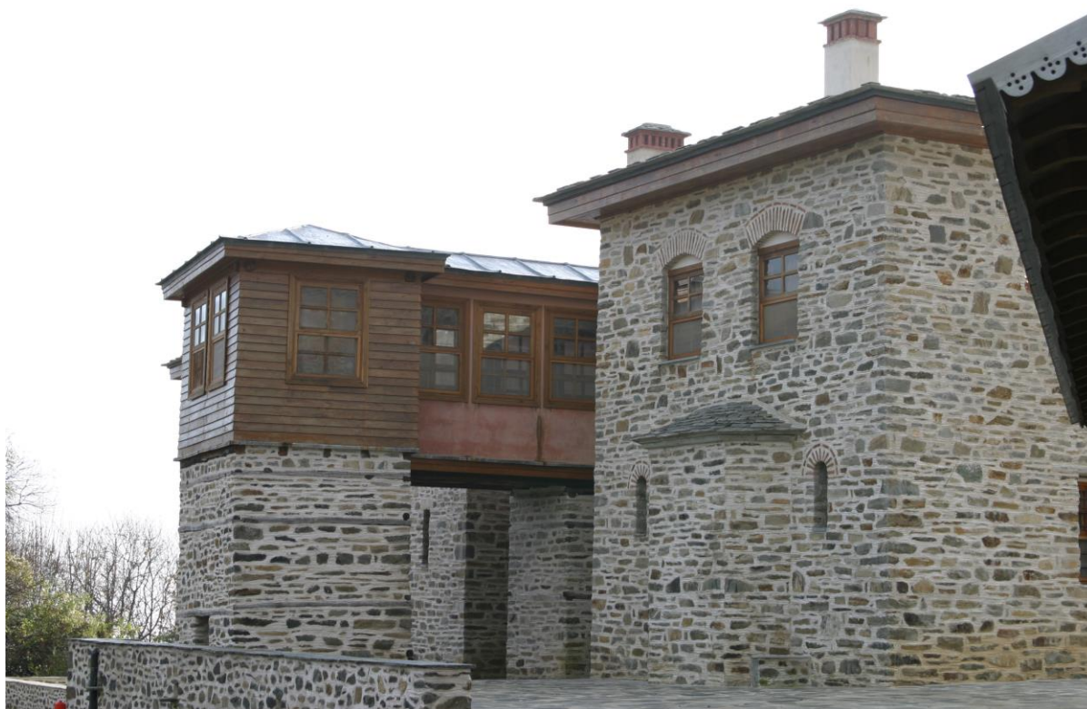
Φωτογραφία 210: Δυτική και Βόρεια όψεις του Αντιπροσωπείου (Ολοκληρωμένο)
