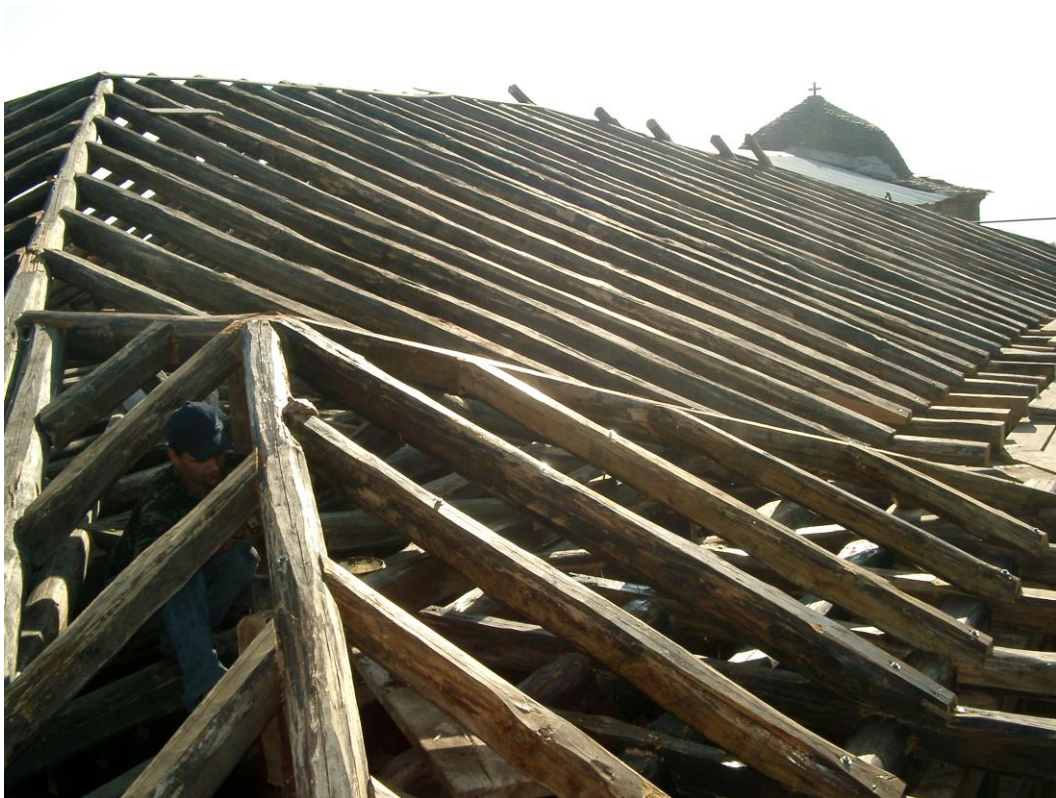
Φωτογραφία 63: Λεπτομέρεια ξύλινου σκελετού στέγης
