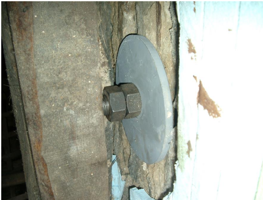
Φωτογραφία 119: Δίσκος στερέωσης μεταλλικού ελκυστήρα
