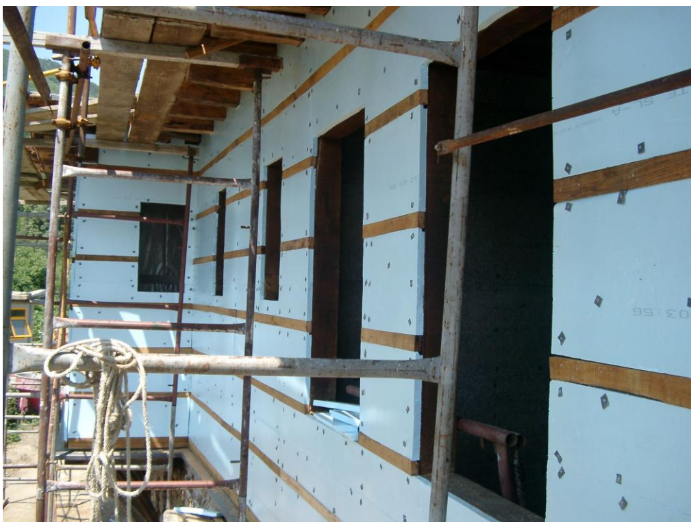
Φωτογραφία 92: Τοποθέτηση πλακών εξηλασμένης πολυστερόλης
