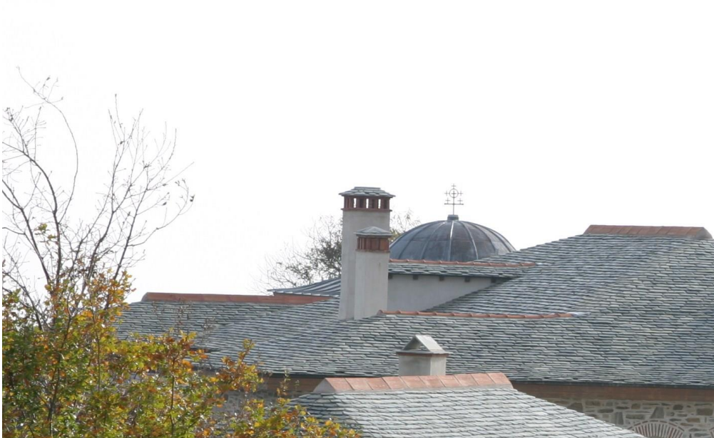
Φωτογραφία 85: Επικάλυψη στέγης εκκλησίας με φύλλο μολυβιού
