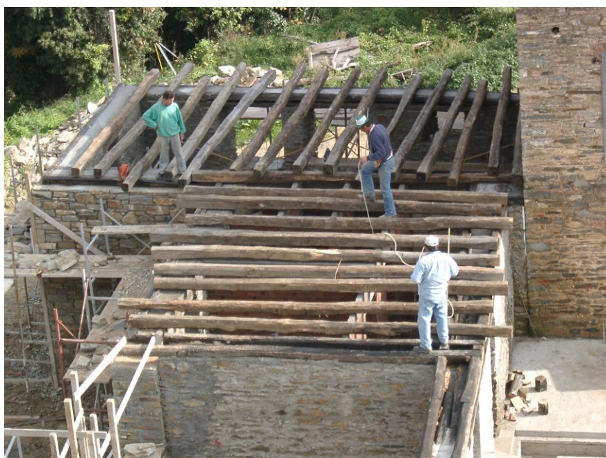
Φωτογραφία 35: Ξύλινοι σκελετοί πατωμάτων
