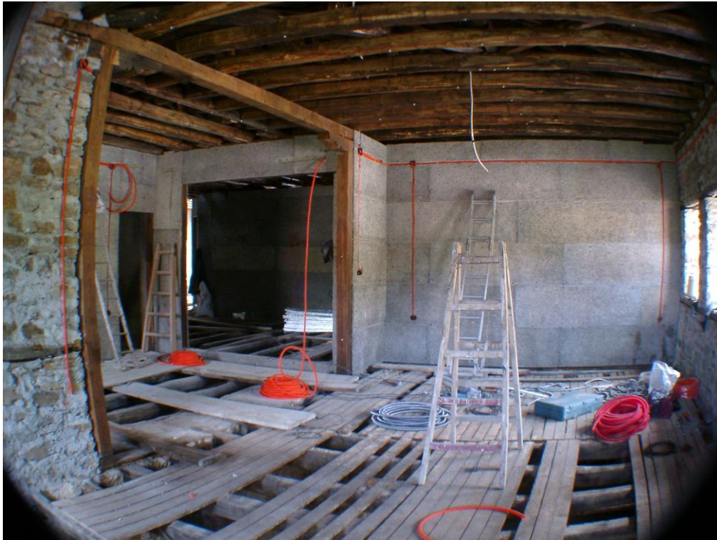
Φωτογραφία 89: Τοποθέτηση σωληνώσεων ηλεκτρολογικών
