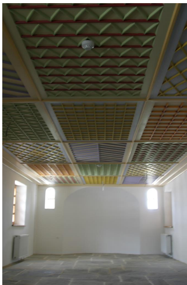
Φωτογραφία 199: Τράπεζα ισογείου (Ολοκληρωμένο)
