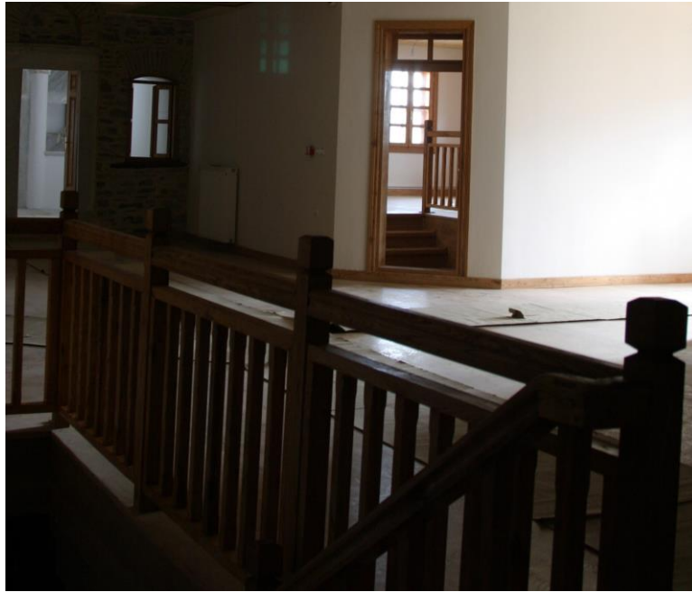
Φωτογραφία 160: Ξύλινο κιγκλίδωμα σκάλας
