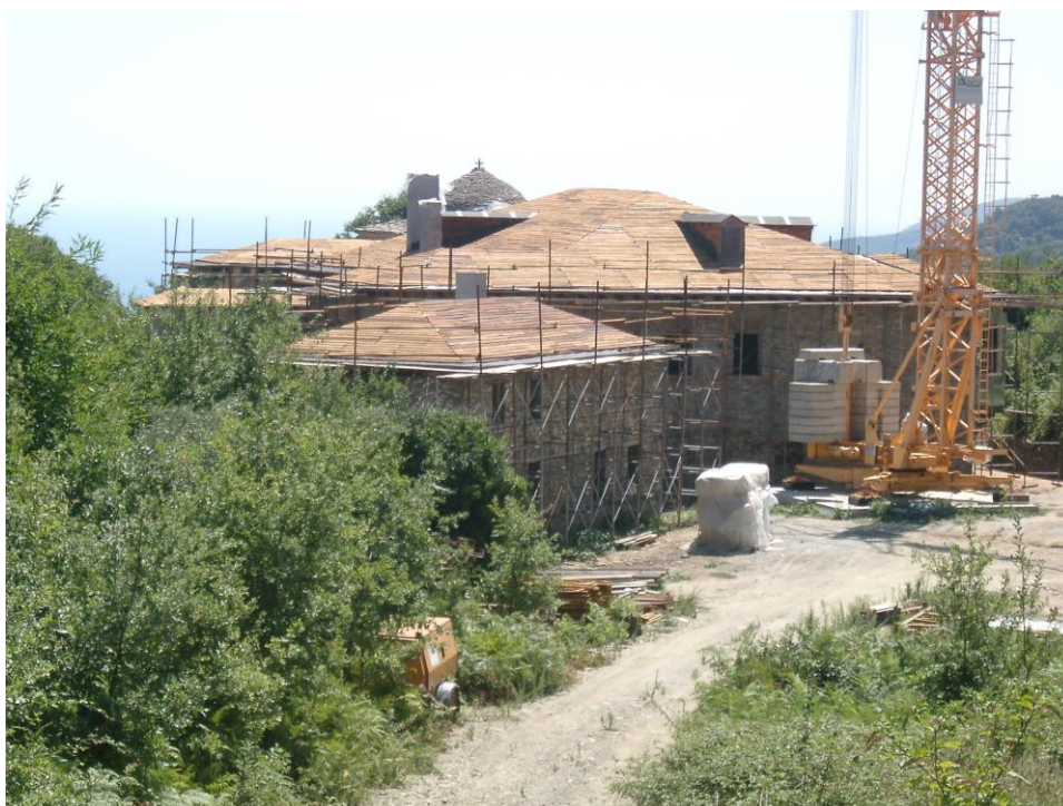
Φωτογραφία 74: Πετσώματα στεγών ολοκληρωμένα
