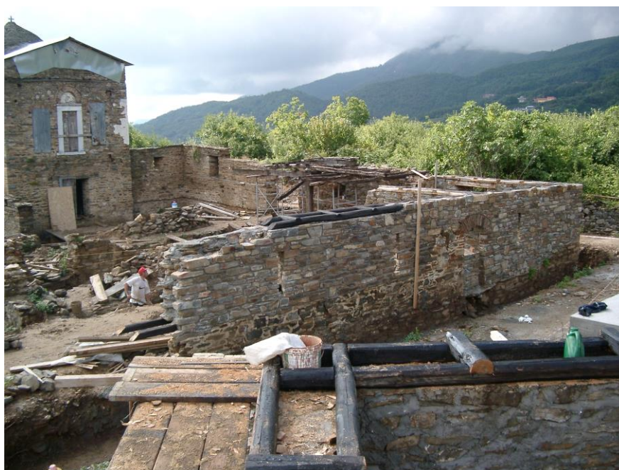
Φωτογραφία 31: Δομήσεις λιθοδομών-Ξύλινα σενάζ λιθοδομών
