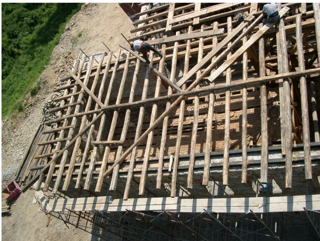
Φωτογραφία 55: Ξύλινος σκελετός στέγης
