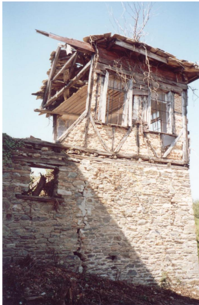
Φωτογραφία 12: Κατά την διάρκεια του καθαρισμού
