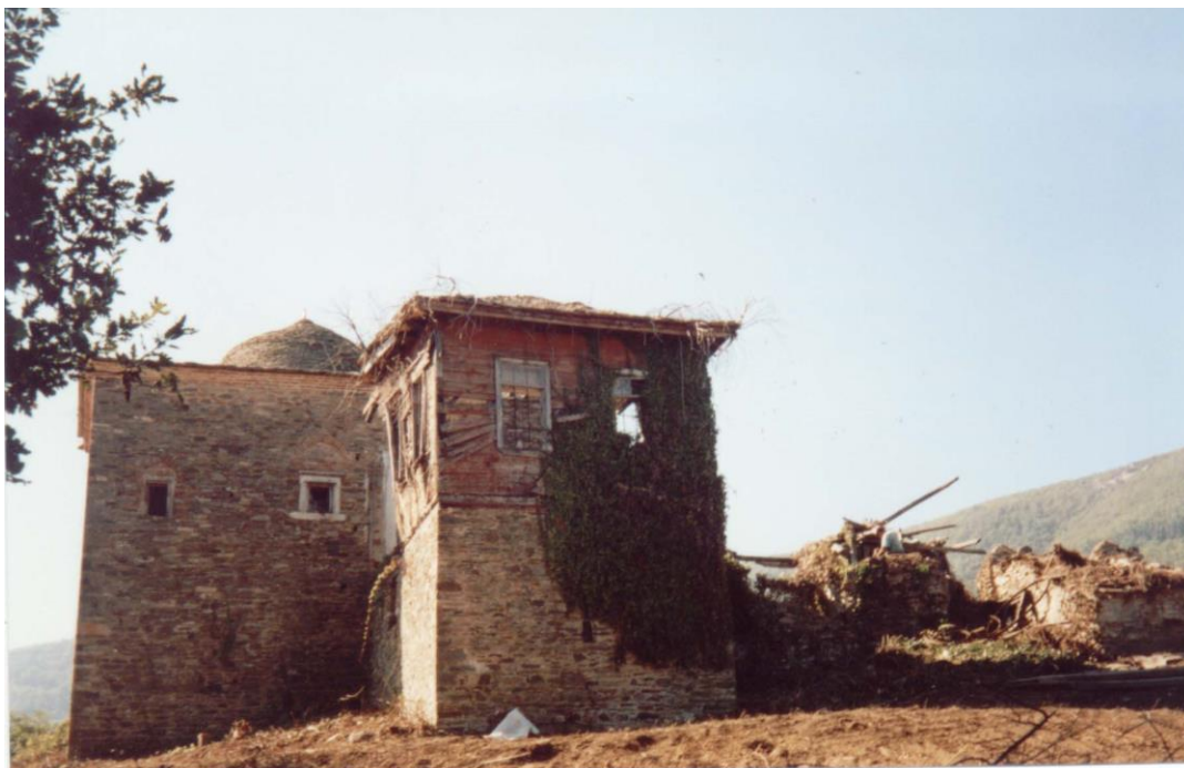
Φωτογραφία 13: Κατά την διάρκεια του καθαρισμού
