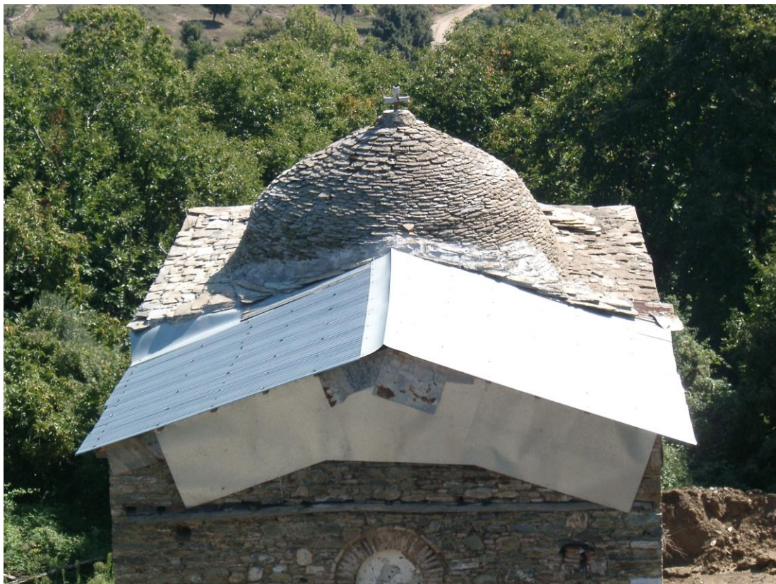
Φωτογραφία 16: Προστασία στέγης εκκλησίας
