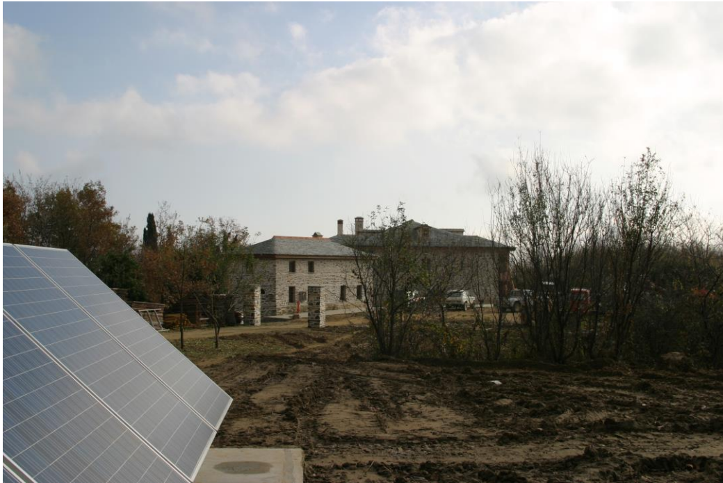
Φωτογραφία 180: Τοποθέτηση φωτοβολταϊκών πάνελ
