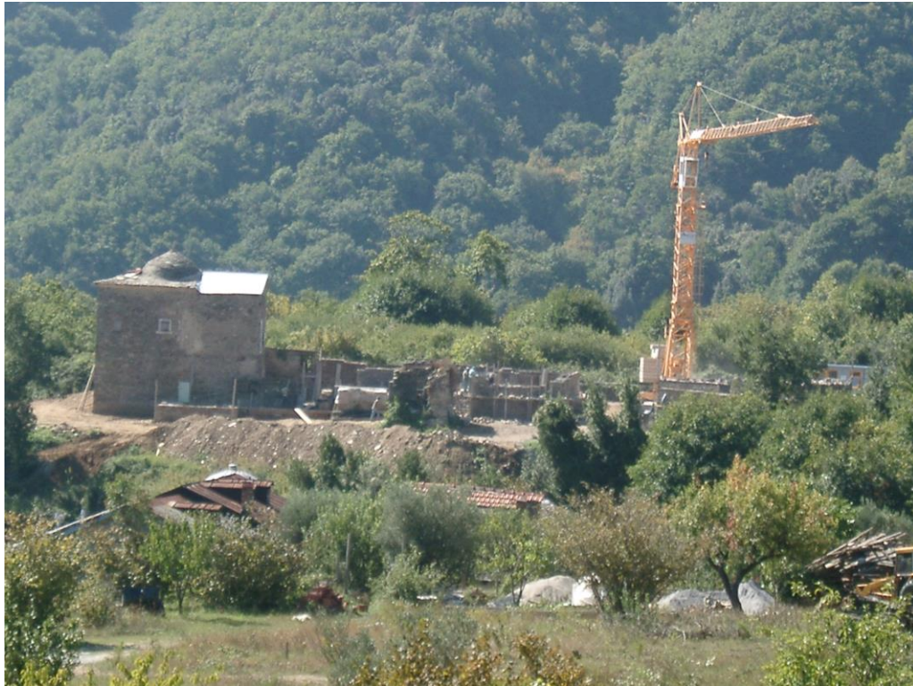
Φωτογραφία 21: Μετά τον καθαρισμό
