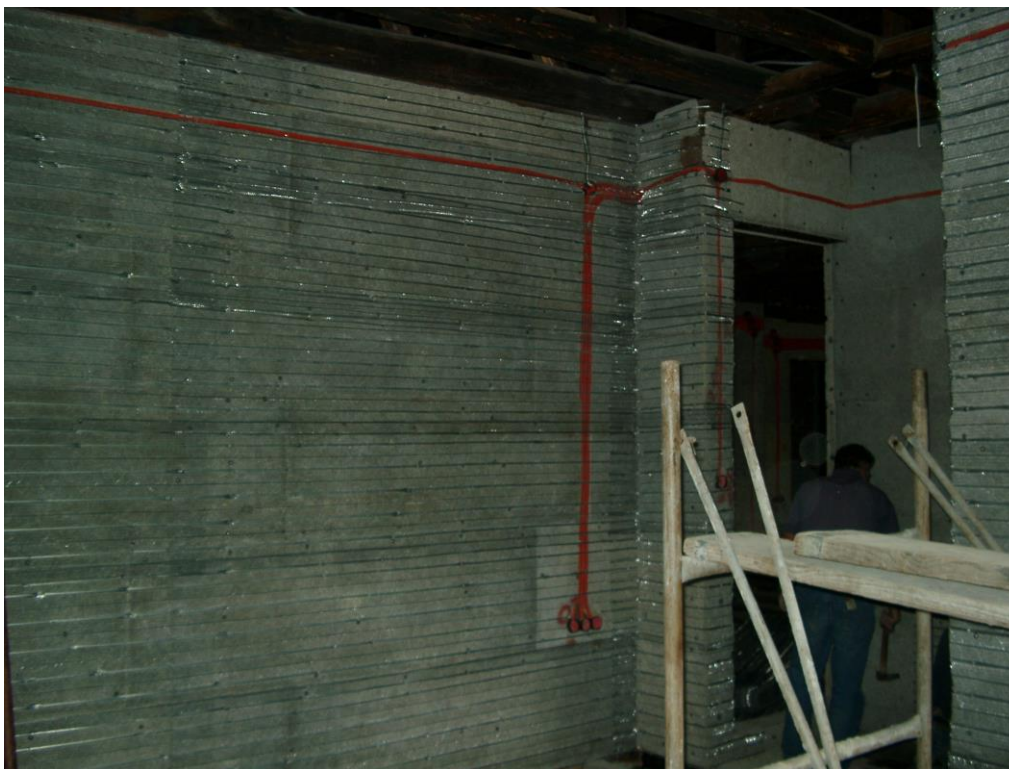
Φωτογραφία 90: Επένδυση τοίχων με νευρομετάλ
