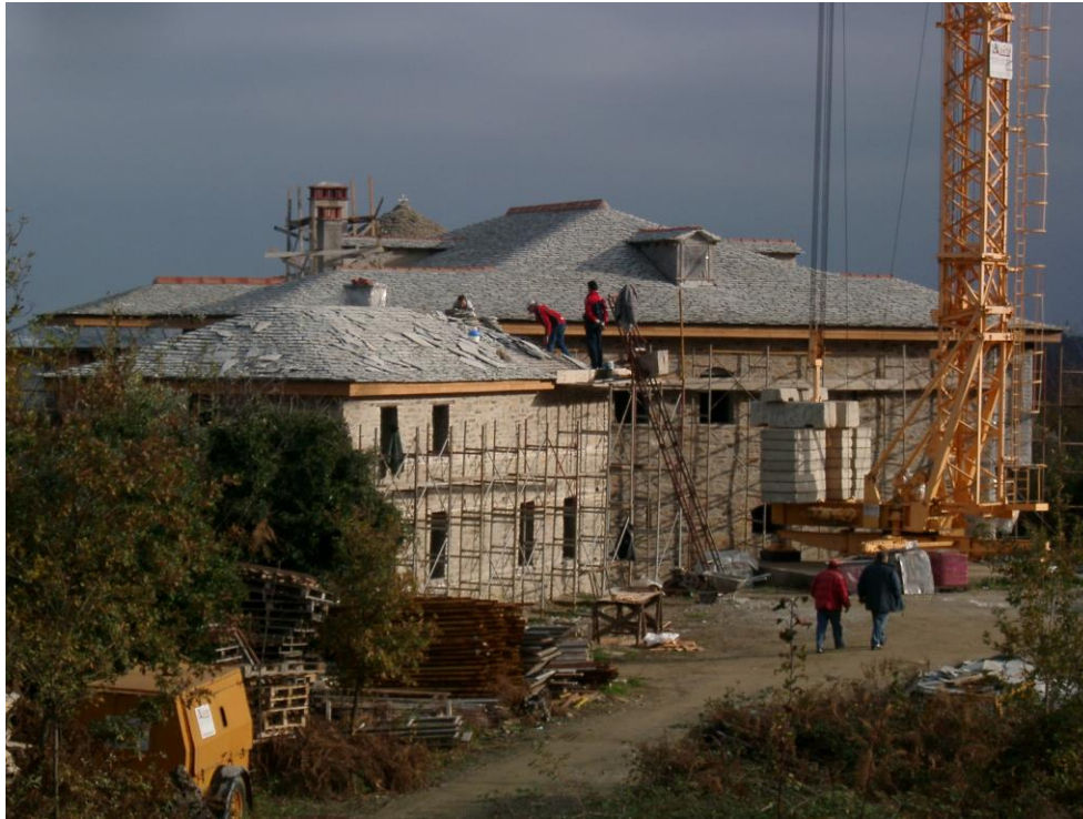
Φωτογραφία 82: Διάστρωση σχιστόπλακας στέγης (ολοκληρωμένη)
