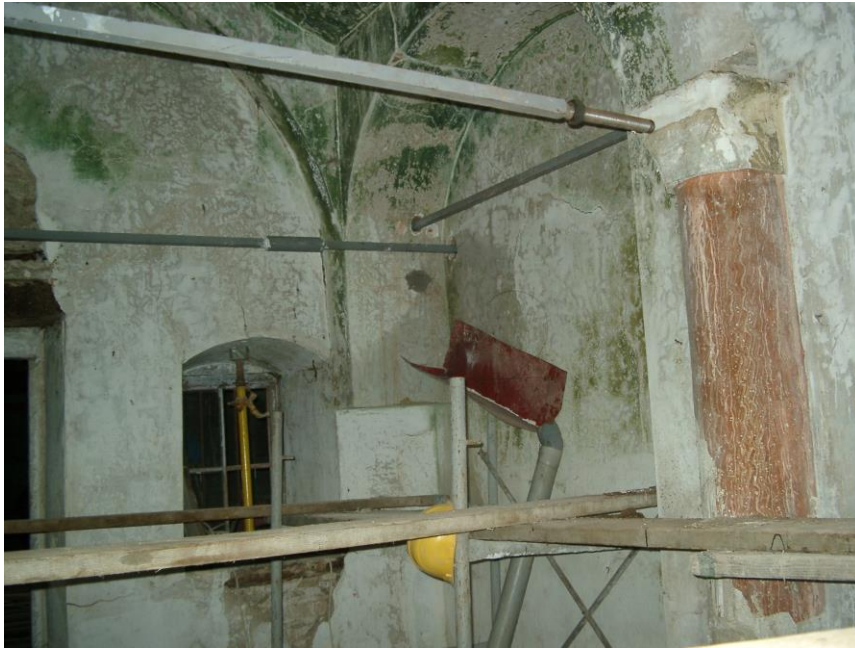
Φωτογραφία 118: Τοποθέτηση μεταλλικών ελκυστήρων
