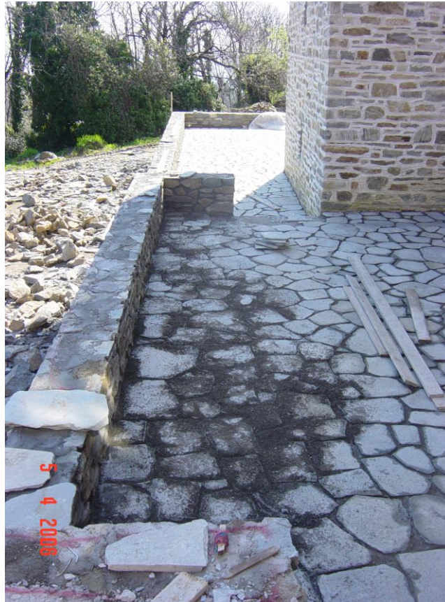
Φωτογραφία 172: Κατασκευή πεζουλιών-Διάστρωση σχιστόπλακας
