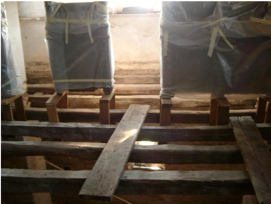
Φωτογραφία 113: Αποξήλωση ψευδοπατώματος
