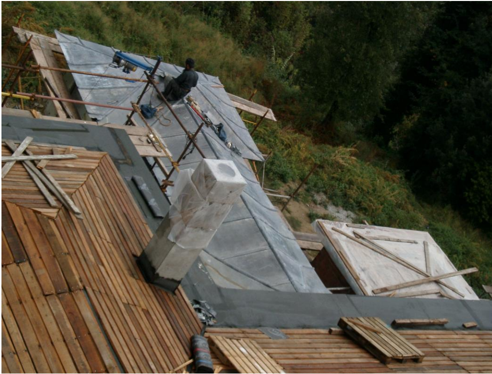
Φωτογραφία 83: Επικάλυψη στέγης με φύλλο μολυβιού
