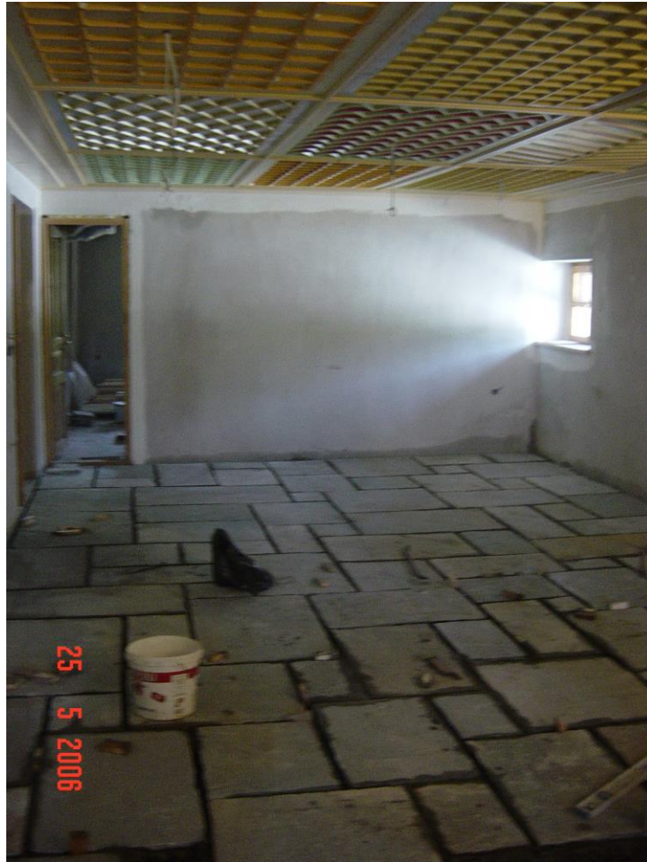
Φωτογραφία 157: Διάστρωση δαπέδου με σχιστόπλακα
