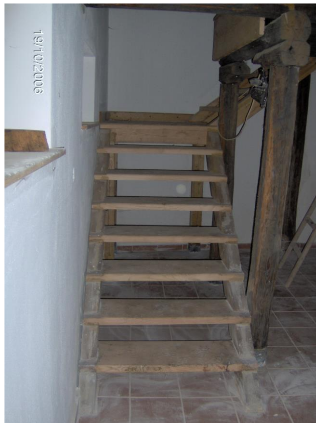
Φωτογραφία 159: Κατασκευή ξύλινης σκάλας
